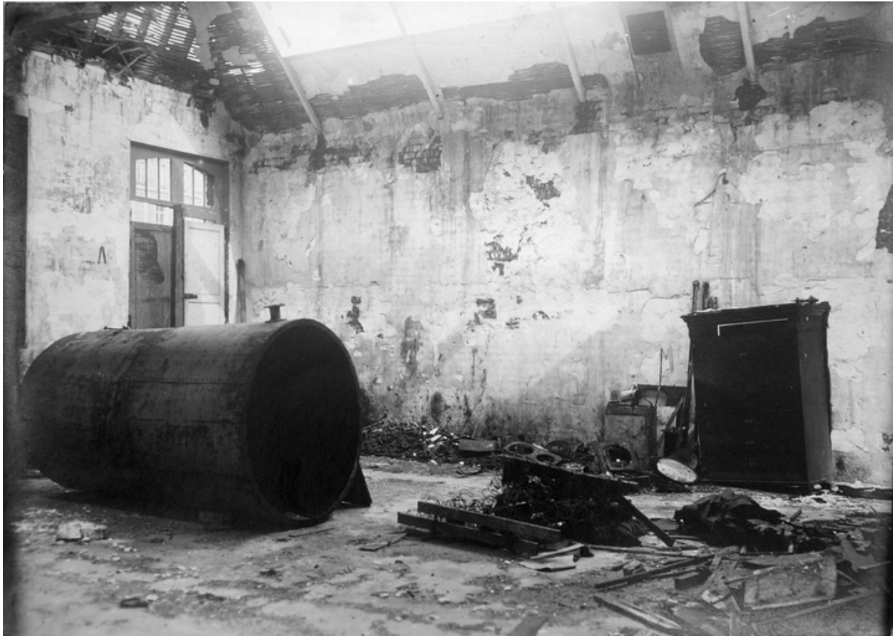
Vue intérieure du petit atelier acquis en 1912, photographié en 1918-1919 (AD Aisne).
