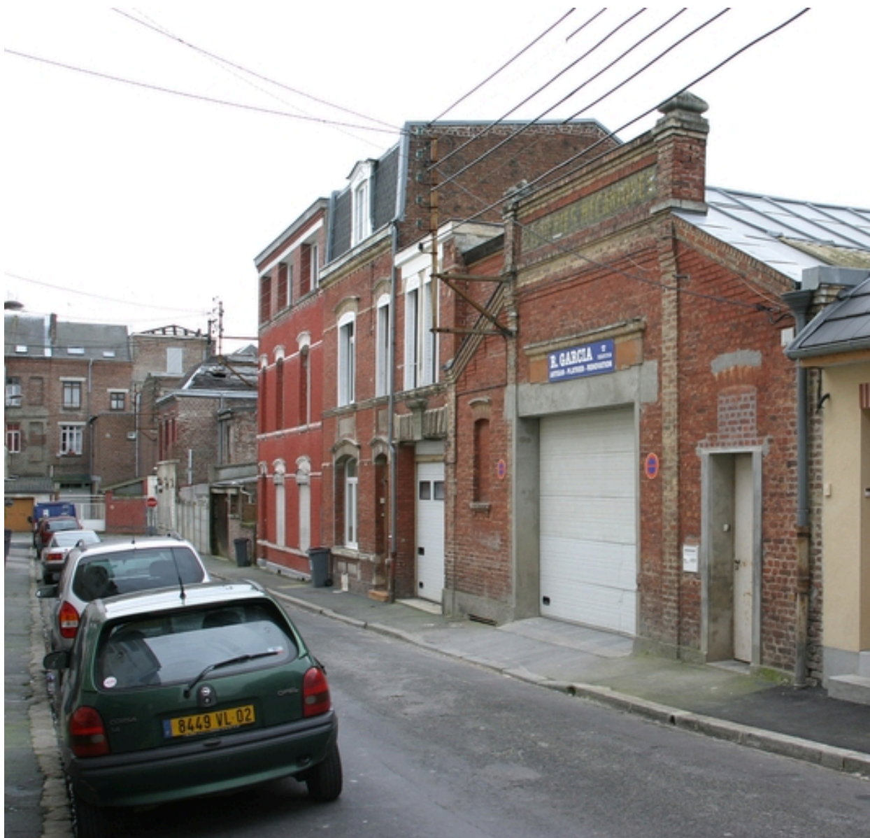
Façade de l'habitation et des ateliers, rue du Labeur.
