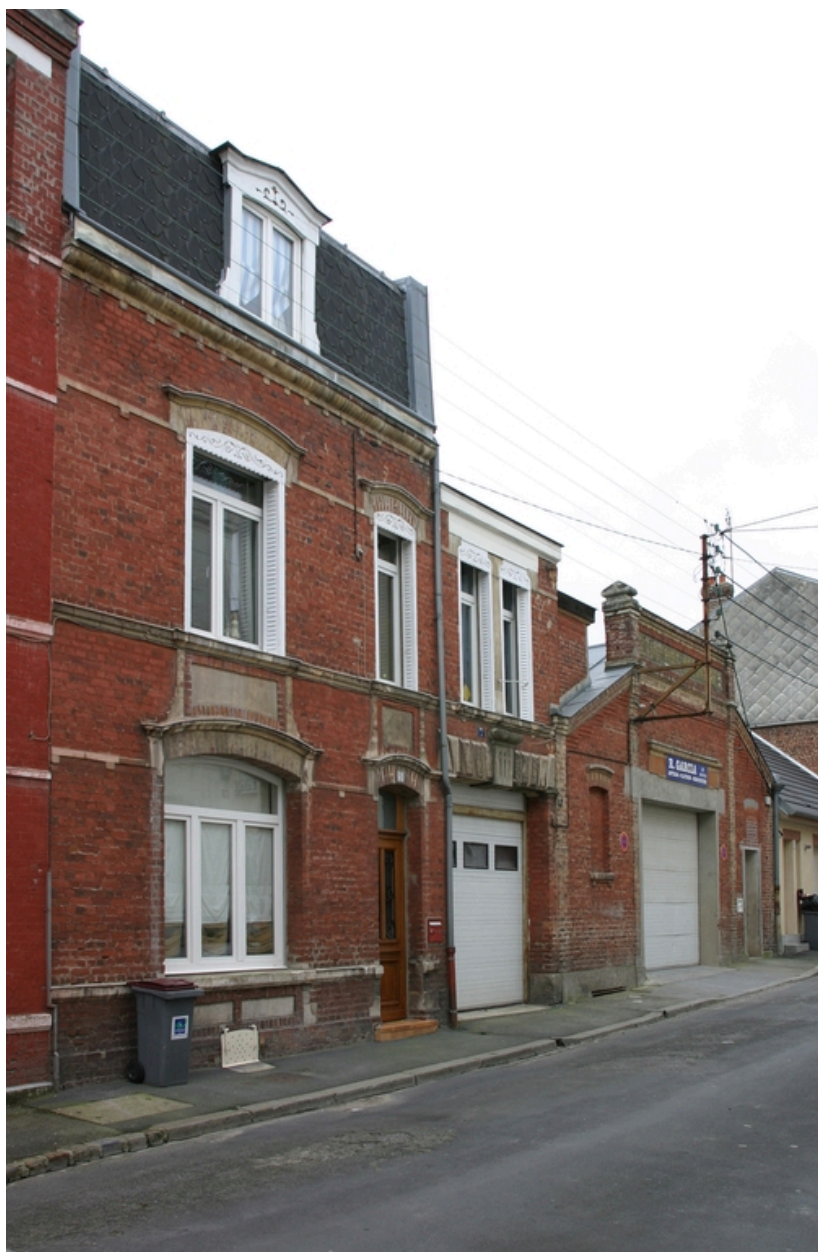
Façade de l'habitation et des ateliers, rue du Labeur.
