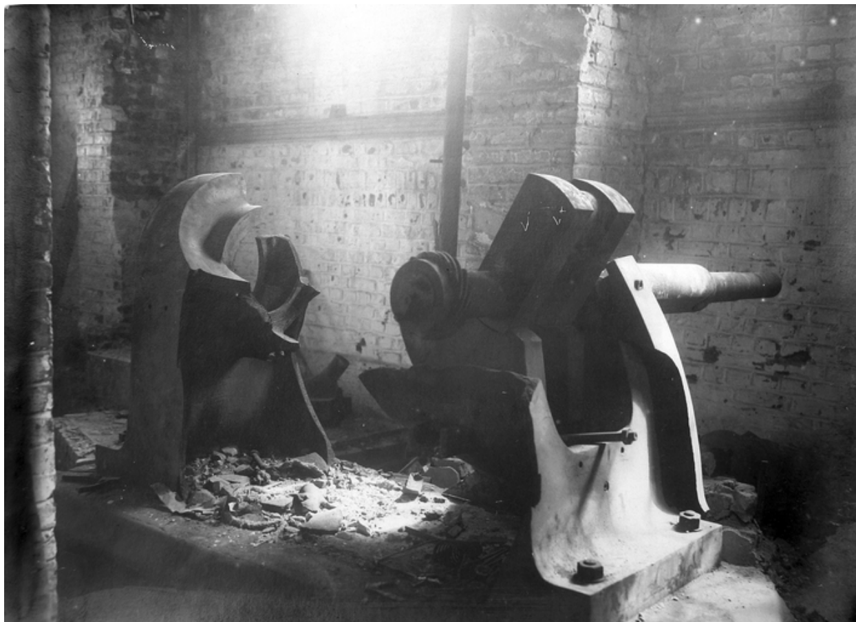
Vestiges de l'un des deux moteurs à gaz de l'usine, 1918-1919 (AD Aisne).
