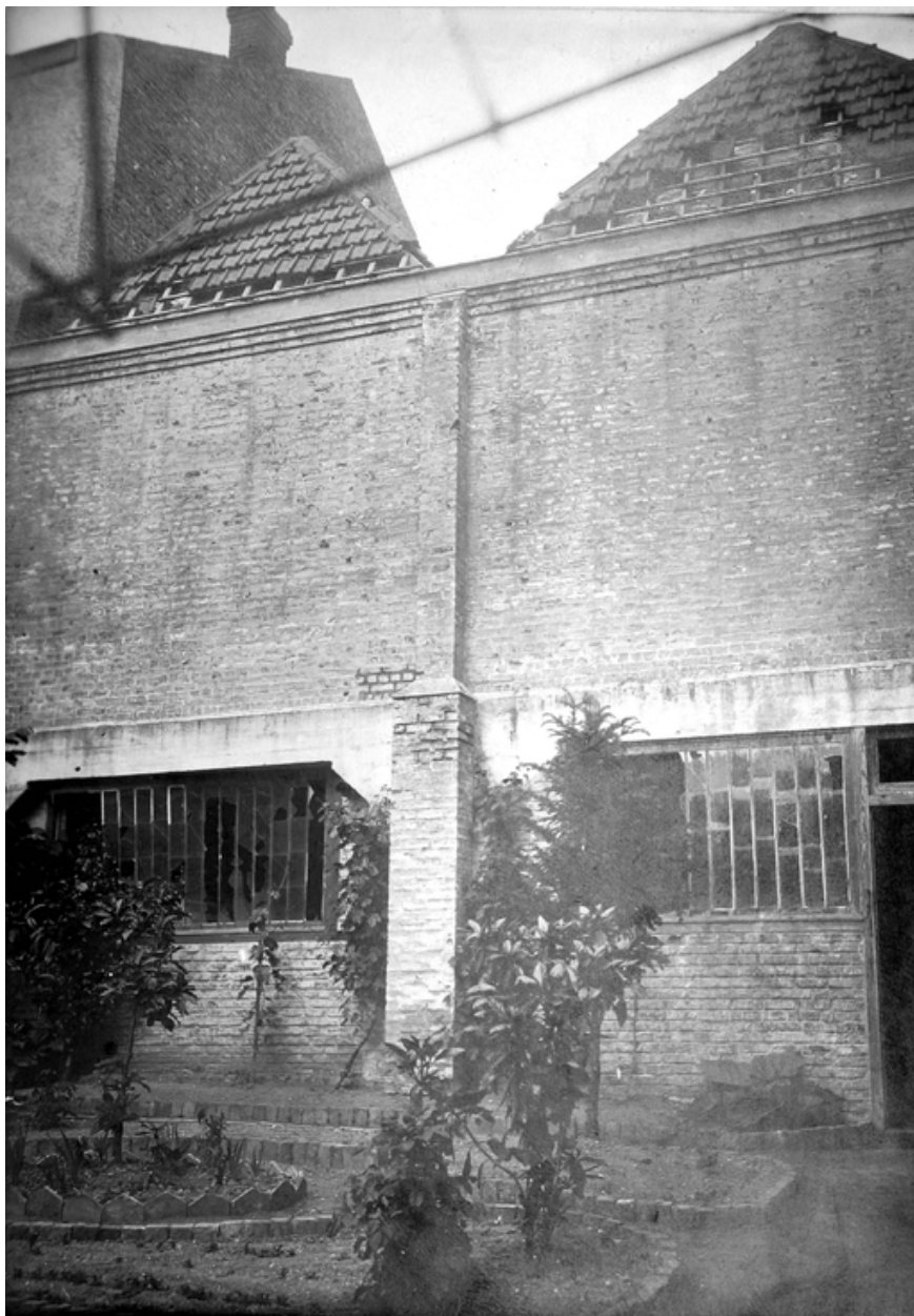
Façade postérieure des ateliers acquis en 1912, photographiée en 1918-1919 (AD Aisne).
