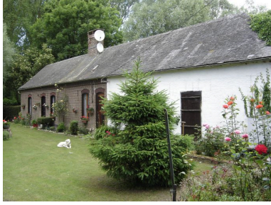
Vue générale. Phot. Inès Guérin IVR22_20058006106NUCA
