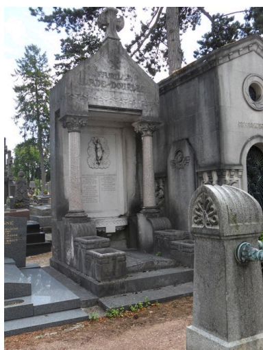
Plaine A (432). Tombeau niche, réalisé par l'entrepreneur Lamolet vers 1929. Phot. Isabelle Barbedor IVR22_20098010007NUCA
