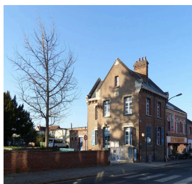
La conciergerie, vue depuis la rue de Cagny. Phot. Isabelle Barbedor IVR32_20168006447NUCA
