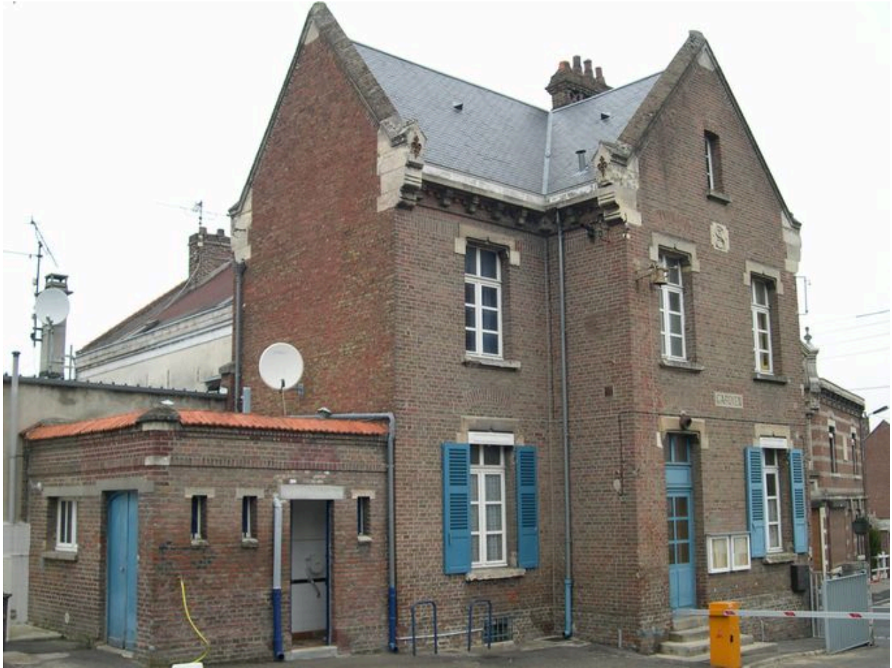
La conciergerie, vue depuis le sud-ouest.
