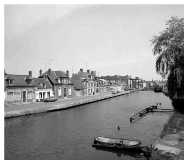
Canal et quai des Bateliers. Phot. Jean-Michel Périn IVR22_19856000855X
