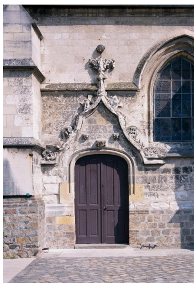
Détail sur le portail. Phot. Thierry Lefébure IVR22_20038000465XA
