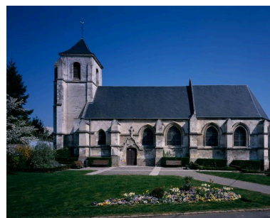
Vue générale. Phot. Thierry Lefébure IVR22_20038000390VA
