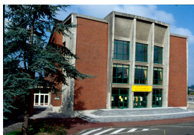
Salle des fêtes d'Hautmont. Phot. Olivier Marlard IVR31_19955901118ZA
