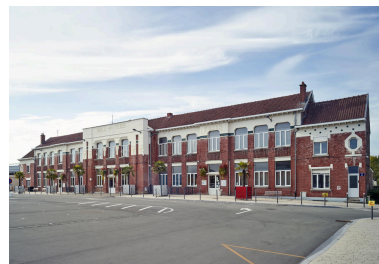
Groupe scolaire et salle des fêtes de Recquignies. Phot. Pierre Thibaut IVR32_20225900166NUCA
