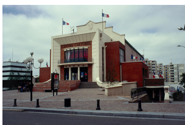
Centre culturel André Malraux à Jeumont. Phot. Sophie Luchier IVR31_19955901296ZA
