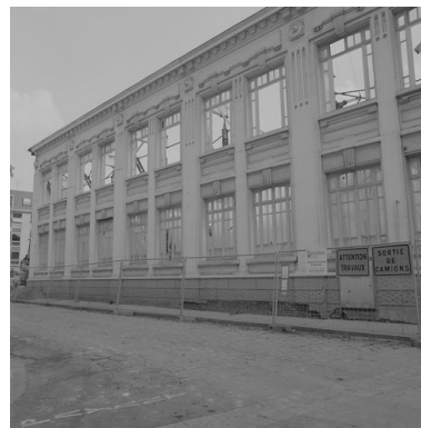
Vue de l'élévation latérale en cours de destruction. Phot. Thierry Lefébure IVR22_19978000824X
