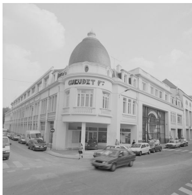
Vue générale. Phot. Thierry Lefébure IVR22_19978000821X
