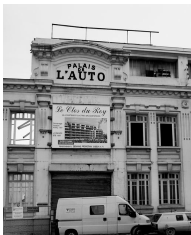
Vue d'une entrée latérale en cours de destruction portant l'inscription PALAIS DE L'AUTO. Phot. Thierry Lefébure IVR22_19978000823X
