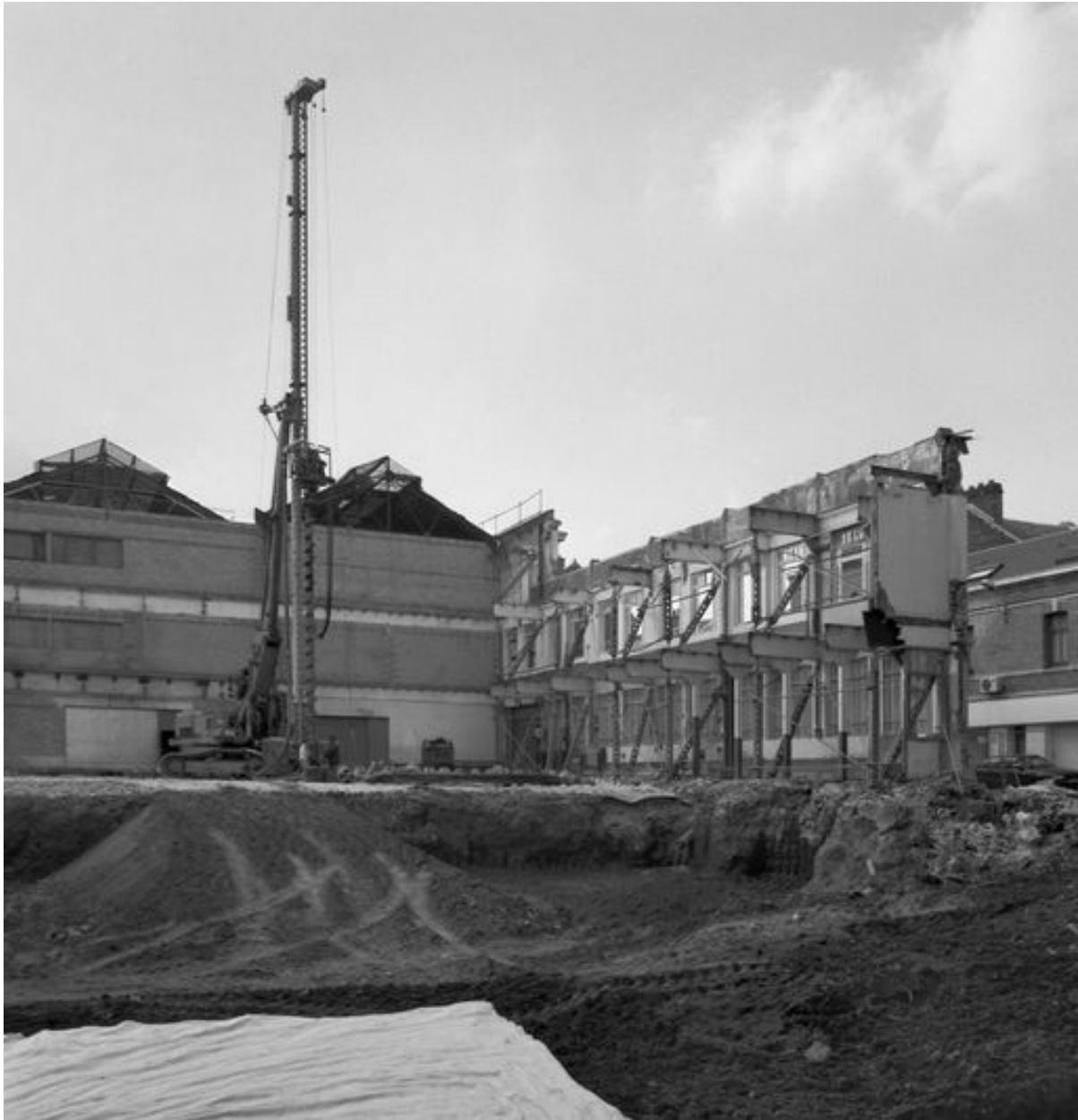
Vue des travaux de destruction du garage Gueudet ne conservant que la façade latérale.
