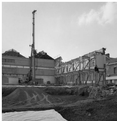
Vue des travaux de destruction du garage Gueudet ne conservant que la façade latérale. Phot. Thierry Lefébure IVR22_19978000822X
