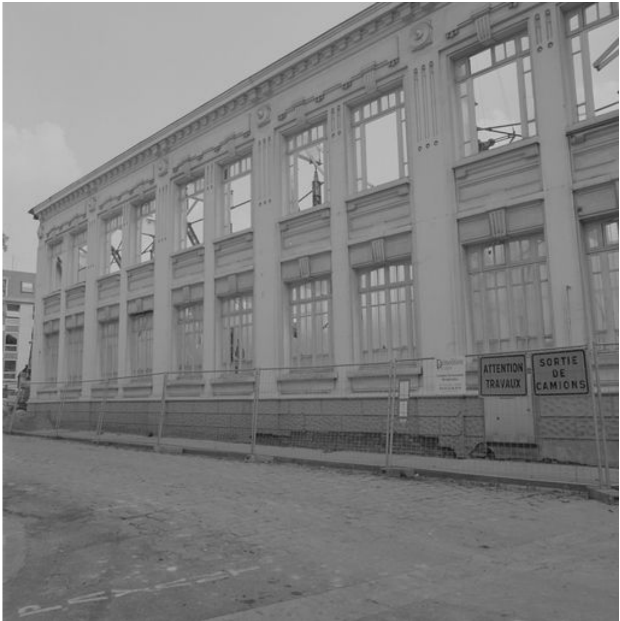
Vue de l'élévation latérale en cours de destruction.
