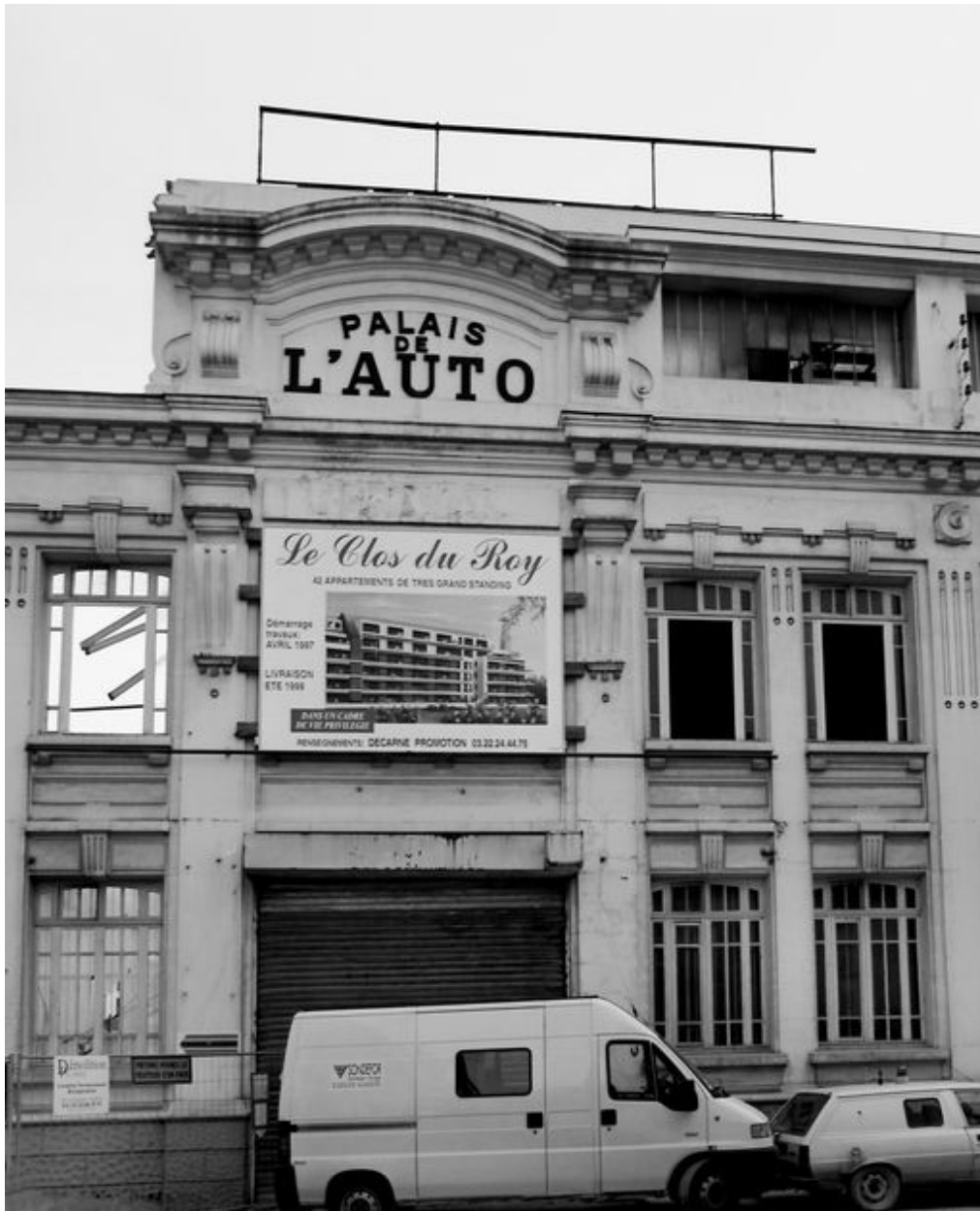
Vue d'une entrée latérale en cours de destruction portant l'inscription PALAIS DE L'AUTO.
