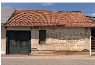
Ancienne grange sur rue avec porte à engranger, n°7 rue des Hayes, vue depuis le sud-est. Phot. Marc Kérignard IVR32_20226000325NUCA
