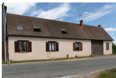
Logis sur rue avec entrée charretière, n°17 rue Tassart, vue depuis le sud-ouest. Phot. Marc Kérignard IVR32_20226000330NUCA
