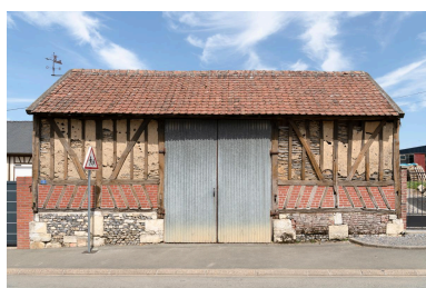
Ancienne grange sur rue, n°1 rue Tassart, vue depuis le sud-ouest. Phot. Marc Kérignard IVR32_20226000329NUCA
