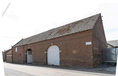
Grange et étable sur rue avec entrée charretière, porte la date de 1866, n°23 rue Notre-Dame, vue depuis le nord-ouest. Phot. Marc Kérignard IVR32_20226000386NUCA
