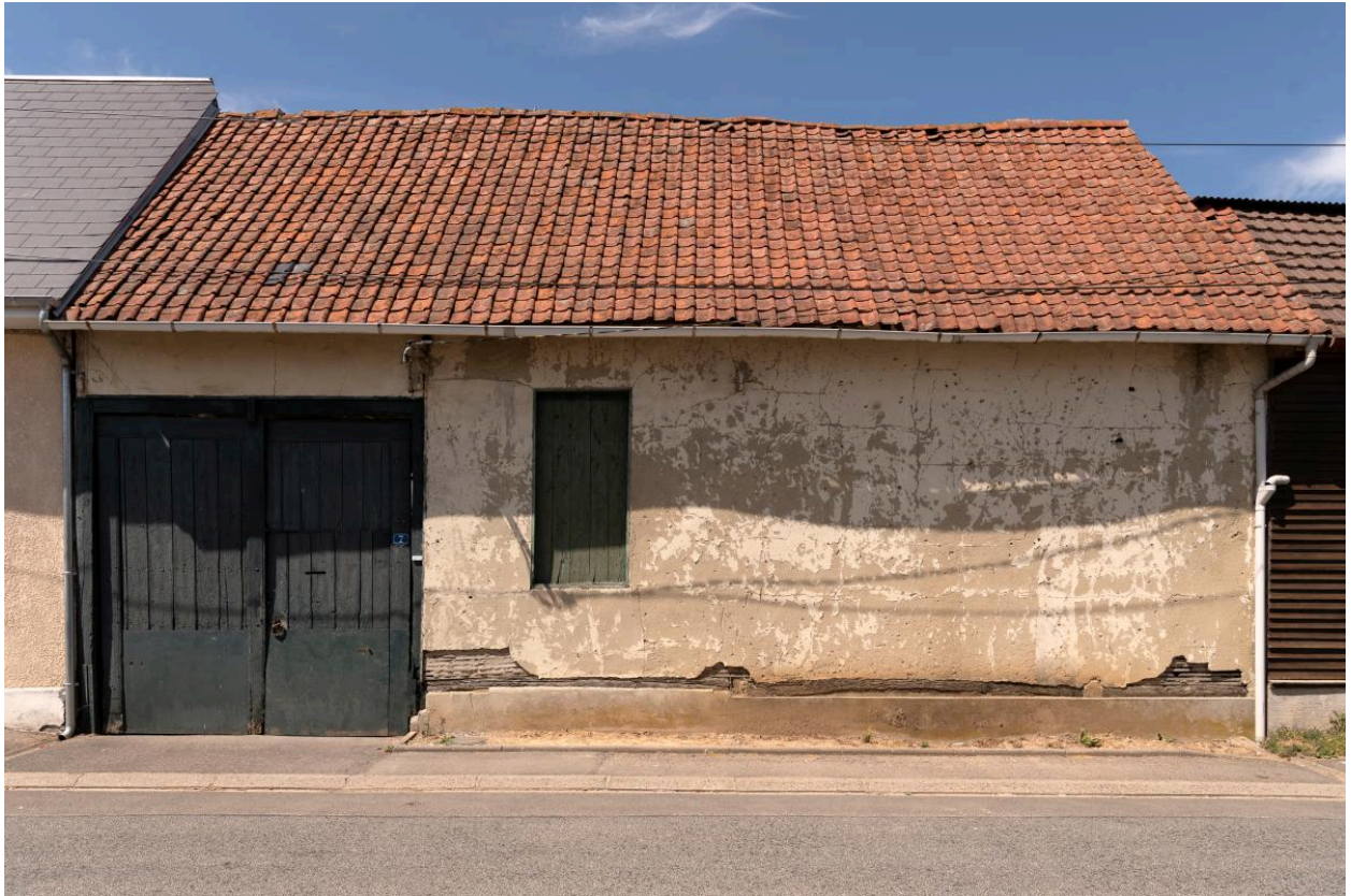
Ancienne grange sur rue avec porte à engranger, n°7 rue des Hayes, vue depuis le sud-est.
