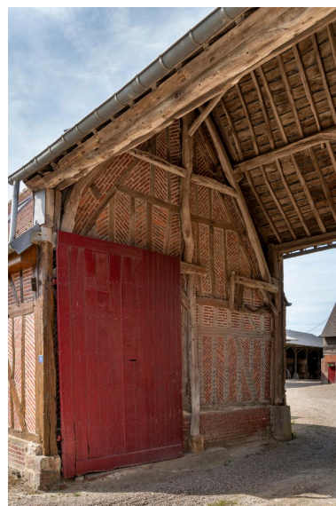
Détail de la mise en œuvre de la charpente de l'entrée charretière, n°10 rue Tassart. Phot. Marc Kérignard
