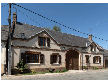
Ancien commerce (?), n°6 rue Tassart, vue depuis le nord-est. Phot. Marc Kérignard IVR32_20226000723NUCA
