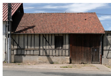
Ancienne grange sur rue avec porte à engranger, n°29 rue des Hayes, vue depuis le sud-est. Phot. Marc Kérignard IVR32_20226000327NUCA
