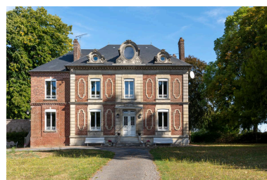
Maison du propriétaire de la ferme du Tilloy, n°2 rue Notre-Dame, vue depuis le sud. Phot. Marc Kérignard IVR32_20226000896NUCA
