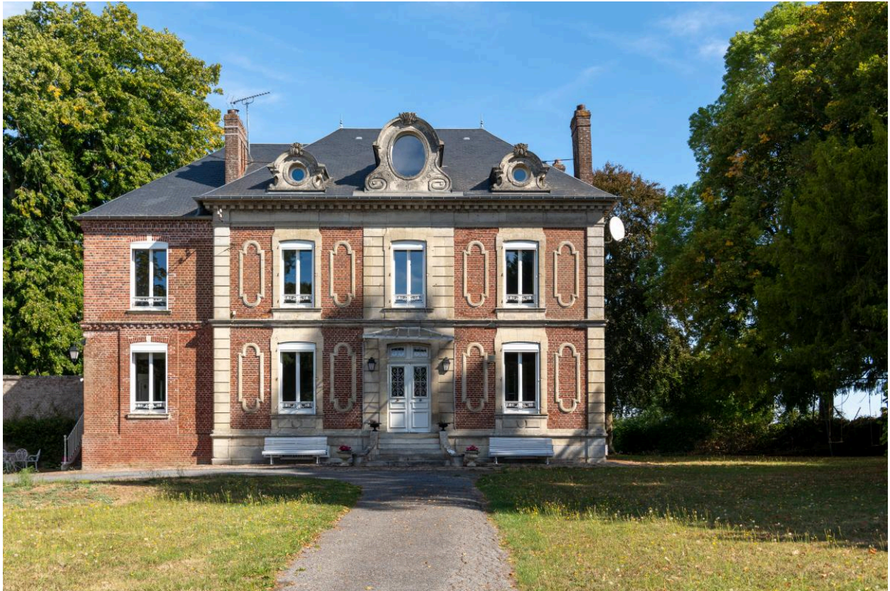
Maison du propriétaire de la ferme du Tilloy, n°2 rue Notre-Dame, vue depuis le sud.
