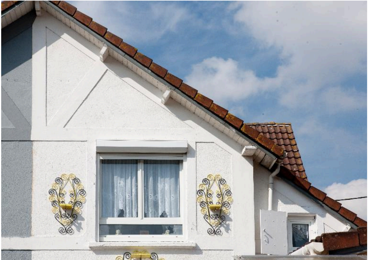
Façade de la maison sur cour, détail.
