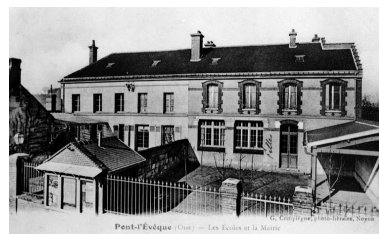
Élévation antérieure, avant 1914 (AP). Phot. Jean-Michel Périn IVR22_19856000262XB
