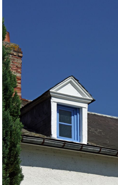
Détail de la lucarne en bâtière. Phot. Bertrand Fournier IVR22_20098005152NUCA
