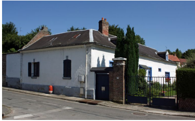
Vue d'ensemble sur rue. Phot. Bertrand Fournier IVR22_20098005151NUCA
