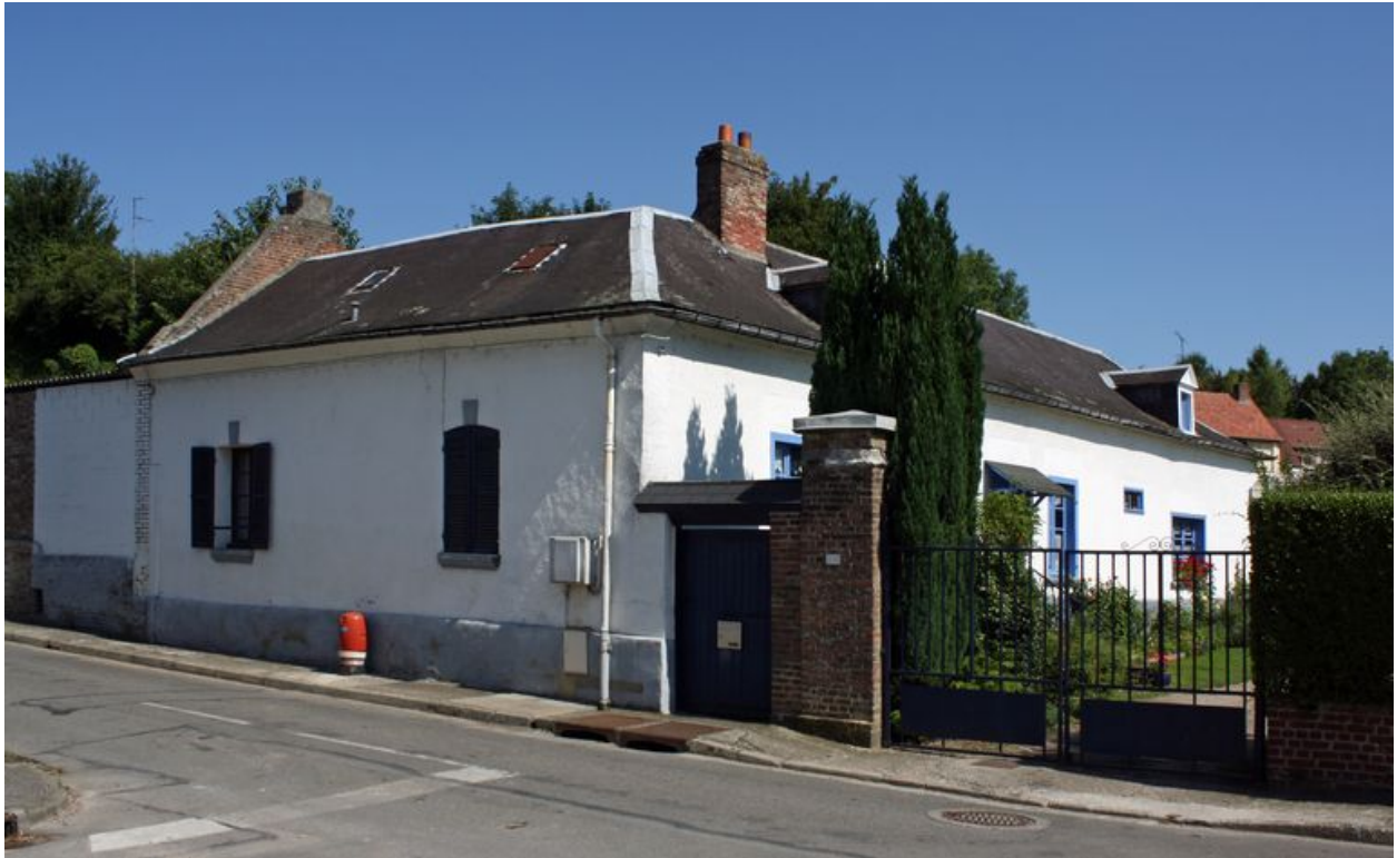
Vue d'ensemble sur rue.
