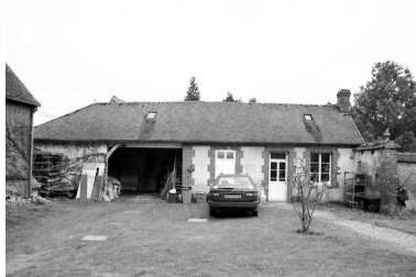
Anciennes remise et étable transformées en atelier de fabrication.
