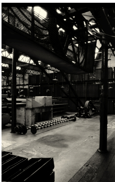
Détail des transmissions, 1988. Phot. Benoît Dufournier IVR22_19880201692Z
