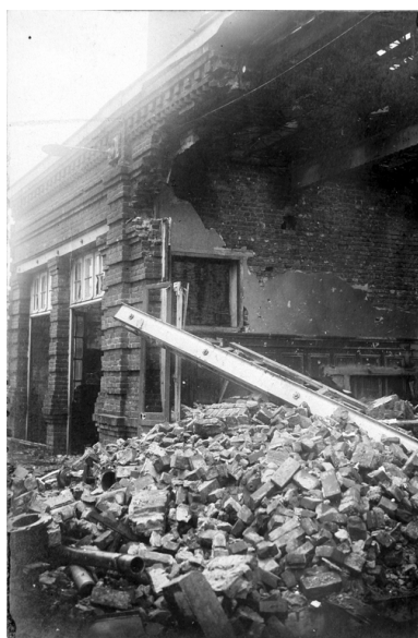
La façade du bureau du contremaître, complètement détruite pendant la Première Guerre mondiale (AD Aisne). Phot. Pillet Frédéric IVR22_20040200927NUCAB
