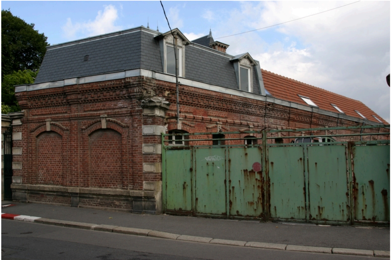
Conciergerie, communs du logement patronal et entrée de l'usine).
