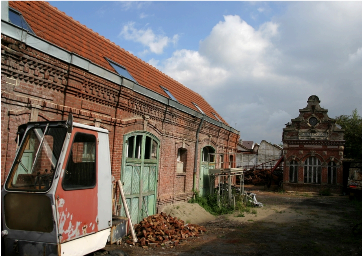
Façade des communs du logement patronal, et façade des bureaux.
