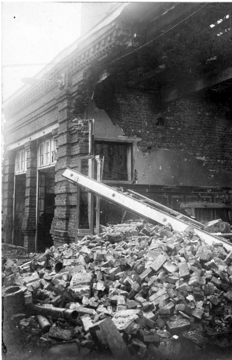
La façade du bureau du contremaître, complètement détruite pendant la Première Guerre mondiale (AD Aisne).
