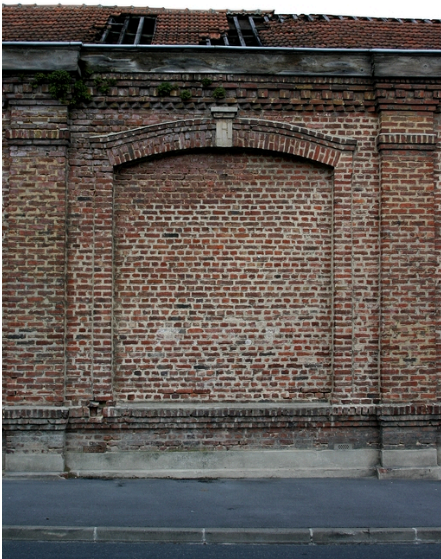
Une travée de la façade aveugle des magasins, rue Sommières.
