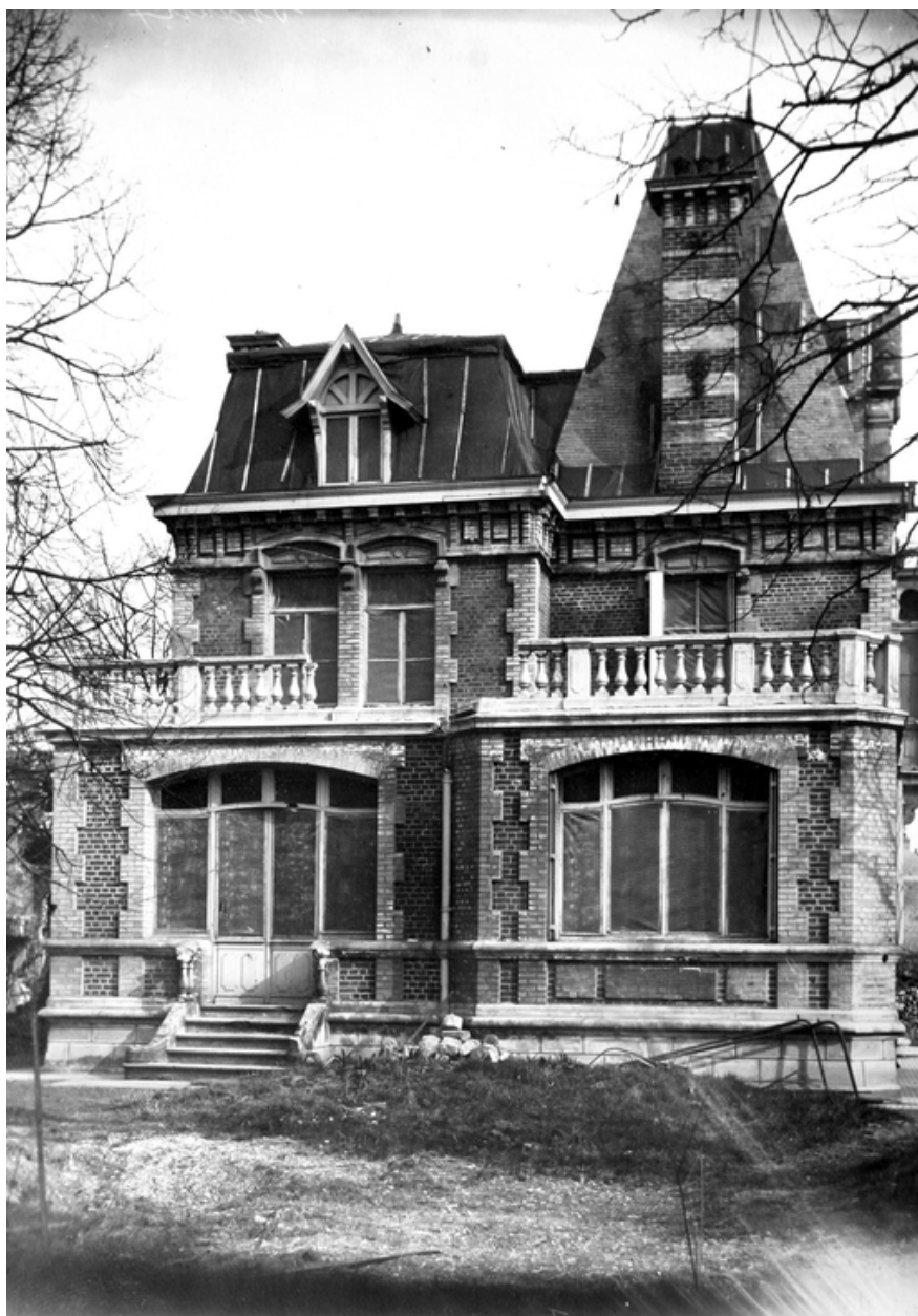
Le logement patronal en cours de restauration, vers 1919 (AD Aisne).
