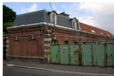
Conciergerie, communs du logement patronal et entrée de l'usine). Phot. Frédéric Pillet IVR22_20040200936NUCA
