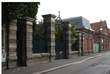
Le site de l'usine Sidoux, rue Camille-Desmoulins. Phot. Frédéric Pillet IVR22_20040200935NUCA
