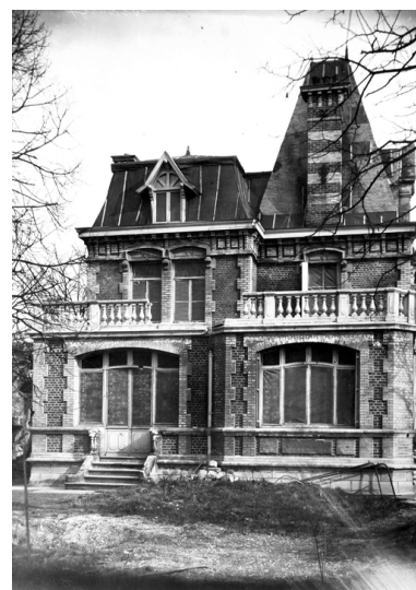
Le logement patronal en cours de restauration, vers 1919 (AD Aisne). Phot. Pillet Frédéric IVR22_20040200929NUCAB
