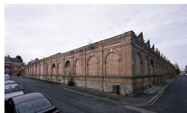
Façade des ateliers de cylindrage et bordage, de la passementerie et des ateliers de tissage, rue Poëtte. Phot. Thierry Lefébure IVR22_20070200058PA
