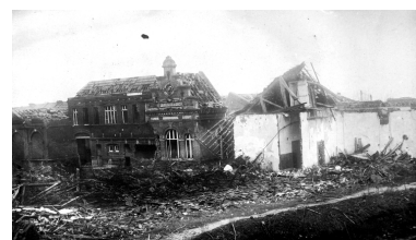
L'usine vue depuis l'angle de la rue Camille-Desmoulins et de la rue Sommières après la Première Guerre mondiale : au centre, le pignon des bureaux (AD Aisne). Phot. Pillet Frédéric IVR22_20040200923NUCAB
