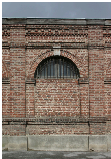
Une travée des ateliers de cylindrage et bordage, rue Sommières.
