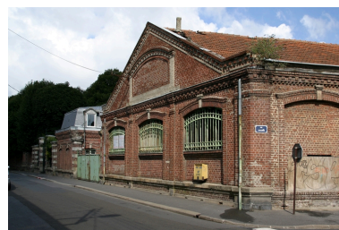
Magasins et entrée de l'usine, vus depuis l'angle des rues Camille-Desmoulins et Sommières. Phot. Frédéric Pillet IVR22_20040200942NUCA
