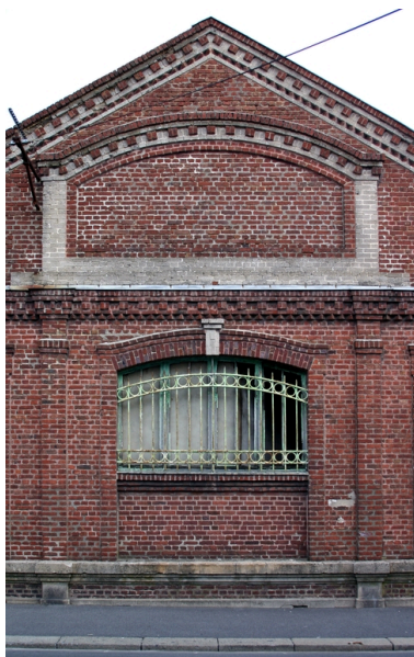
Magasins reconstruits en 1919-1920 : détail du pignon. Phot. Frédéric Pillet IVR22_20040200941NUCA
