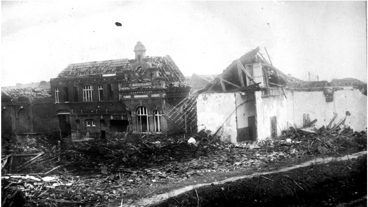
L'usine vue depuis l'angle de la rue Camille-Desmoulins et de la rue Sommières après la Première Guerre mondiale : au centre, le pignon des bureaux (AD Aisne).
