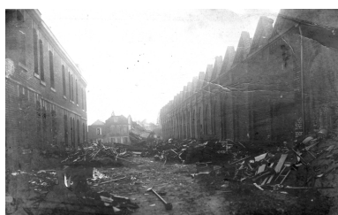
Les ateliers bordant la rue Poëtte. Photographie prise en direction de la rue Sommières, après l'armistice (AD Aisne). Phot. Pillet Frédéric IVR22_20040200924NUCAB
