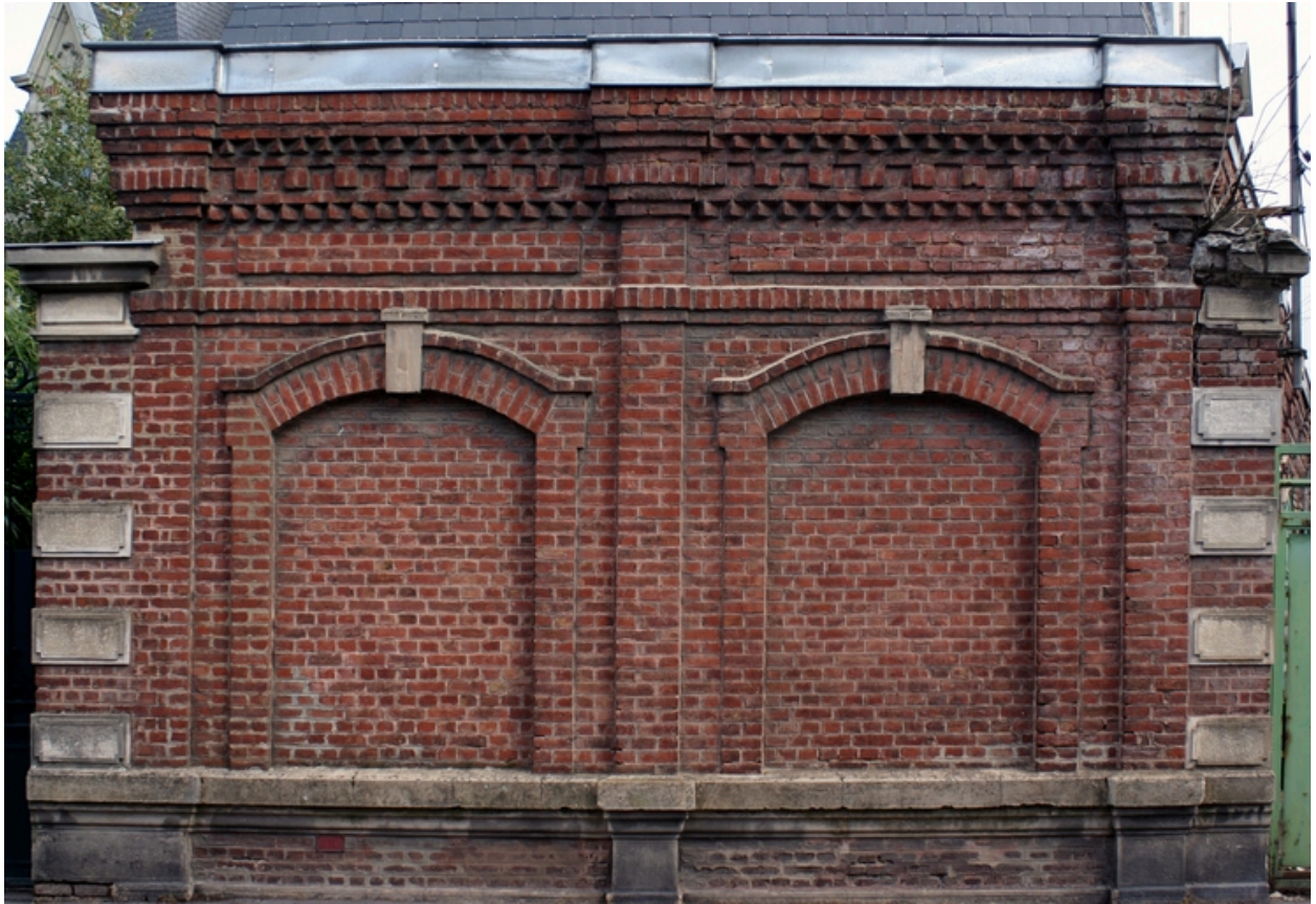
Pignon de la conciergerie.
