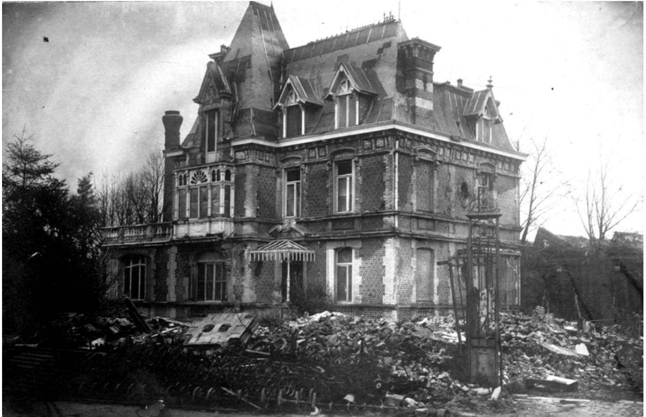
Le logement patronal, relativement épargné par les destructions de la Première Guerre mondiale (AD Aisne).
