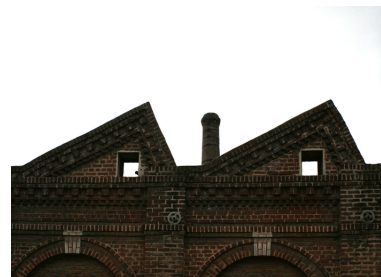
Corniche et sheds des ateliers de tissage, rue Poëtte : seule la façade subsiste. A l'arrière plan, la cheminée de l'usine.
