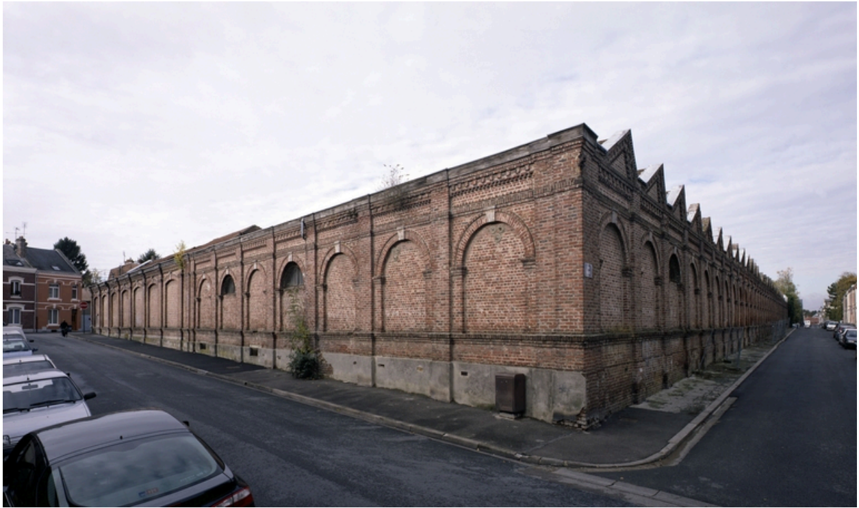
Façade des ateliers de cylindrage et bordage, de la passementerie et des ateliers de tissage, rue Poëtte.
