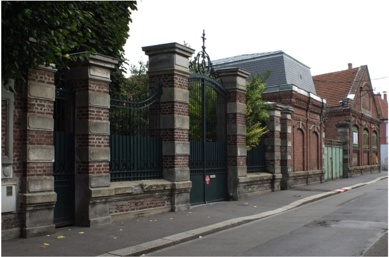
Le site de l'usine Sidoux, rue Camille-Desmoulins.
