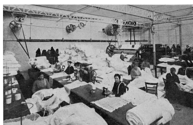
La salle de finissage réorganisée : au premier plan, les machines à border ; au fond à droite, les cylindres qui donnent aux rideaux leur dernier fini, vers 1921 (Le Monde Illustré). Phot. Pillet Frédéric IVR22_20040200933NUCAB
