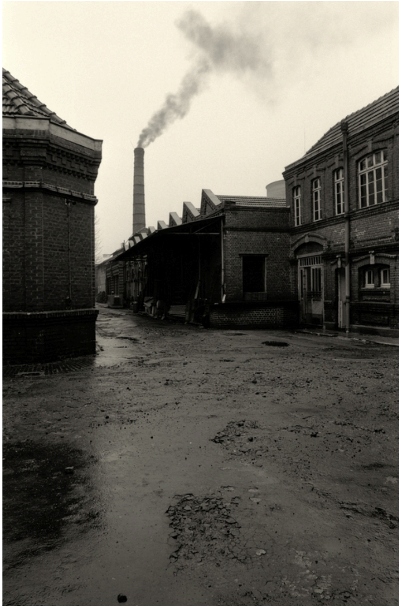
Vue des ateliers depuis la cour, 1988 (à droite, les sanitaires et les bureaux).
