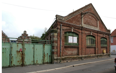
Entrée de l'usine et pignon des magasins reconstruits en 1919-1920. Phot. Frédéric Pillet IVR22_20040200940NUCA
