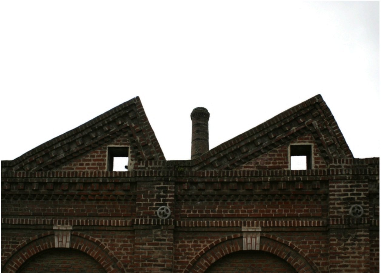
Corniche et sheds des ateliers de tissage, rue Poëtte : seule la façade subsiste. A l'arrière plan, la cheminée de l'usine.
