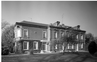
Elévation sur parc. Phot. Fabrice Charrondière IVR22_19856001465V
