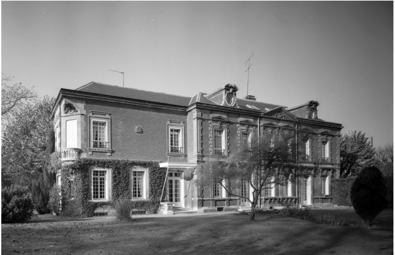
Elévation sur parc.
