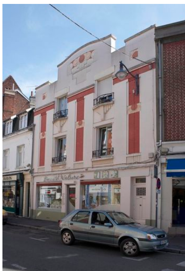
Vue générale. Phot. Pierre Thibaut IVR31_20086200164NUCA
