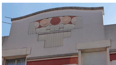
Fronton central aux motifs géométriques. Phot. Pierre Thibaut IVR31_20096200207NUCA
