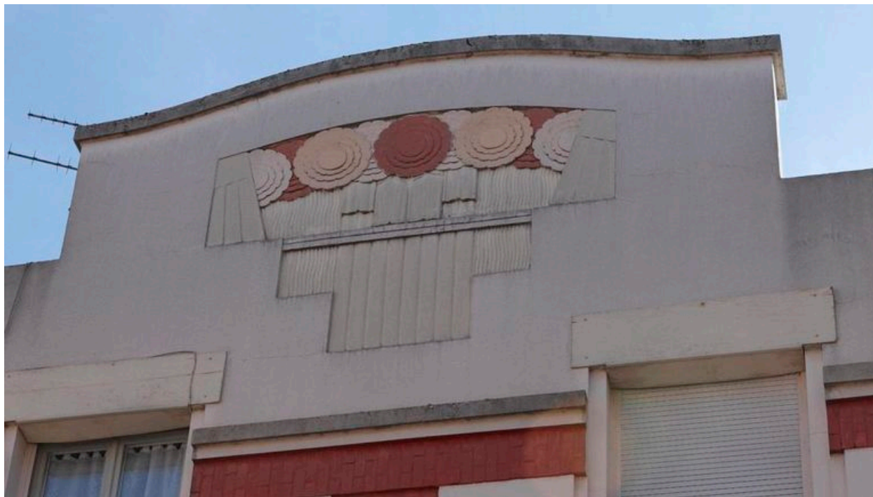
Fronton central aux motifs géométriques.
