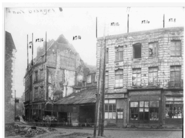
Arras. Rue des Trois-Visages. Photographie, 1922 (Médiathèque d'Arras ; 176). Phot. Thibaut Pierre (reproduction) IVR31_20096200311NUCB
