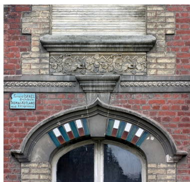
Façade, 6 place du Général Foy : détail. Phot. Frédéric Pillet IVR22_20050205477NUCA
