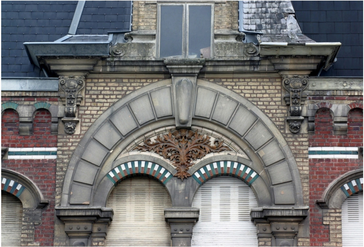
Façade, 6 place du Général Foy : détail.
