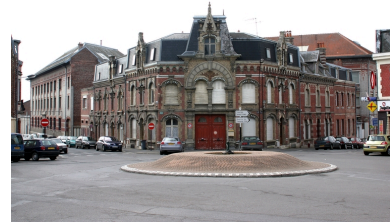
Vue générale. Phot. Frédéric Pillet IVR22_20050205472NUCA
