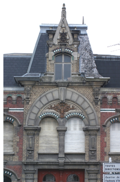
Façade, 6 place du Général Foy : détail. Phot. Frédéric Pillet IVR22_20050205475NUCA
