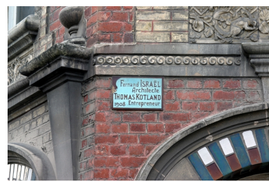
Façade, 6 place du Général Foy : détail. Phot. Frédéric Pillet IVR22_20050205478NUCA
