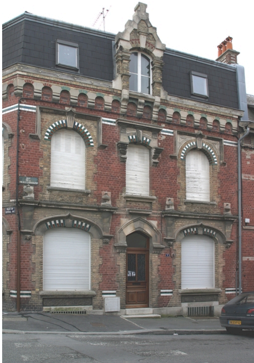
Façade de l'immeuble, 1 rue de la Tour-Sainte-Catherine.
