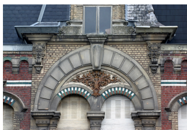
Façade, 6 place du Général Foy : détail. Phot. Frédéric Pillet IVR22_20050205476NUCA
