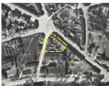
Vue aérienne du site en juin 1918 (AD Aisne).
