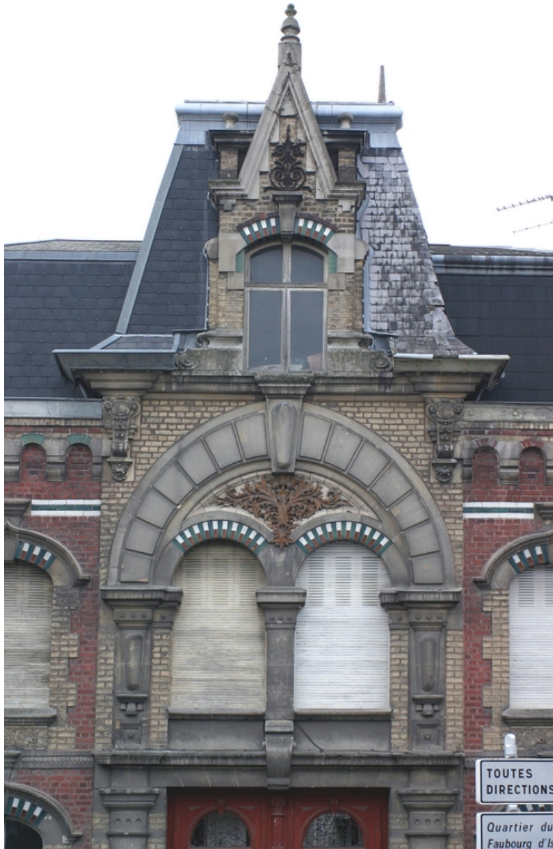
Façade, 6 place du Général Foy : détail.
