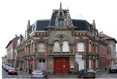
Vue générale : au centre, l'ancienne entrée de la cour du grillage Lenain. Phot. Frédéric Pillet IVR22_20050205473NUCA
