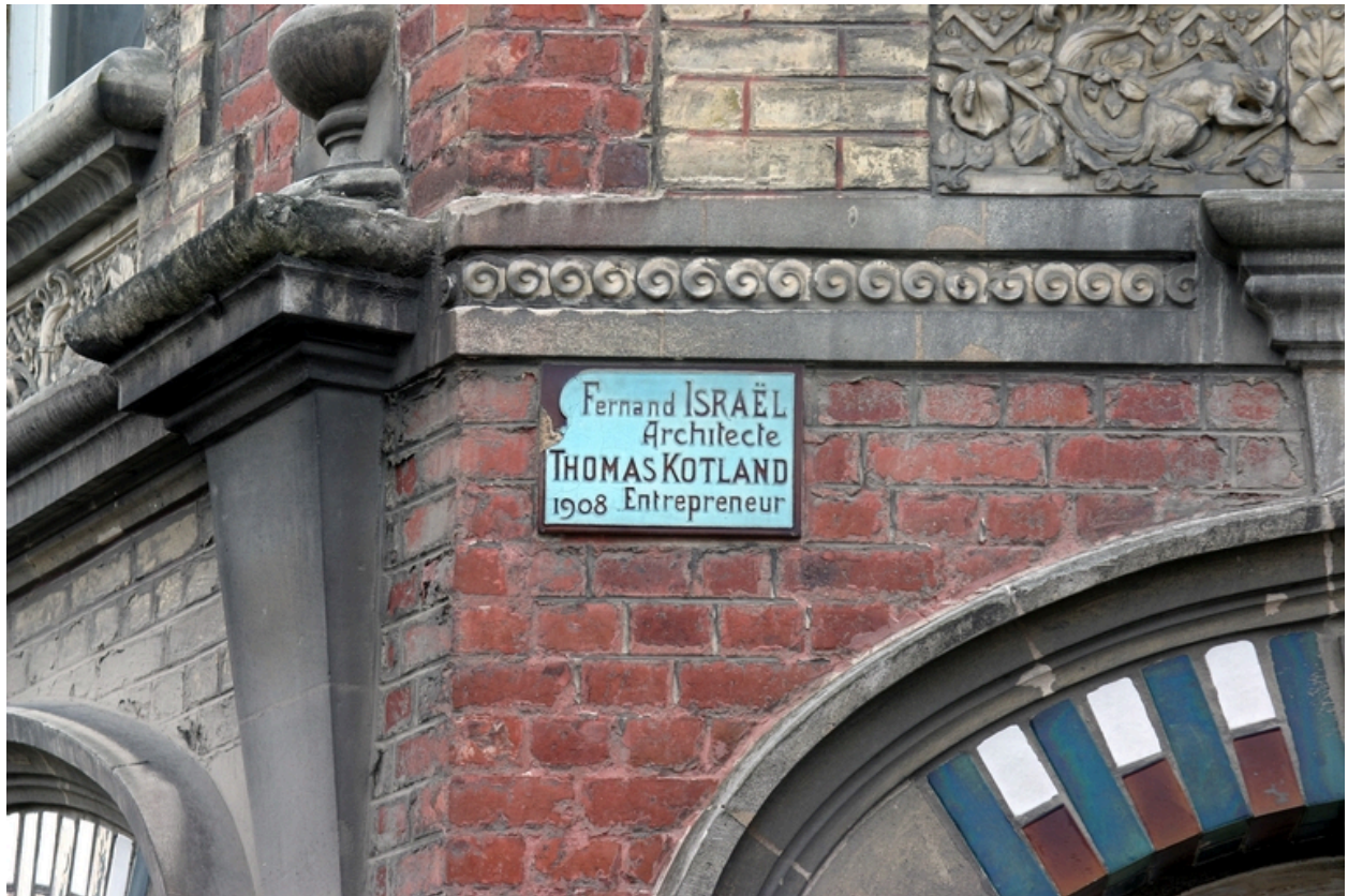
Façade, 6 place du Général Foy : détail.
