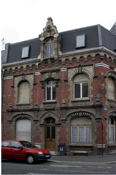
Façade, 2 rue du Général Foy. Phot. Frédéric Pillet IVR22_20050205479NUCA
