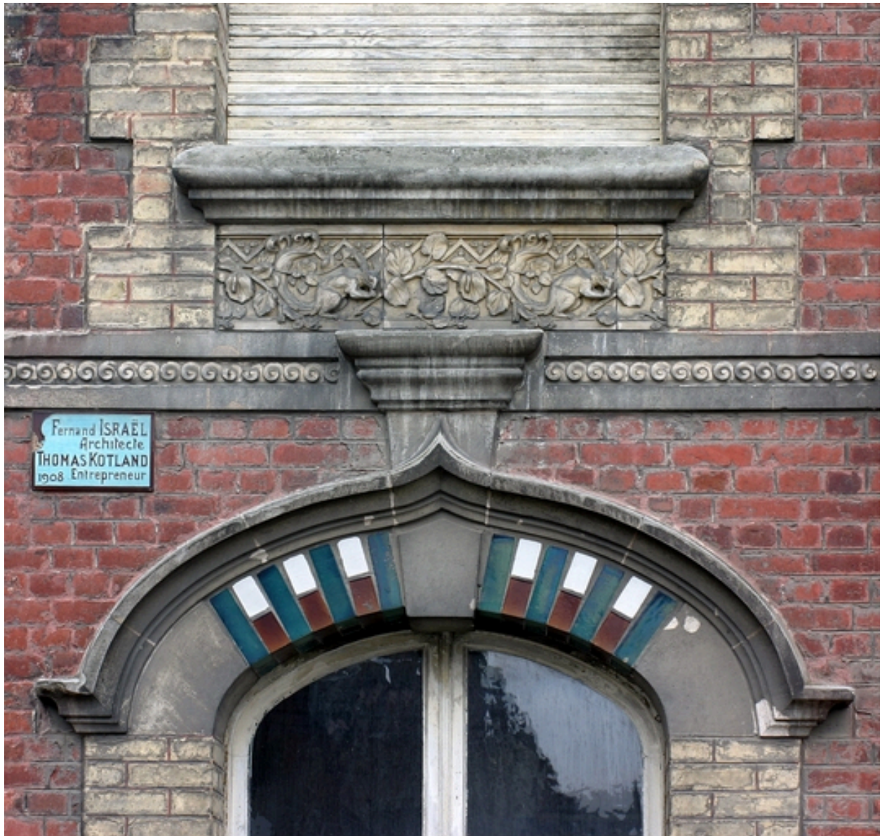
Façade, 6 place du Général Foy : détail.
