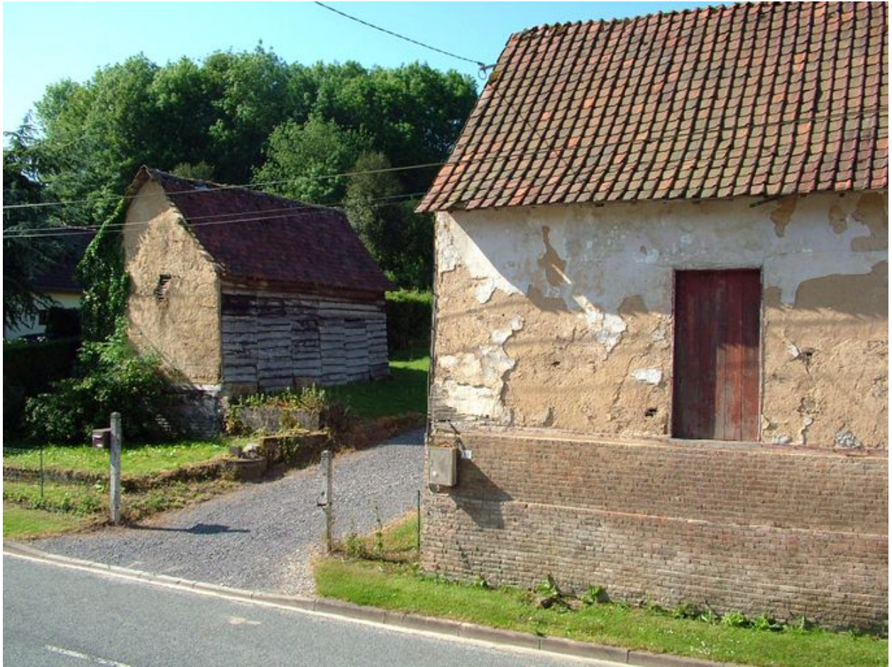
Anciens bâtiments de ferme, 11 rue Principale, 2e moitié du 19e siècle.
