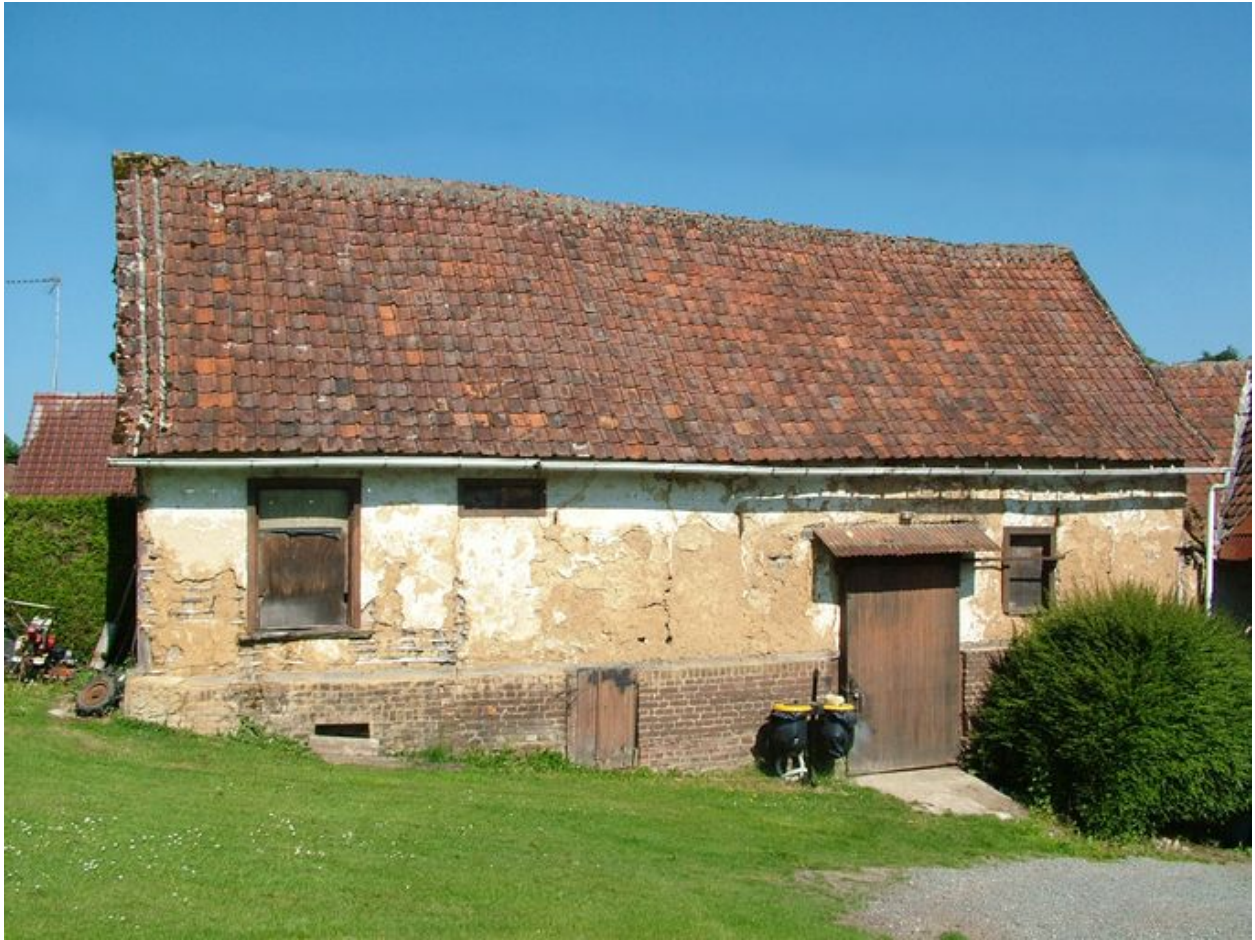
Etable de l'ancienne ferme, 13 rue Principale, 2e moitié du 19e siècle.
