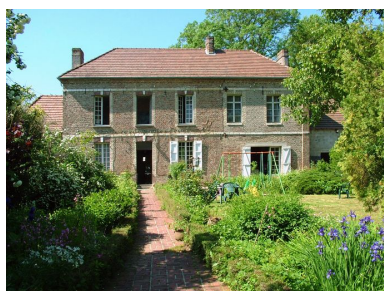
Maison, 29 rue Principale, 2e moitié du 19e siècle. Phot. Frédéric Fournis IVR22_20108001793NUCA
