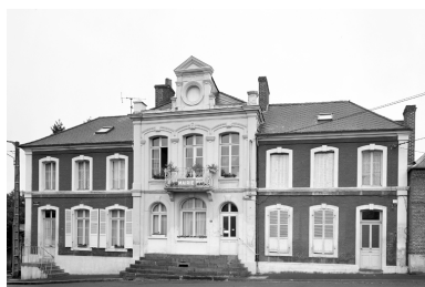
La mairie-école de Wassigny. Phot. Thierry Lefébure IVR22_19910201657V
