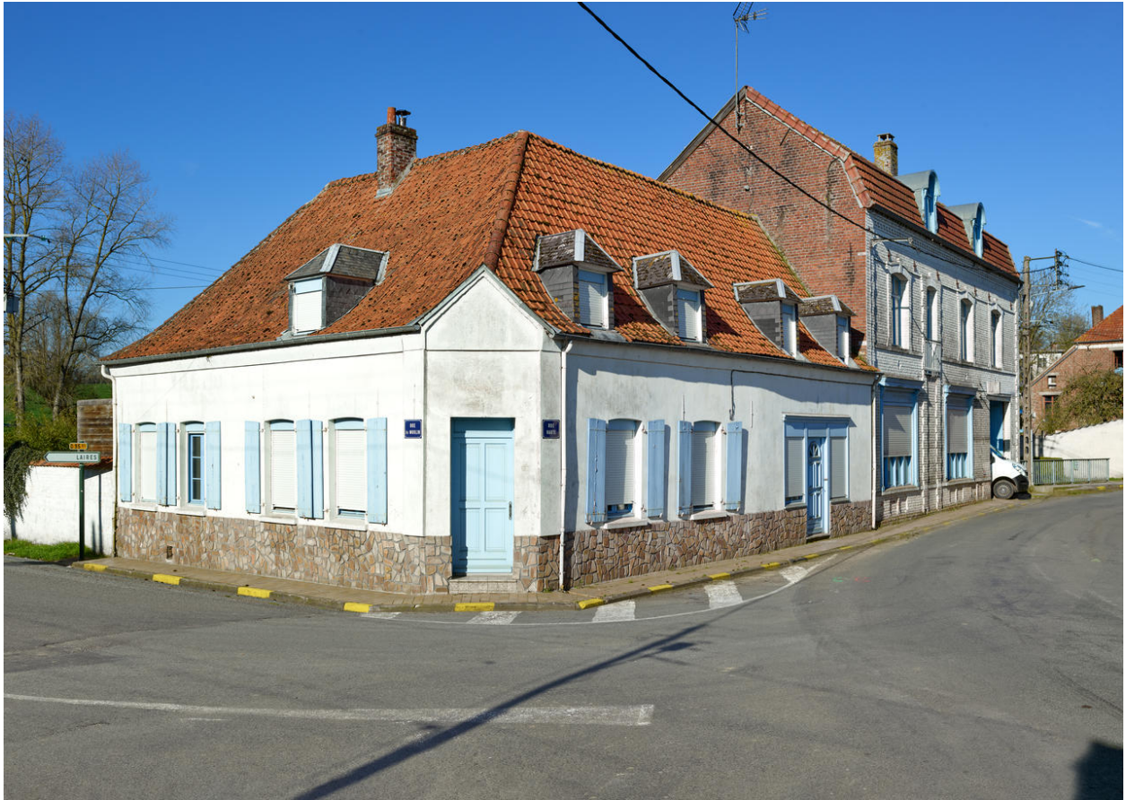
Vue générale depuis la place.
