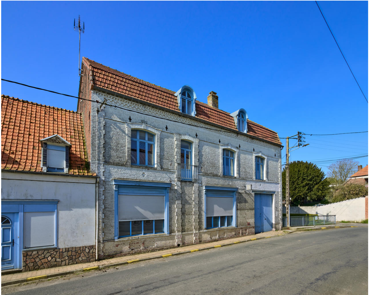
Vue de la partie nord du magasin.
