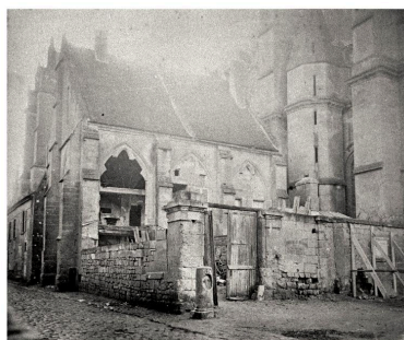
Vue nord-ouest de l'ancienne salle capitulaire, vers 1875 (A Évêché Soissons : 2 Y, Soissons-Cathédrale). Phot. Riboulleau Christiane IVR22_20130200117Z
