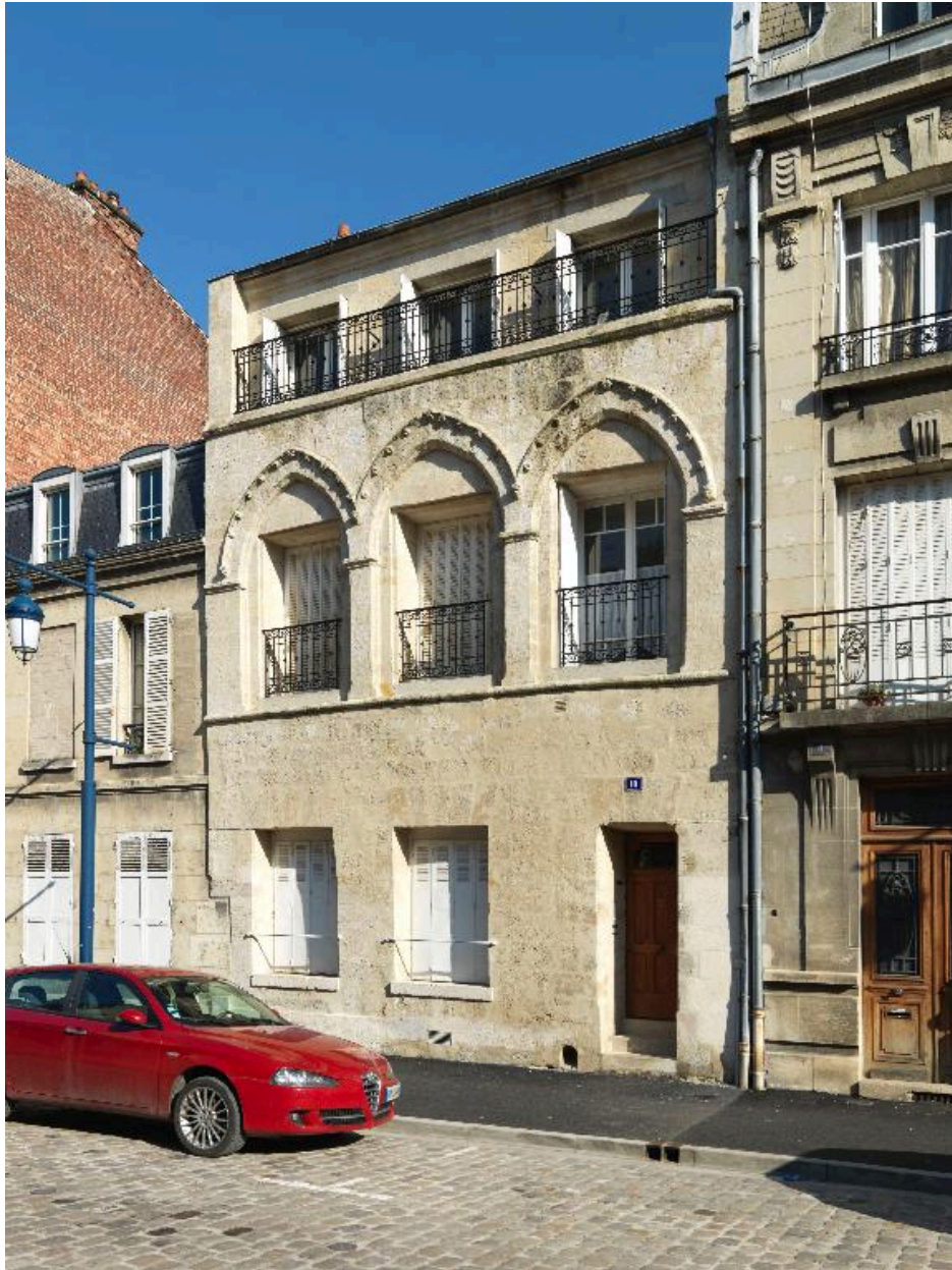
Façade de l'ancienne maison, dite "de la Chartre" (tribunal et prisons du chapitre).
