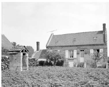
Vue générale. Phot. Jean-Michel Perrin IVR22_19856000823V
