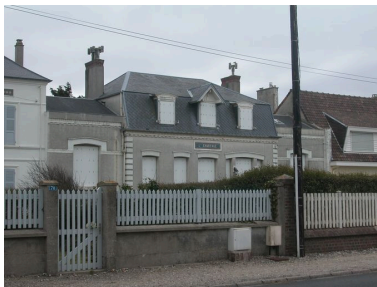
Vue d'ensemble depuis la rue. Phot. Elisabeth Justome IVR22_20058002673NUCA
