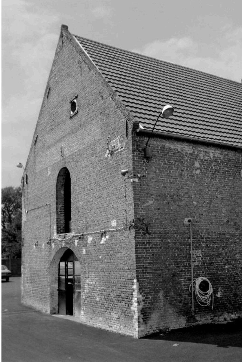
Atelier de fabrication, flanc est.
