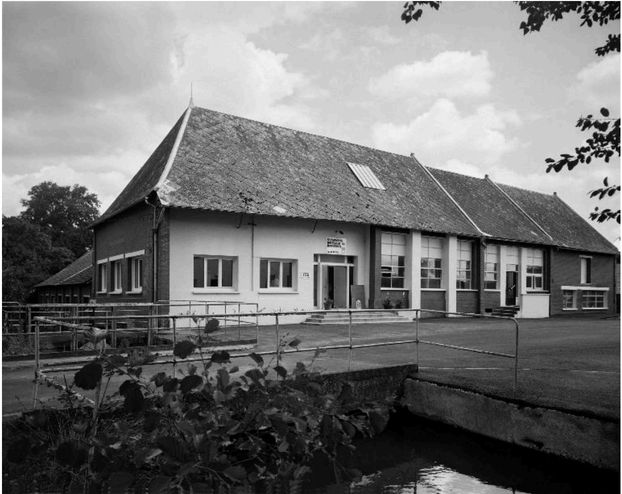
Bâtiment d'eau, atelier de fabrication.
