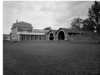
Logement patronal, magasin industriel. Elévation ouest. Phot. Thierry Lefébure IVR22_19888000794V
