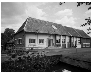
Bâtiment d'eau, atelier de fabrication.
