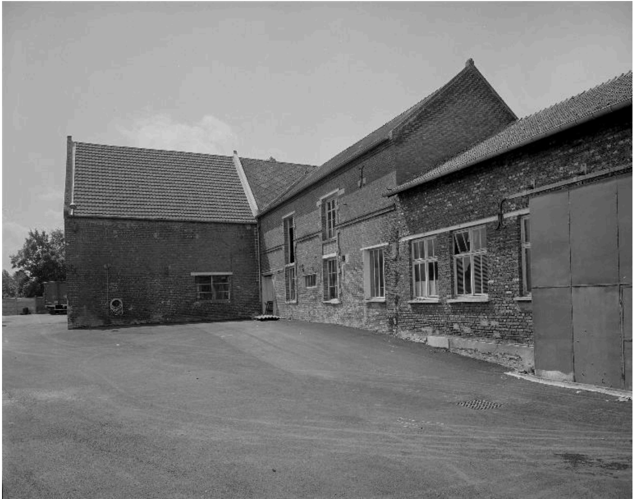
Atelier de fabrication, flanc est.
