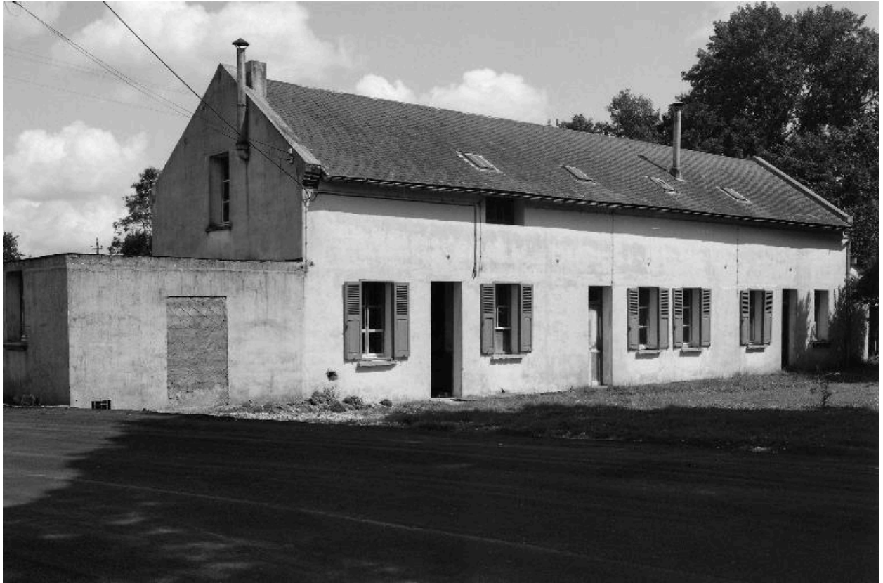
Conciergerie. Élévation antérieure.
