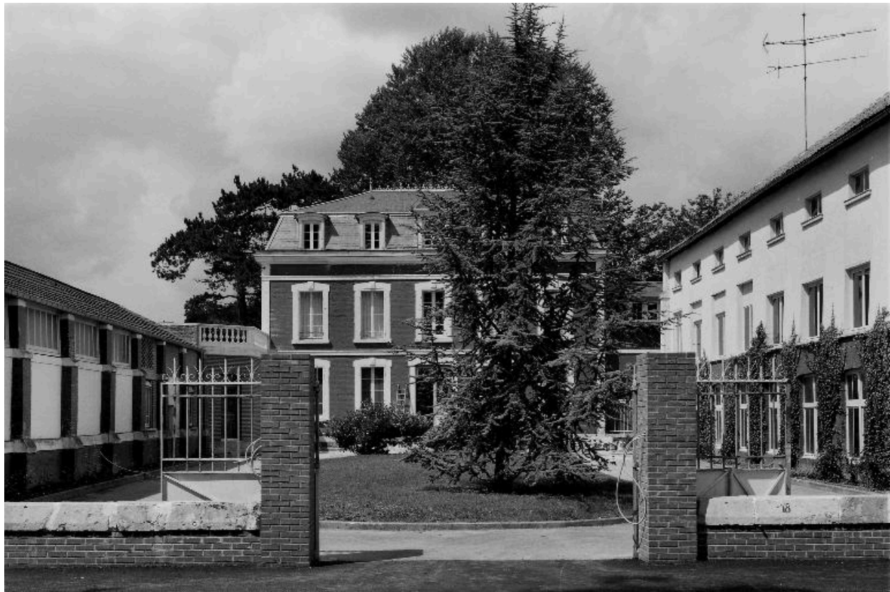
Logement patronal, magasin industriel, atelier de fabrication, cour : vue générale est.
