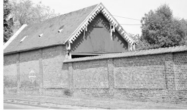
Vue des communs, avec décor de lambrequins. Phot. Judith Förstel IVR22_20018000282Z
