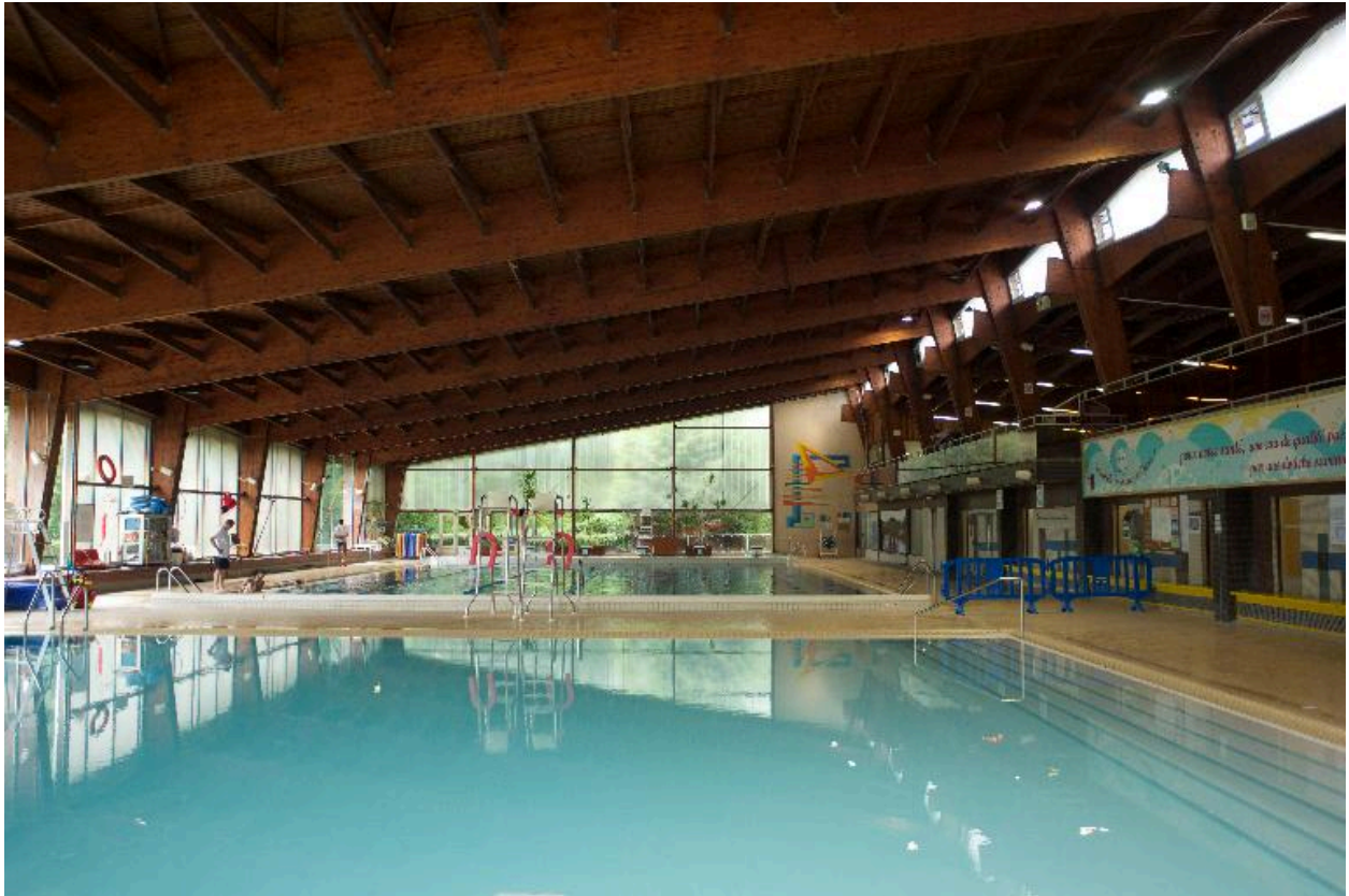
Vue générale du hall des bassins, depuis le pignon est.
