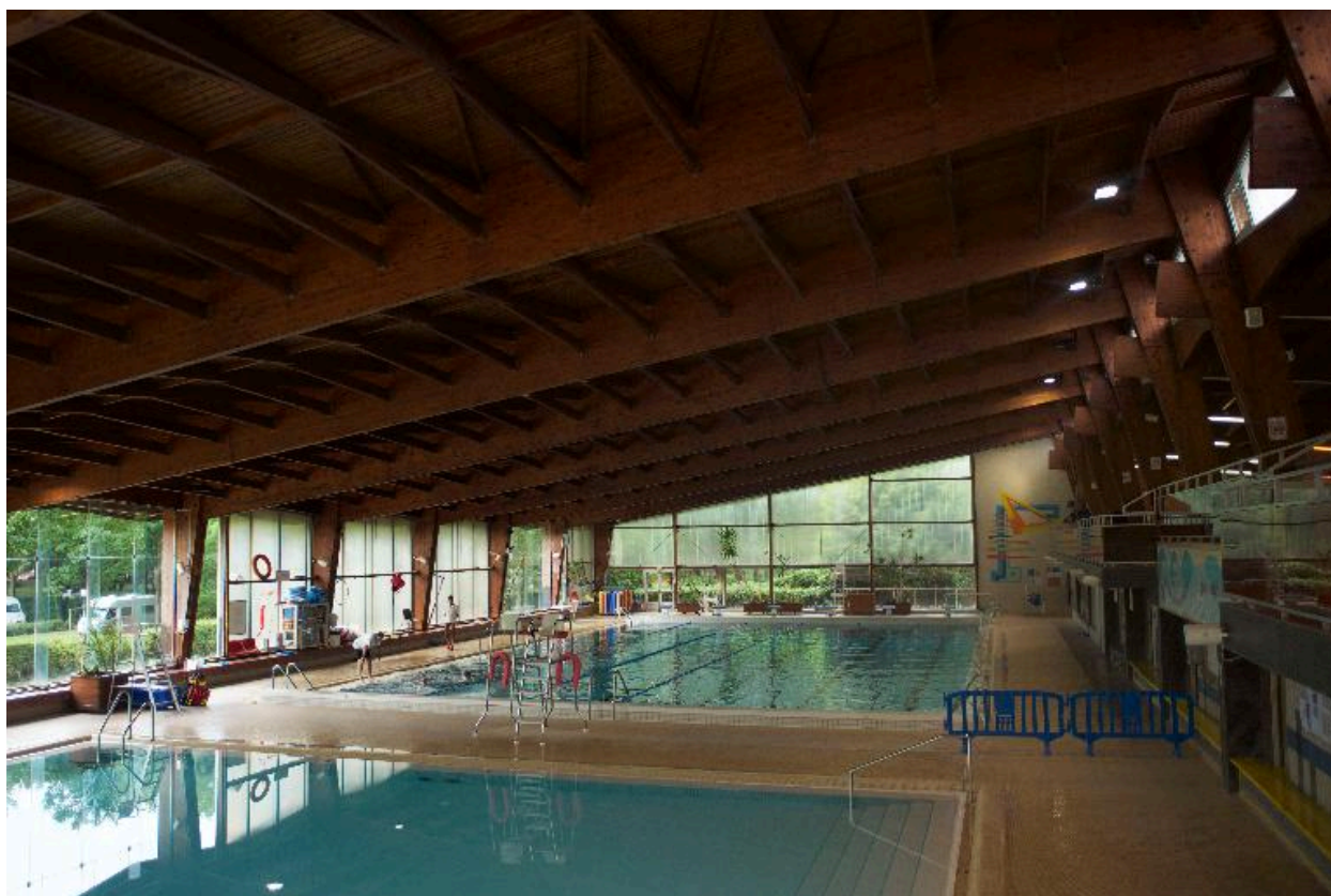
Vue générale du hall des bassin.
