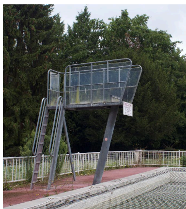
Plongeoir de 3 mètres (construit en 1973; il existait auparavant un plongeoir moins haut au même emplacement, comme en attestent les cartes postales), devant le bassin extérieur de 33 mètres.
