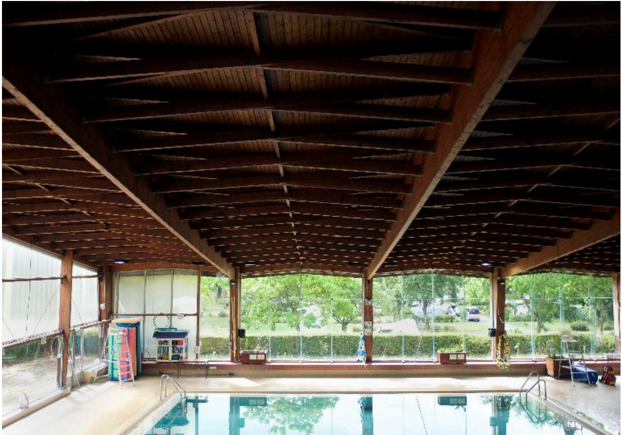
Détail de la charpente et du petit bassin, vue depuis la tribune.
