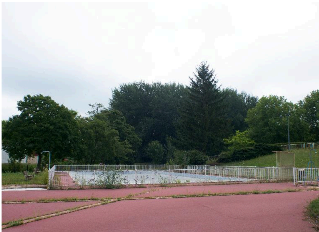
Bassin extérieur de 25 mètres (construit en 1971).
