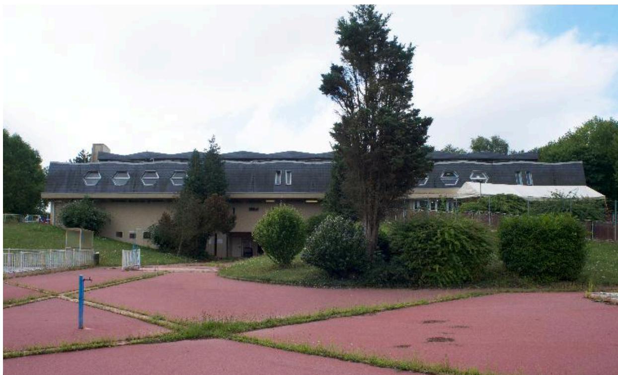
Façade nord, vue depuis les bassins extérieurs.
