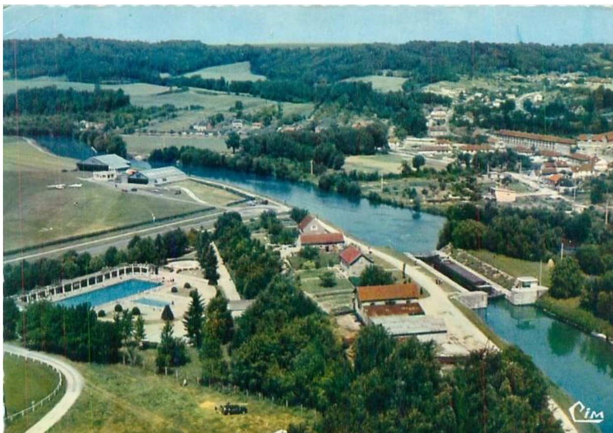
Vue aérienne de la piscine de Soissons avant la construction de la piscine couverte, au niveau du stade, vers 1960, carte postale (coll. part.).
