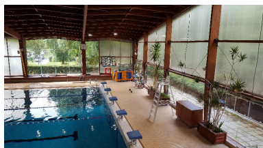
Pignon ouest (à extrémité du bassin sportif avec départs des plots des lignes de nage). Phot. Laurence Schlosser IVR32_20170205370NUCA
