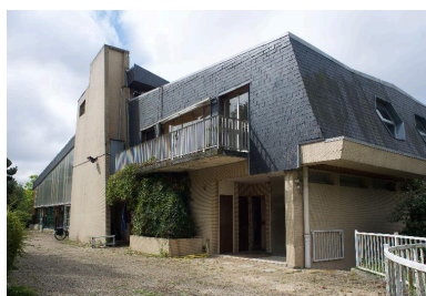
Pignon est, entrée du logement du gardien.
