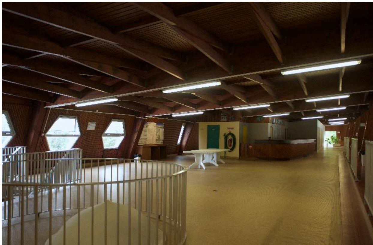
Vue générale de l'étage (vers le foyer-bar et les anciens bains-douches).
