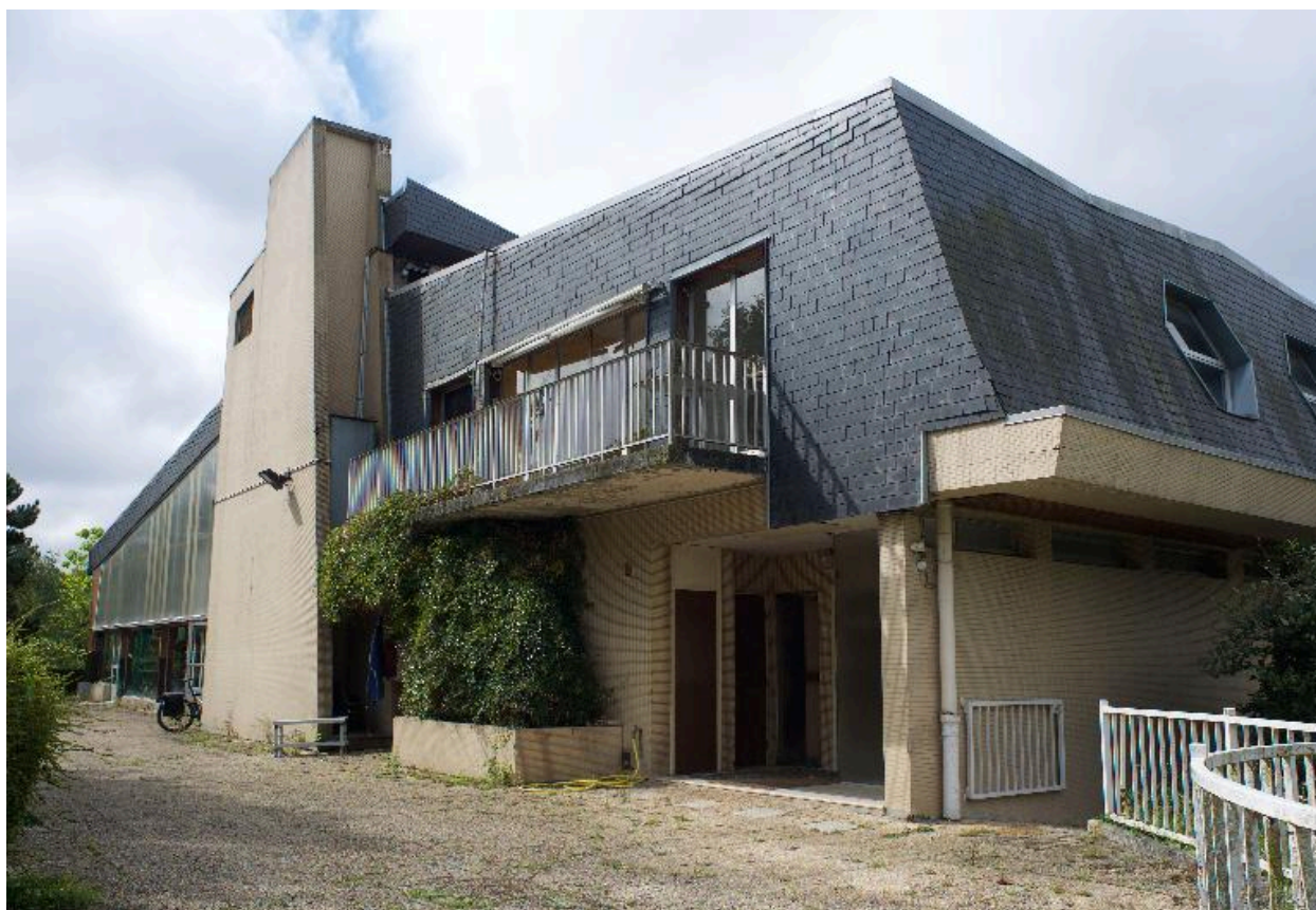
Pignon est, entrée du logement du gardien.
