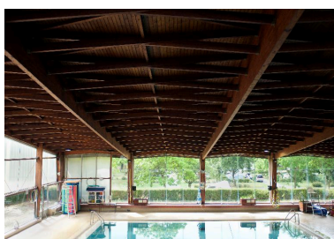
Détail de la charpente et du petit bassin, vue depuis la tribune. Phot. Marie-Laure Monnehay-Vulliet IVR32_20170200271NUC2A
