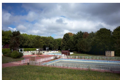
Vue générale des bassins extérieurs (à l'abandon).
