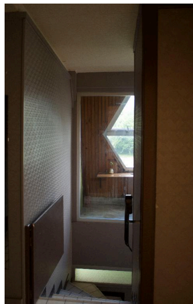
Logement du gardien : escalier d'entrée. Phot. Marie-Laure Monnehay-Vulliet IVR32_20170200283NUC2A
