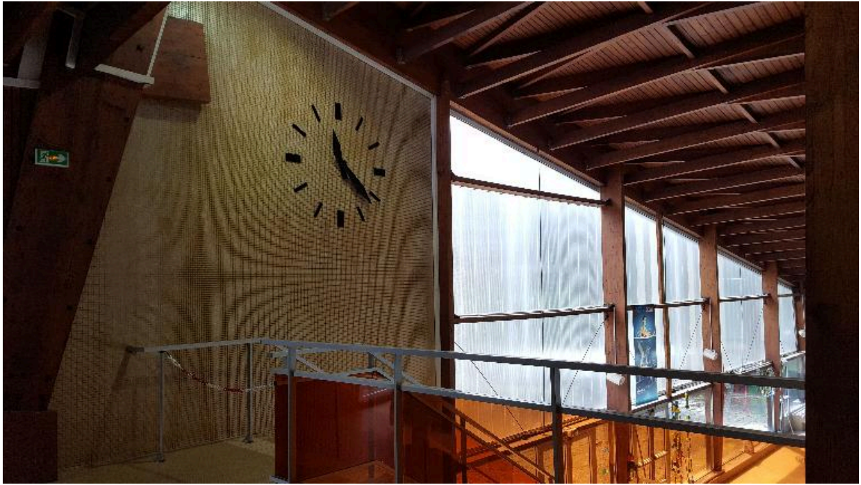
Détail de l'horloge se détachant sur le mur pignon est, revêtu de micro-mosaïque jaune.
