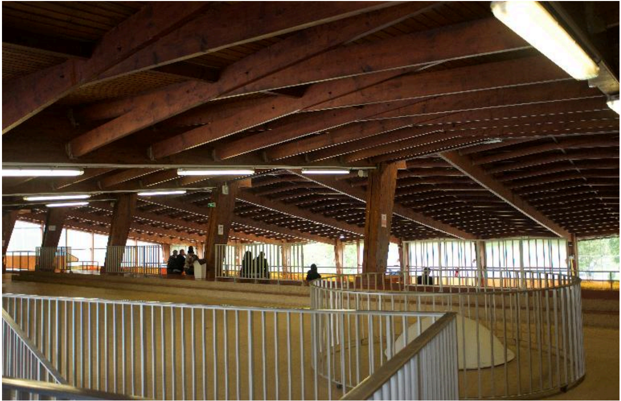
Vue de l'étage, vers les tribunes et les bassins.
