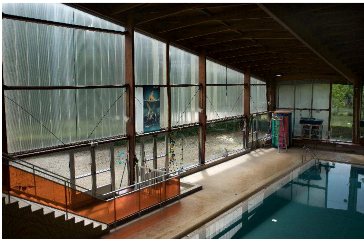
Vue du pignon est, vitré en partie basse et surmonté d'un bardage translucide en partie haute.
