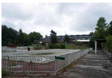
Bassin extérieur de 33 mètres, façade nord, et chemin autrefois entièrement couvert par la pergola.
