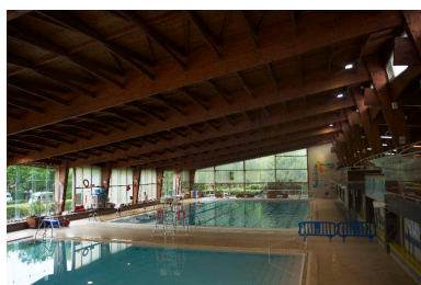
Vue générale du hall des bassin. Phot. Marie-Laure Monnehay-Vulliet IVR32_20170200273NUC2A
