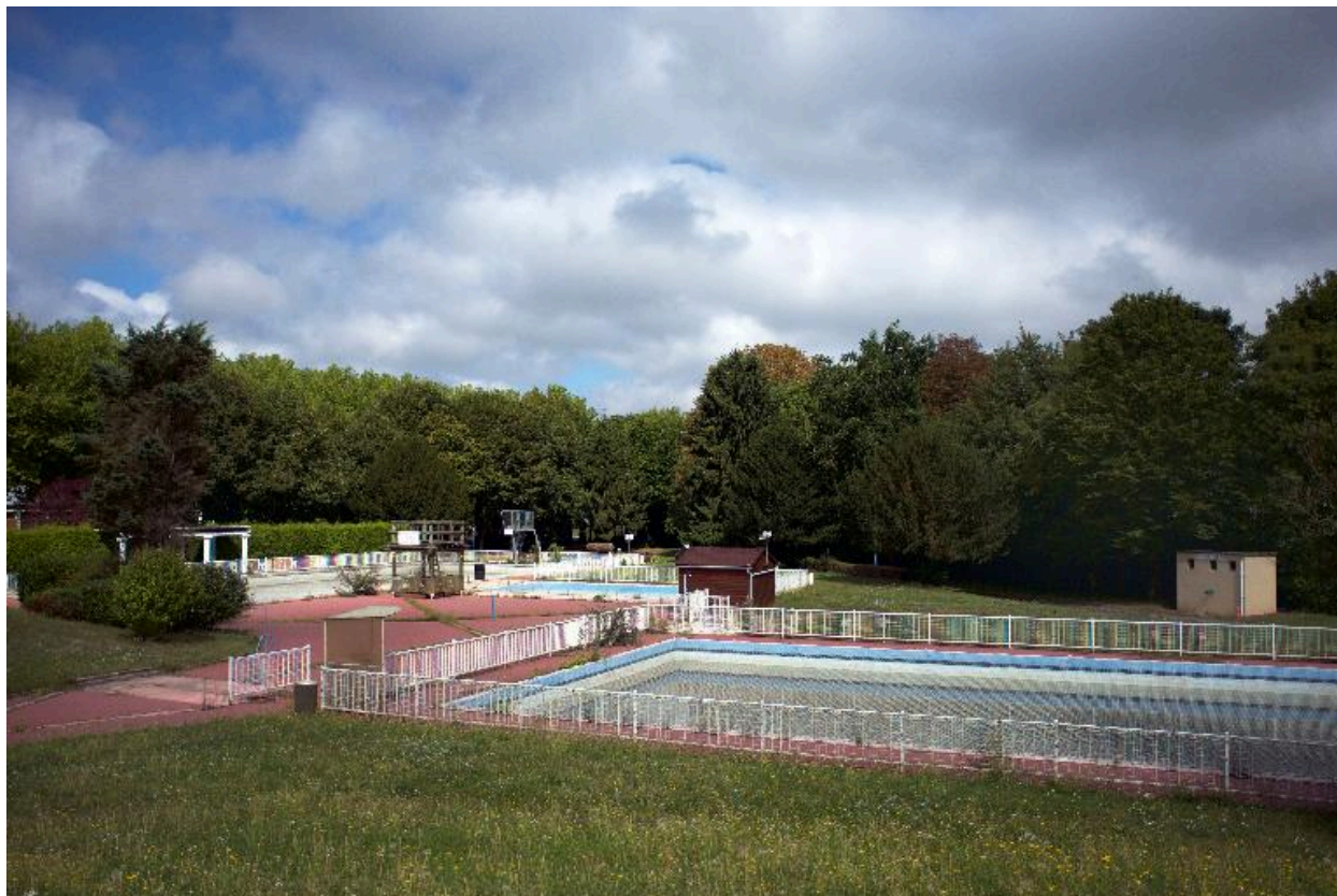
Vue générale des bassins extérieurs (à l'abandon).
