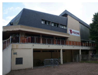
Pignon ouest (façade d'entrée).
