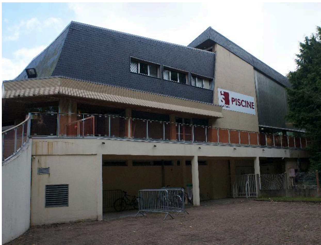
Pignon ouest (façade d'entrée).
