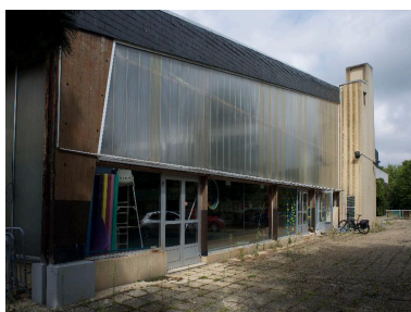
Pignon est et terrasse-solarium (aujourd'hui, sert de parking au personnel).
