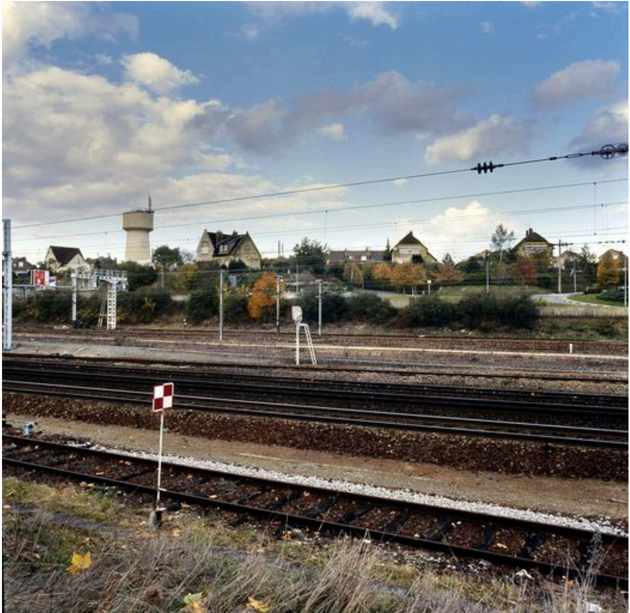
La cité, vue depuis les voies ferrées.
