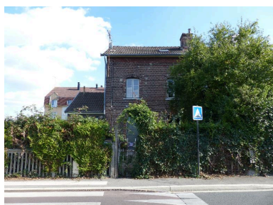
Maison de chef de train, rue Pierre-Sémard. Premières maisons de la cité construites vers 1910. Phot. Isabelle Barbedor IVR32_20168006223NUCA
