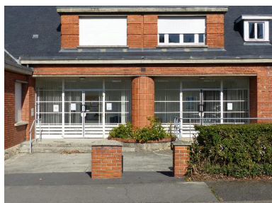
L'ancien dispensaire, vue de détail sur la façade principale. Phot. Isabelle Barbedor IVR32_20168006220NUCA
