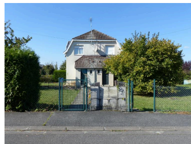
Maison à deux unités d'habitation de 4 pièces (type Rolland), rue de la Liberté. Phot. Isabelle Barbedor IVR32_20168006206NUCA
