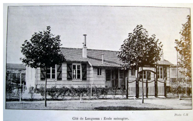
Cité de Longueau. École ménagère [Type Delorme]. La construction Moderne, n° 11, 12 décembre 1926. Phot. Isabelle Barbedor IVR22_20048010771NUCA
