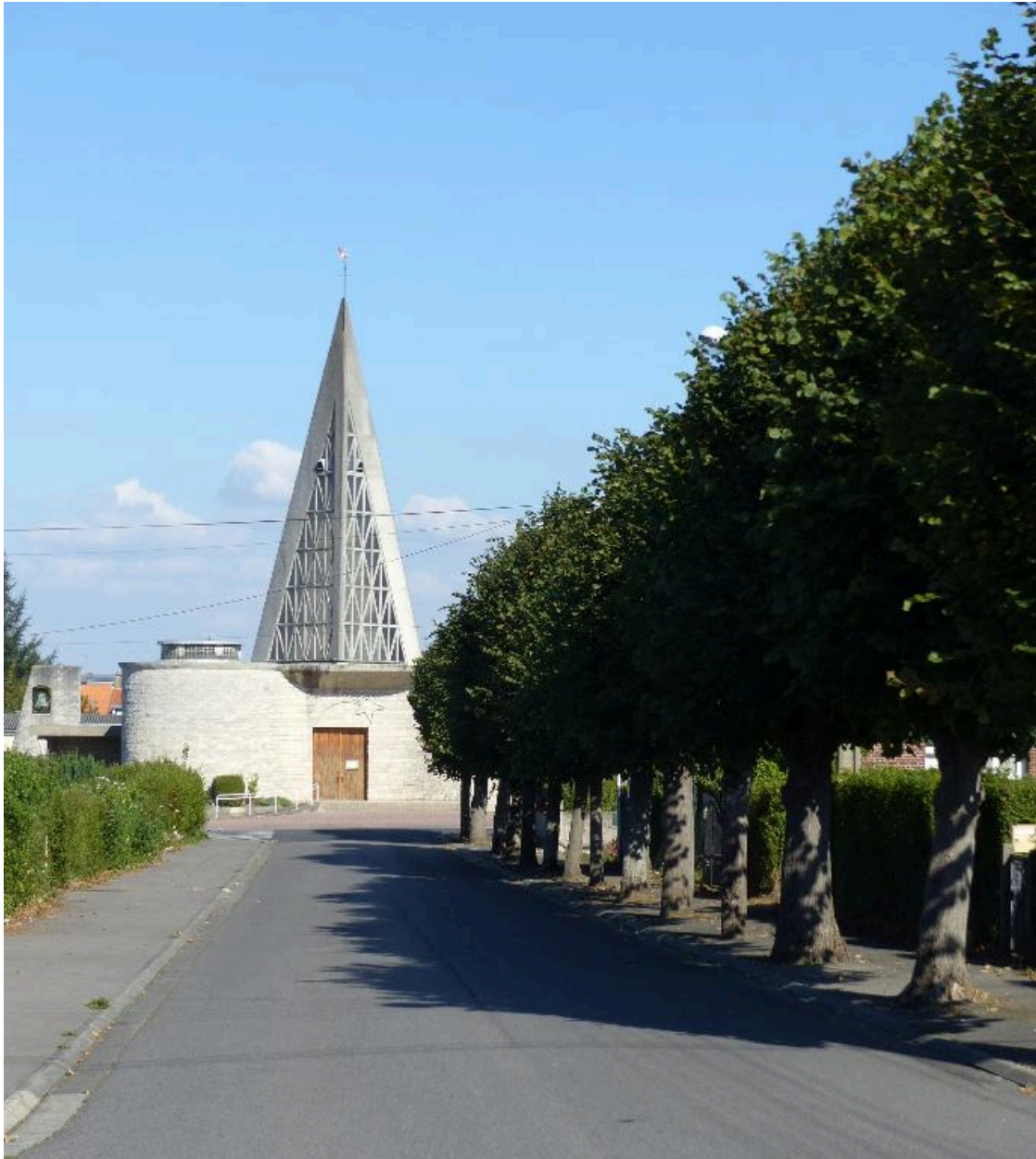
L'église, reconstruite au nord de la cité, dans l'axe de la rue du Général-De Gaulle.
