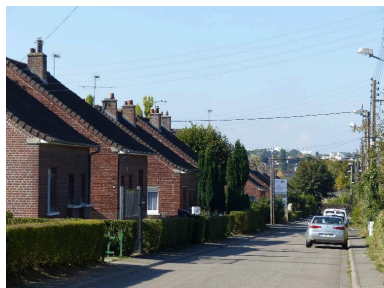
Rue Pasteur. Maisons en rez-de-chaussée construites en 1946. Phot. Isabelle Barbedor IVR32_20168006207NUCA
