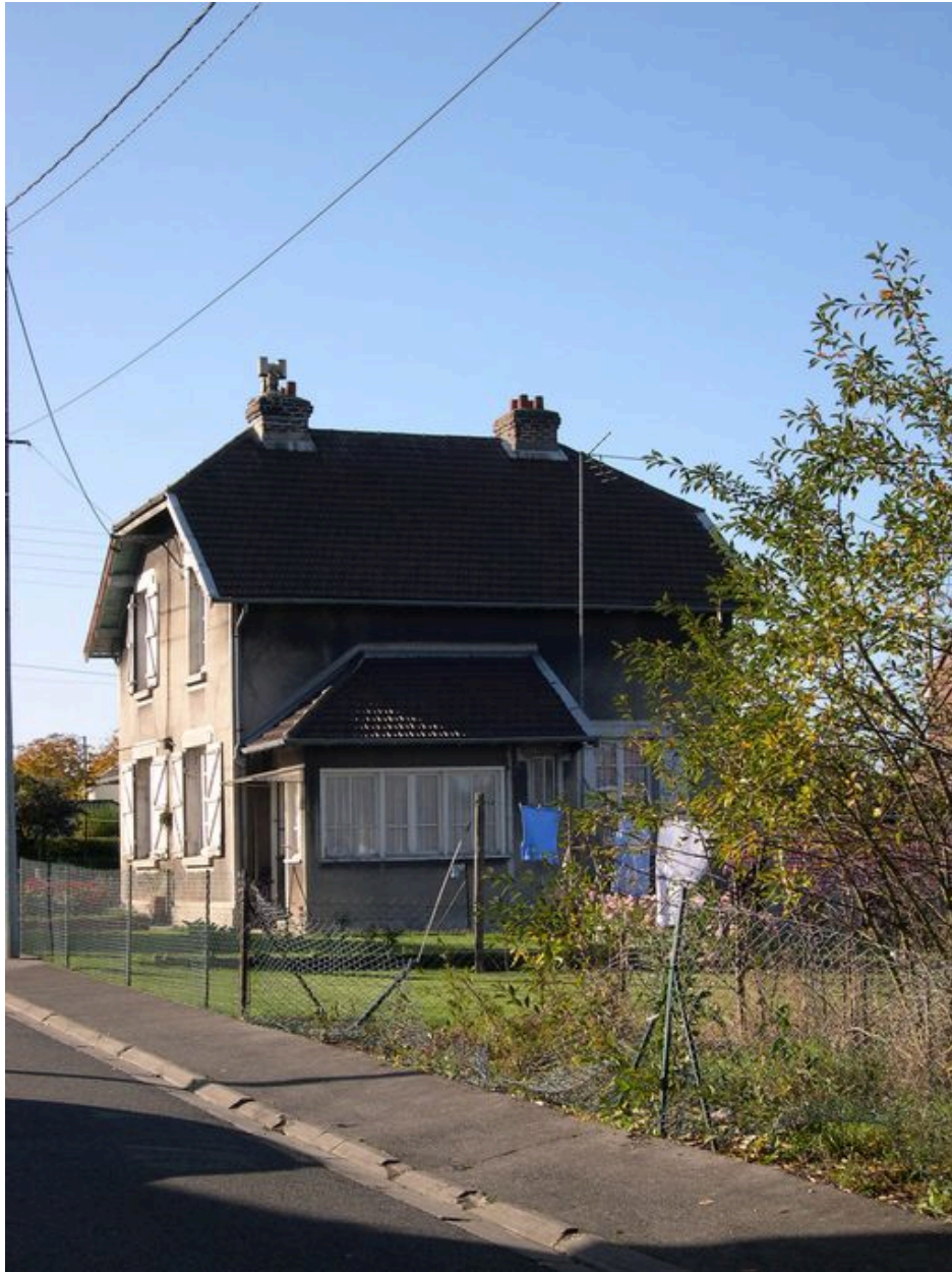
Maison à deux unités d'habitation (type Delorme), 143 et 145 rue Pierre-Curie.
