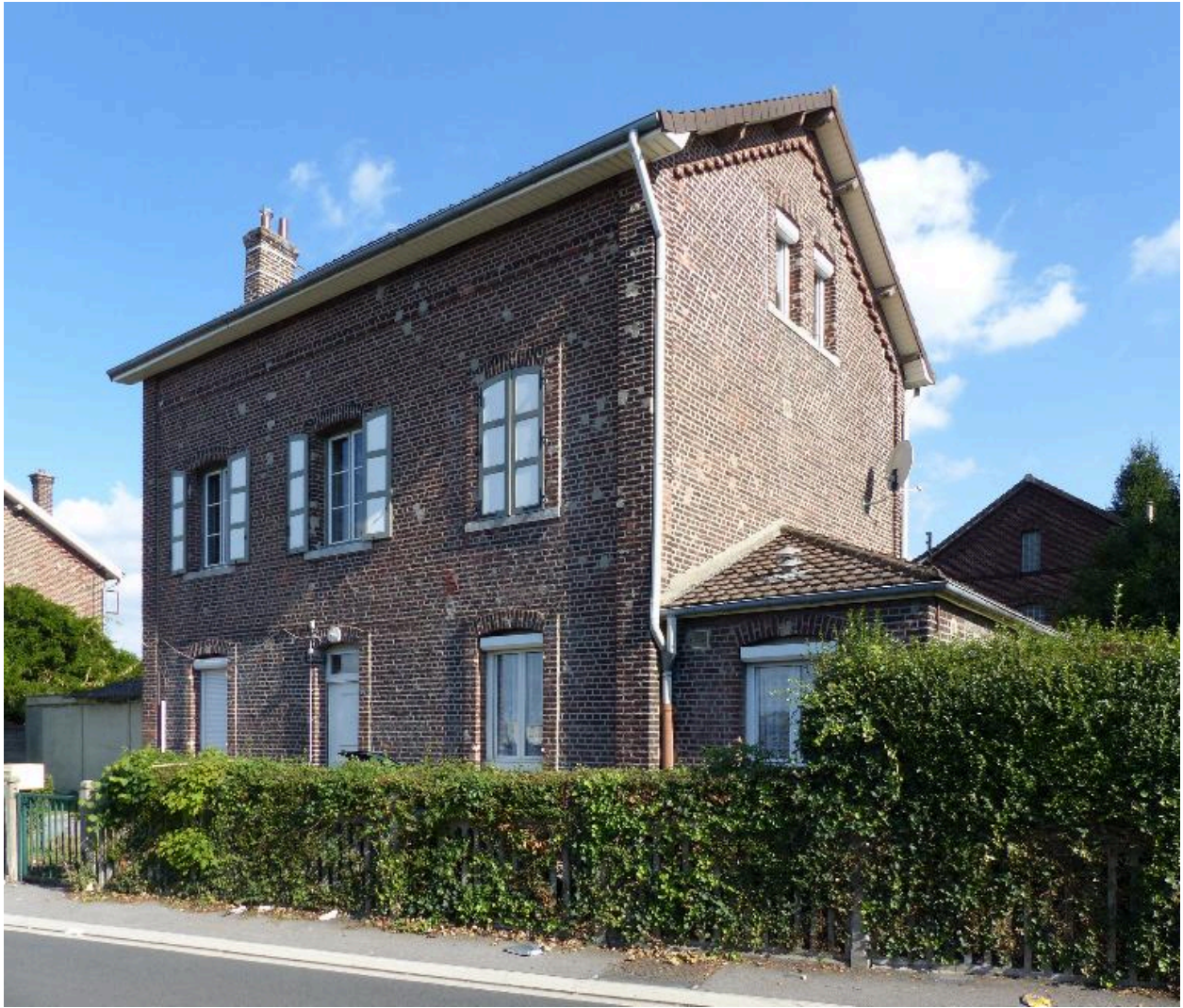
Maison de chef de train, rue Pierre-Sémard. Premières maisons de la cité construites vers 1910.
