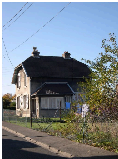
Maison à deux unités d'habitation (type Delorme), 143 et 145 rue Pierre-Curie. Phot. Isabelle Barbedor IVR22_20048010461NUCA
