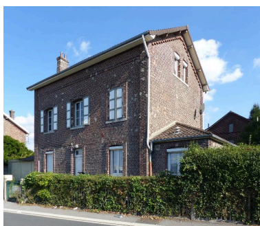
Maison de chef de train, rue Pierre-Sémard. Premières maisons de la cité construites vers 1910. Phot. Isabelle Barbedor IVR32_20168006222NUCA
