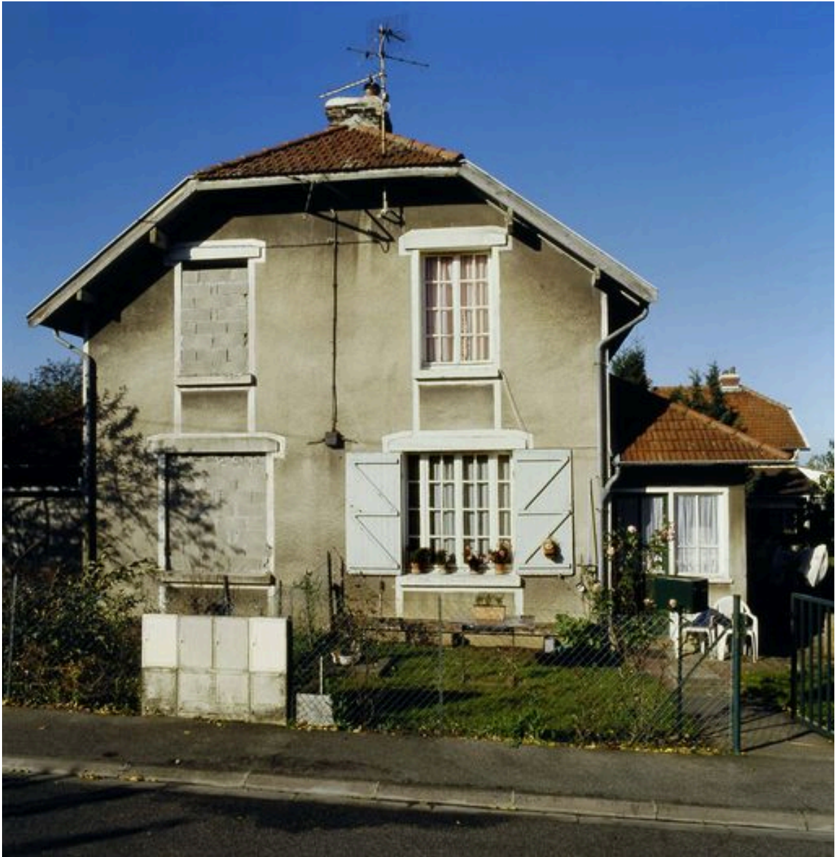
Maison à deux unités d'habitation (type Delorme), 139 et 141 rue Pierre-Curie.
