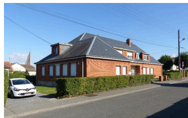
L'ancien dispensaire, construit vers 1950. Phot. Isabelle Barbedor IVR32_20168006219NUCA
