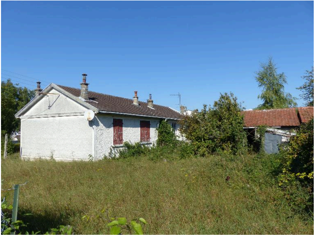
Maison à deux unités d'habitation (type Delorme), rue des Belges, façade postérieure.
