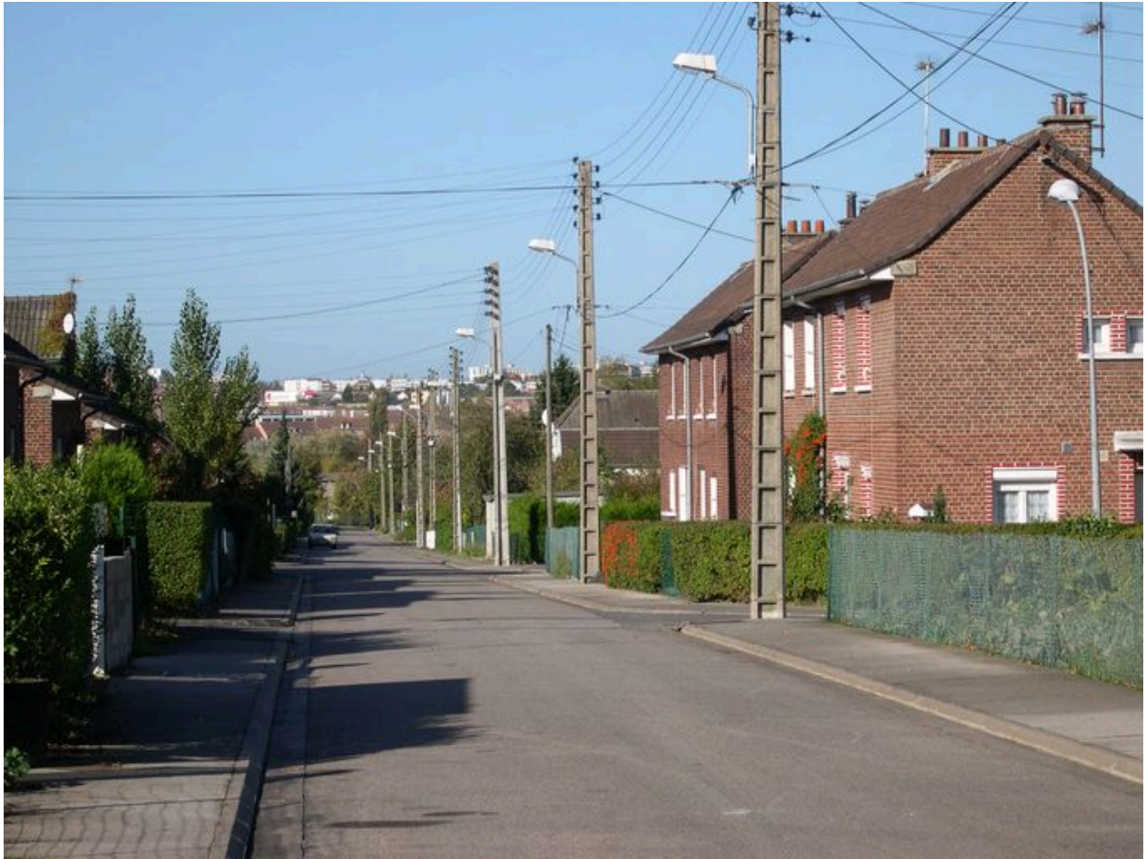
La rue Pasteur, maisons reconstruites en 1946, vue prise depuis la place de la Victoire. Rive nord maisons à étage, rive sud maisons en rez-de-chaussée, suivant les nouvelles préconisations.
