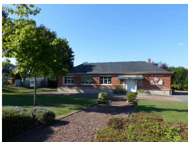
La bibliothèque, construite en 1950. Phot. Isabelle Barbedor IVR32_20168006224NUCA
