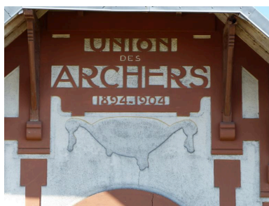
Vue du fronton de la façade sud. Phot. Isabelle Barbedor IVR32_20208005134NUCA
