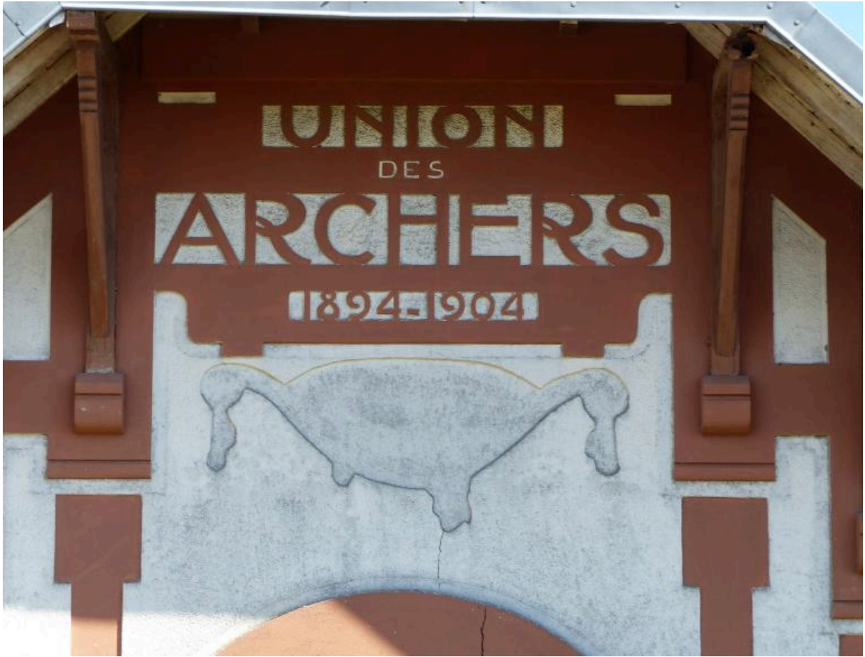
Vue du fronton de la façade sud.
