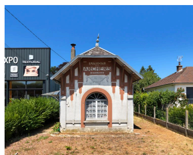
Vue de la façade sud du logis. Phot. Thierry Lefébure IVR32_20208000167NUCA
