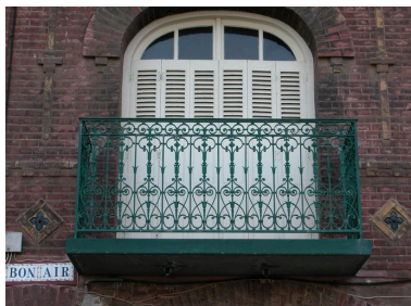
Détail du balcon en ferronnerie (maison de gauche, 1er étage-carré). Phot. Elisabeth Justome IVR22_20048001398NUCA
