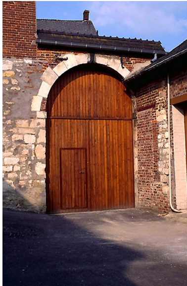
Détail du portail. Phot. Martine Plouvier IVR22_19980203526ZA
