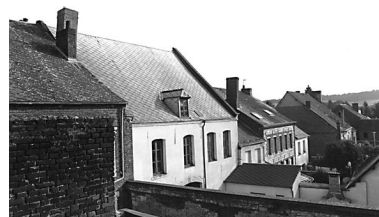
Façade postérieure. Phot. Xavier-Philippe Guiochon IVR22_19980203137Z
