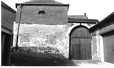
Pavillon à l'arrière de la cour et porche d'accès à la cour. Phot. Xavier-Philippe Guiochon IVR22_19980203138Z
