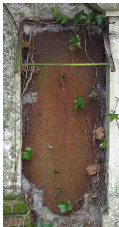
Porte-couronne d'applique en fer forgé. Phot. Caroline Vincent IVR22_20068000651NUCA
