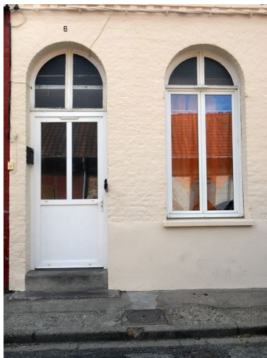
Logement, 6 rue Saint- Jules : détail de la façade. Phot. Isabelle Barbedor IVR22_20108001489NUCA
