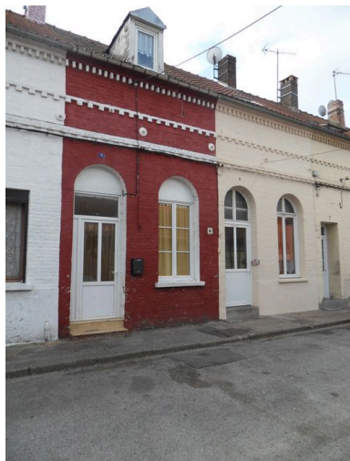
Logements, 5 et 6 rue Saint-Jules. Phot. Isabelle Barbedor IVR22_20108001488NUCA
