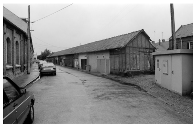
Vue des remises en regard des logements, en 1991. Phot. Benoît Dufournier IVR22_19918000271Z
