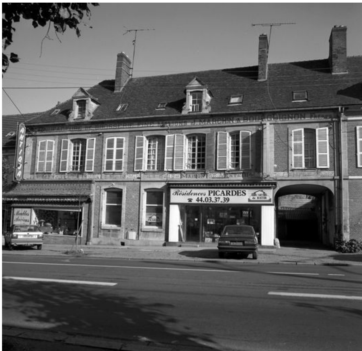
Atelier de fabrication, façade sur rue.
