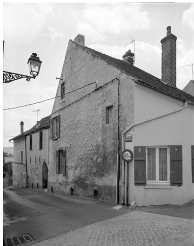
Vue de la façade sur la rue avec le passage voûté. Phot. Thierry Lefébure IVR22_19960200497V
