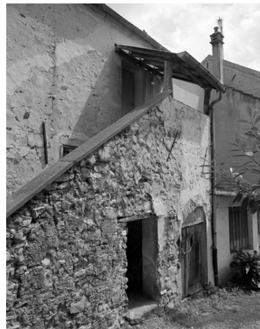
Vue de l'escalier extérieur du côté de la cour. Phot. Thierry Lefébure IVR22_19960200524X
