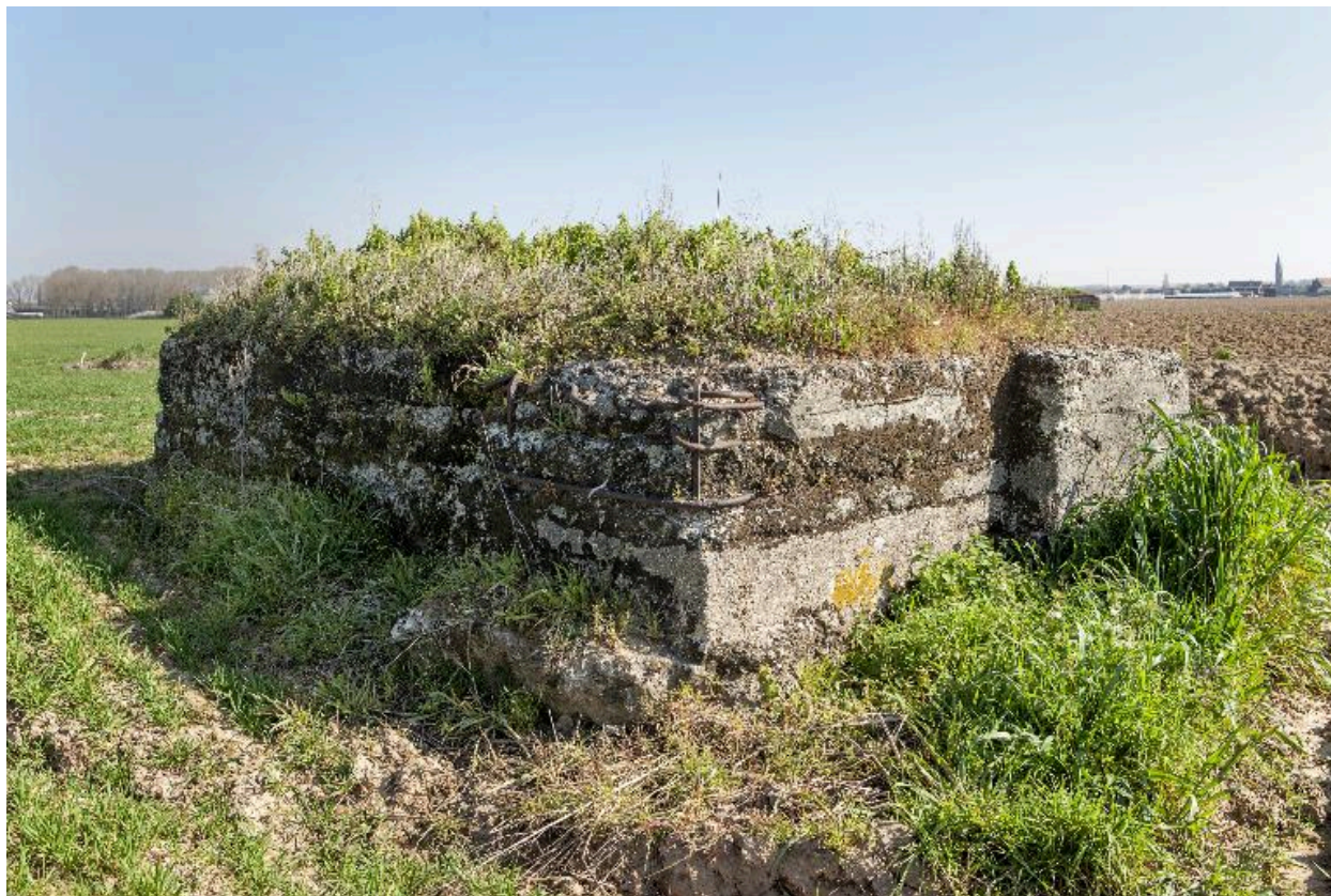
Vue de 3/a arrière, vers le nord-est
