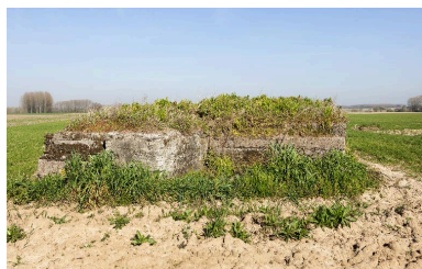
Vue vers le nord Phot. Jean-Marc Ramette IVR31_20145905025NUCA
