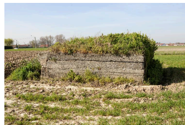
Vue de trois-quarts, vers le sud-ouest Phot. Jean-Marc Ramette IVR31_20145905027NUCA
