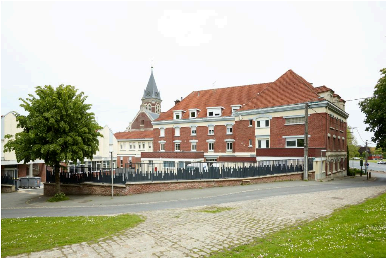
Vue arrière des bâtiments depuis la rue du donjon.
