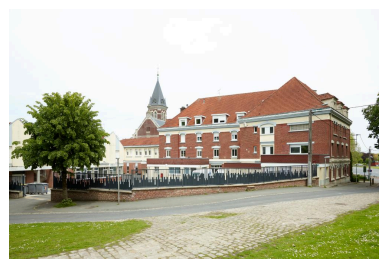
Vue arrière des bâtiments depuis la rue du donjon. Phot. Delphine Volto-Jourdan IVR32_20216200593NUCA
