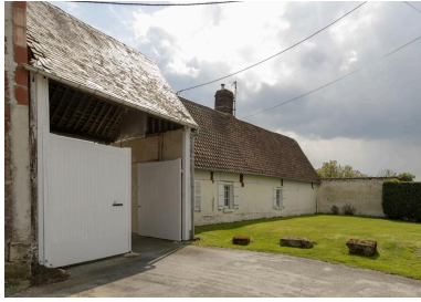
Entrée charretière et logis, n°6 Impasse des Vignes, vue depuis le nord-est. Phot. Marc Kérignard IVR32_20216000309NUCA
