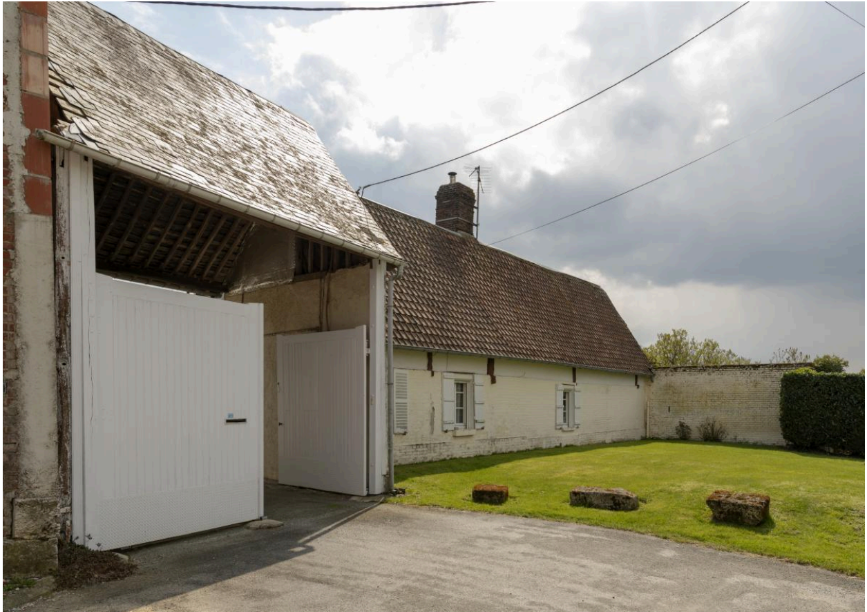
Entrée charretière et logis, n°6 Impasse des Vignes, vue depuis le nord-est.
