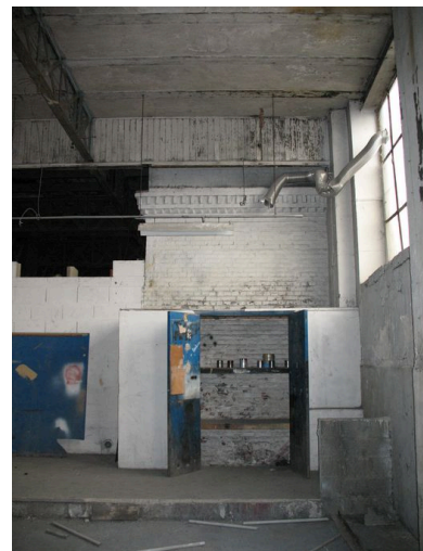
Détail de la base de la cheminée carrée en brique. Phot. Clarisse Lorieux IVR22_20066005189NUCA
