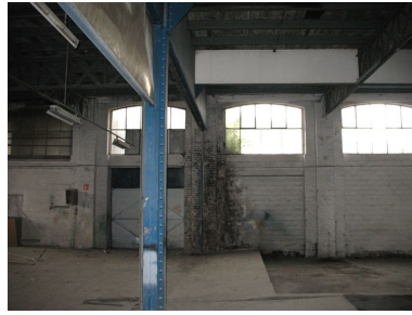
Travées non murées de la façade est de l'usine au rez-de-chaussée. Phot. Clarisse Lorieux IVR22_20066005187NUCA
