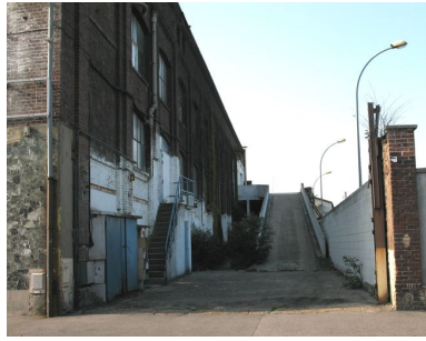
Façade est de l'usine et rampe d'accès construite pour l'utilité du garage automobile. Phot. Clarisse Lorieux IVR22_20066005178NUCA
