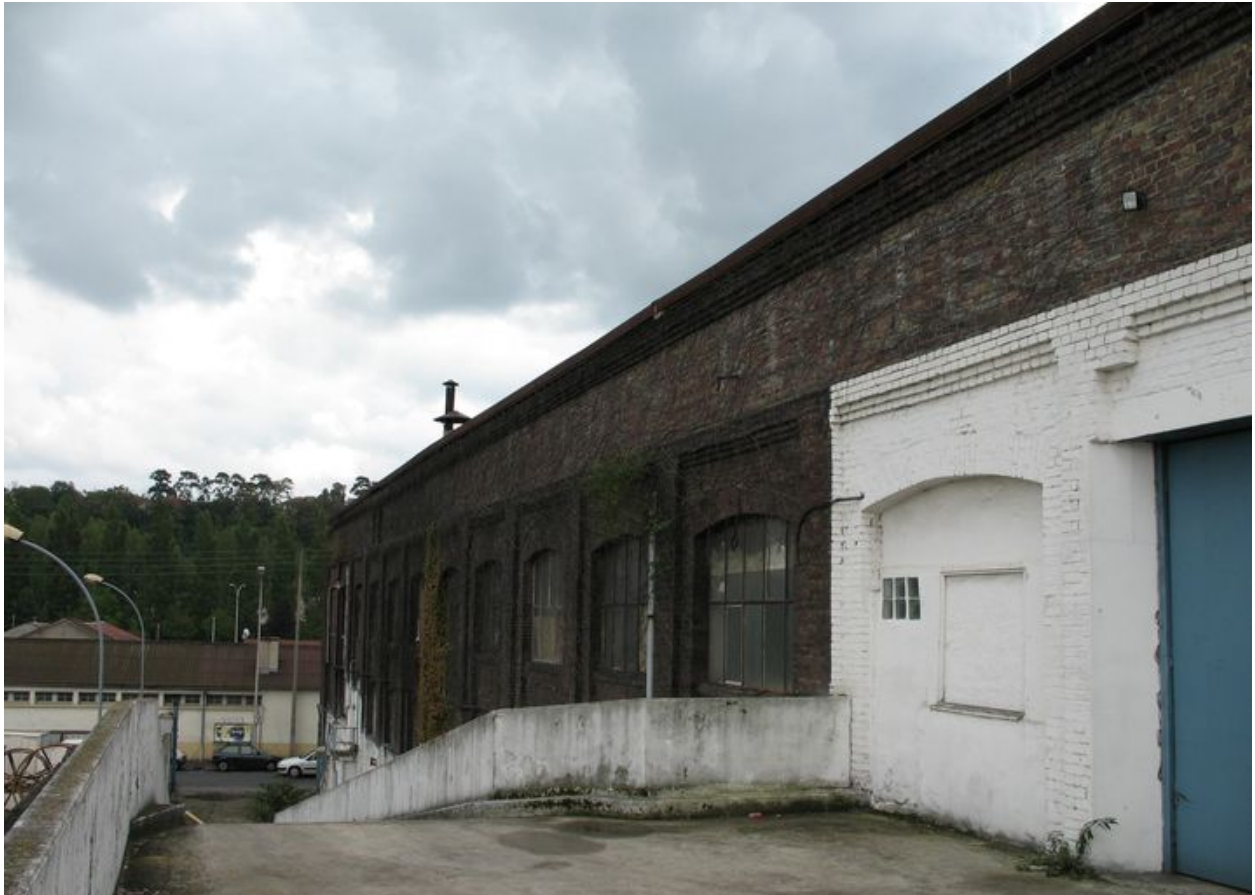
Mur est de l'usine depuis la rampe d'accès au premier étage.
