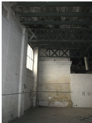
Base carrée de la cheminée au rez-de-chaussée. Phot. Clarisse Lorieux IVR22_20066005185NUCA
