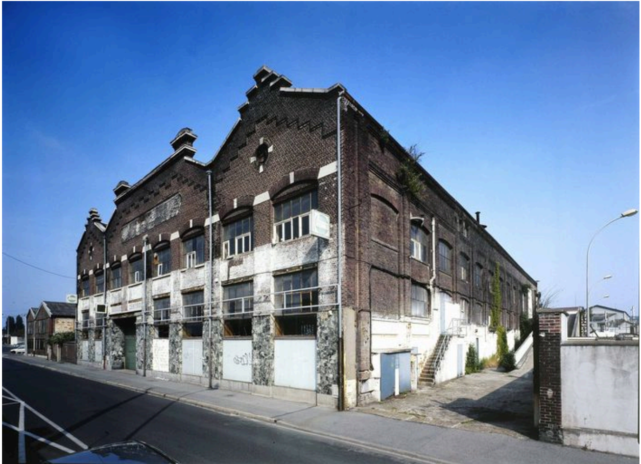
Façade principale de l'usine sur la rue Jean-Jaurès.
