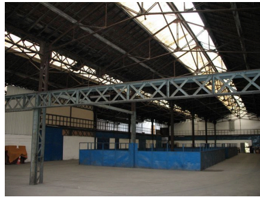
Le premier étage a conservé ses mezzanines qui abritaient les ateliers de vérification. Phot. Clarisse Lorieux IVR22_20066005192NUCA
