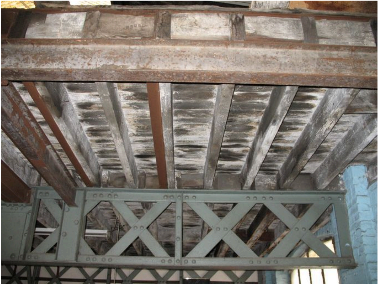
Détail du plafond en bois et des poutrelles en treillis métallique.
