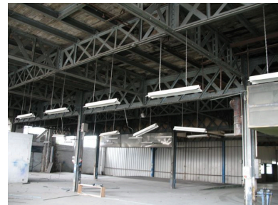
L'espace du rez-de-chaussée est divisé en travées matérialisées par des poteaux métalliques. Phot. Clarisse Lorieux IVR22_20066005183NUCA
