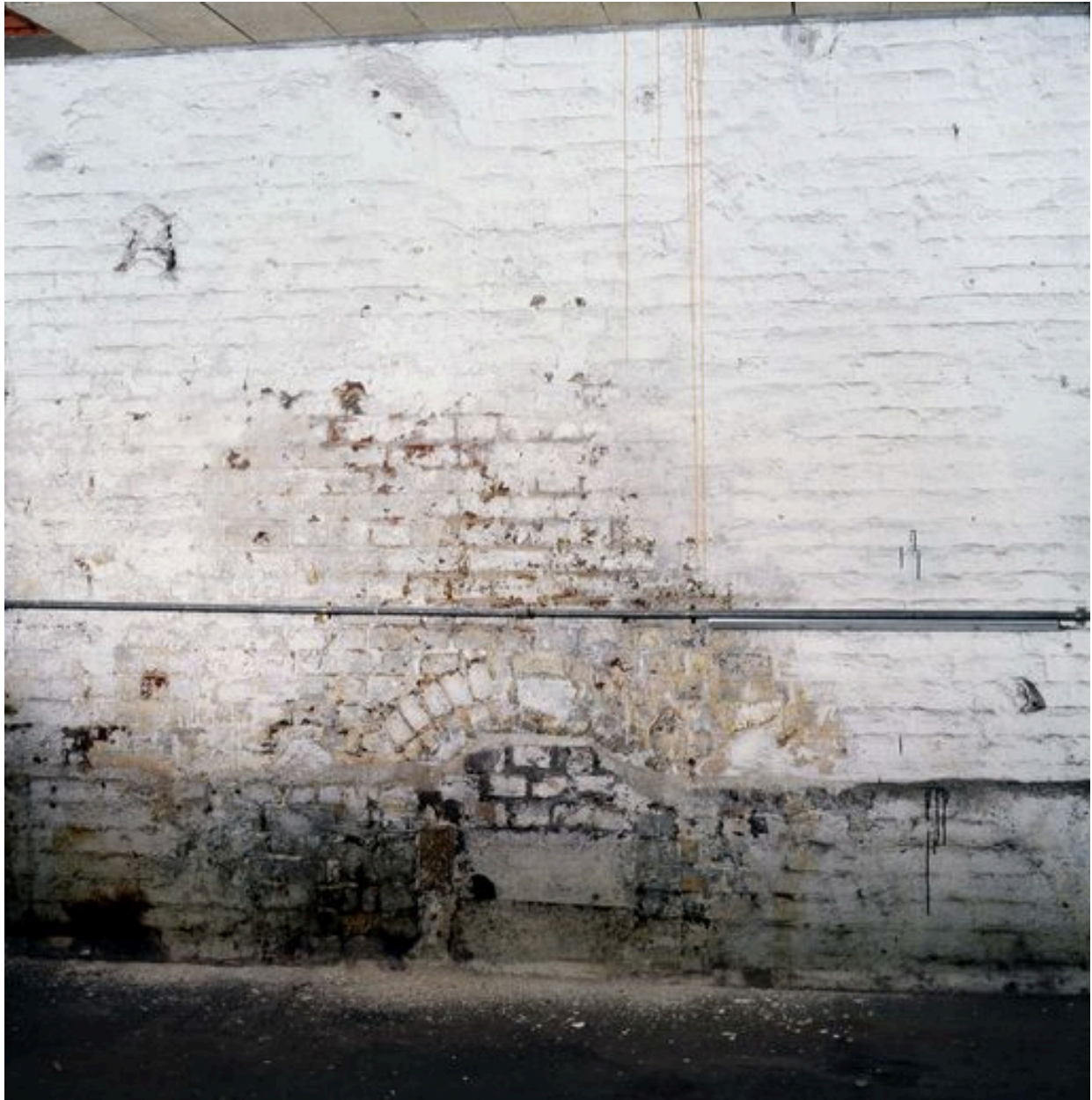
Intérieur du foyer de la cheminée.
