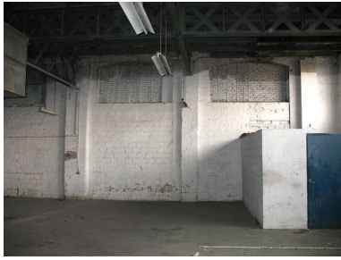
Trois travées du mur ouest de l'usine au rez-de-chaussée. Phot. Clarisse Lorieux IVR22_20066005186NUCA
