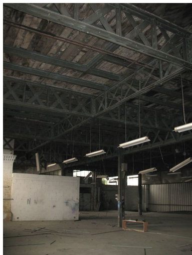
Le plafond en bois est soutenu par des poutrelles en treillis métallique. Phot. Clarisse Lorieux IVR22_20066005184NUCA
