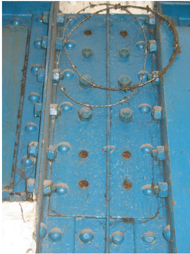
Poutrelle pleine rivetée de la structure. Phot. Clarisse Lorieux IVR22_20066005193NUCA
