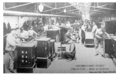
Atelier de vérification dans une mezzanine avant 1914 (AC Creil). Phot. Clarisse Lorieux IVR22_20076005007NUCAB
