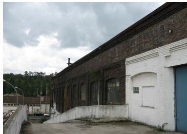
Mur est de l'usine depuis la rampe d'accès au premier étage. Phot. Clarisse Lorieux IVR22_20066005181NUCA
