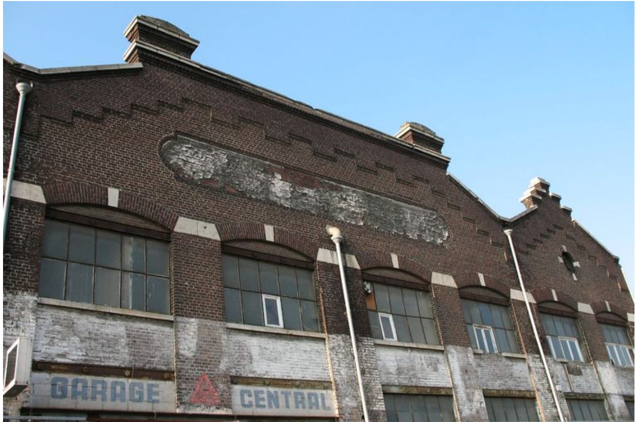
Le mur pignon sur la rue Jean-Jaurès.
