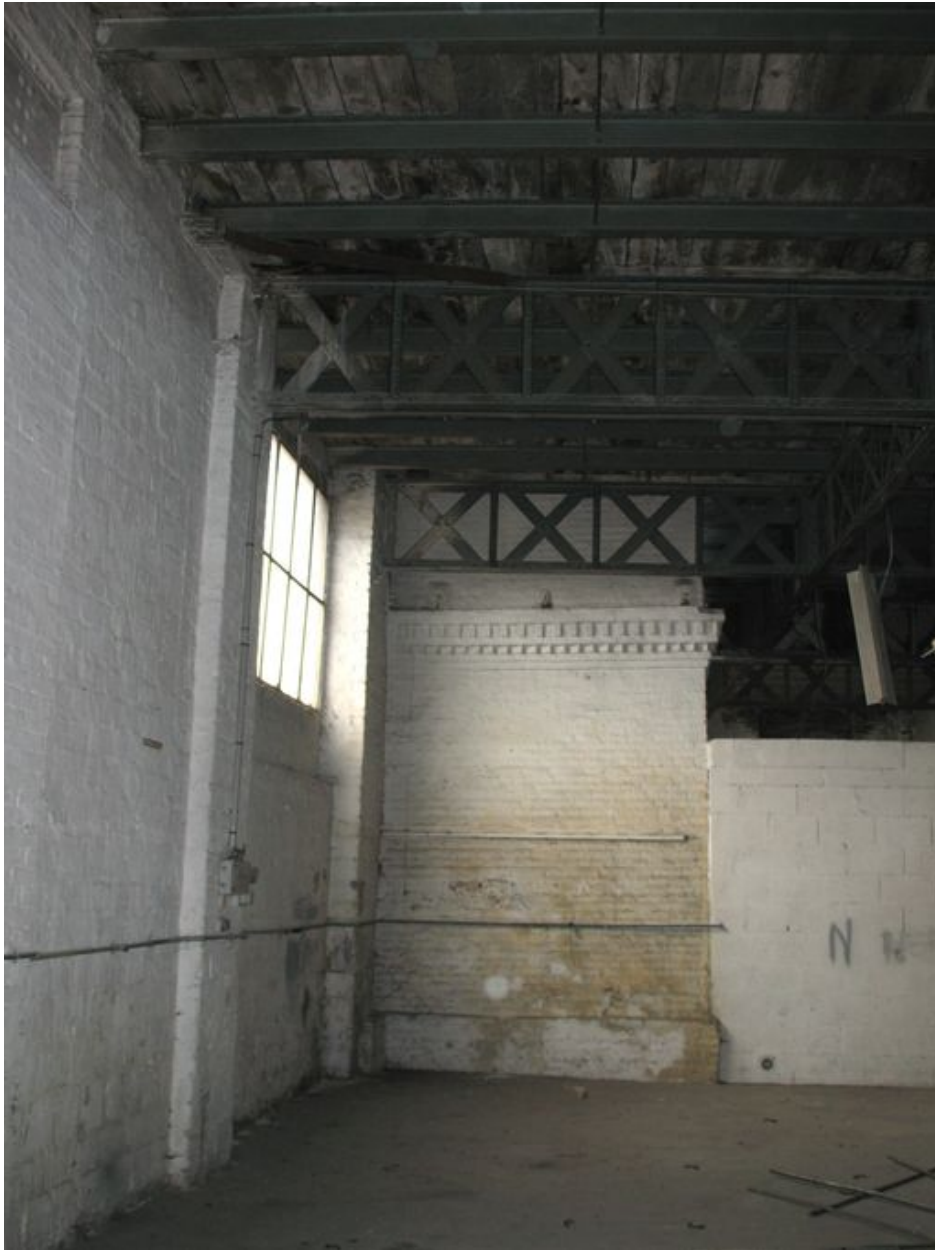
Base carrée de la cheminée au rez-de-chaussée.
