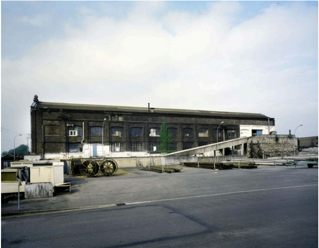
Façade est de l'usine Fichet.
