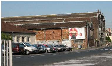
Vue générale de l'usine de coffres-forts depuis l'impasse de la Verrerie. Phot. Clarisse Lorieux IVR22_20066005176NUCA
