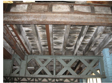
Détail du plafond en bois et des poutrelles en treillis métallique. Phot. Clarisse Lorieux IVR22_20066005194NUCA
