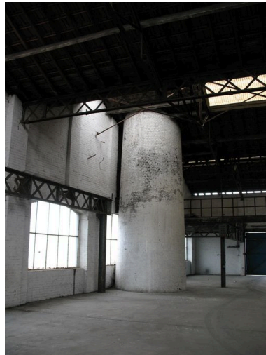
Partie tronconique de la cheminée au premier étage de l'usine. Phot. Clarisse Lorieux IVR22_20066005209NUCA
