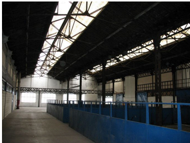
Vue générale du premier étage de l'usine. Phot. Clarisse Lorieux IVR22_20066005208NUCA
