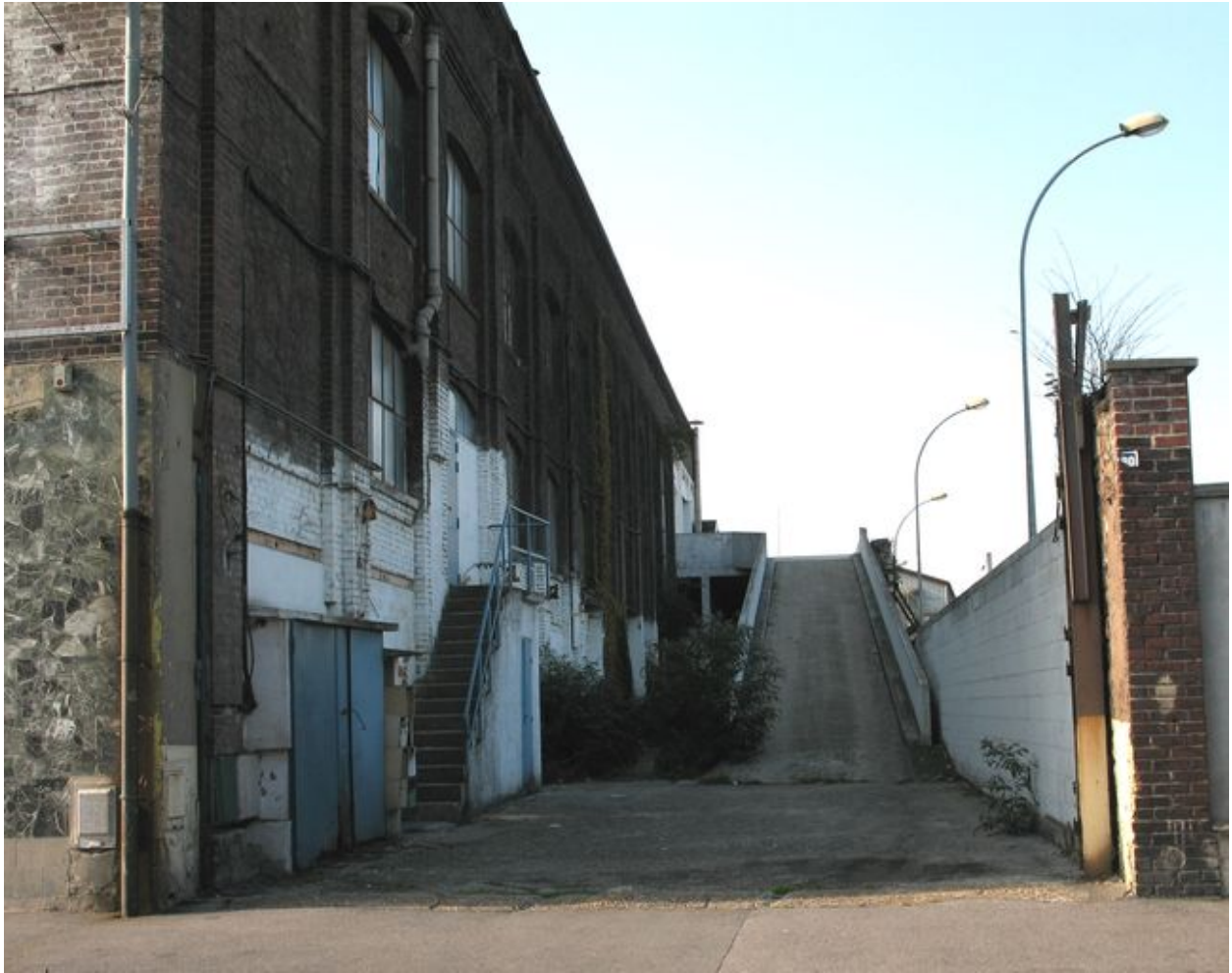
Façade est de l'usine et rampe d'accès construite pour l'utilité du garage automobile.
