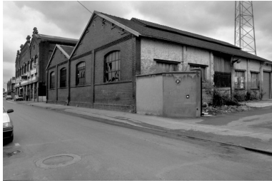
L'usine de coffres-forts Fichet et deux ateliers de fabrication de l'usine à gaz en 1992. Phot. Benoît Dufournier IVR22_19926000219Z
