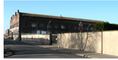
L'usine Fichet depuis la rue du Port. Phot. Clarisse Lorieux IVR22_20076005044NUCA
