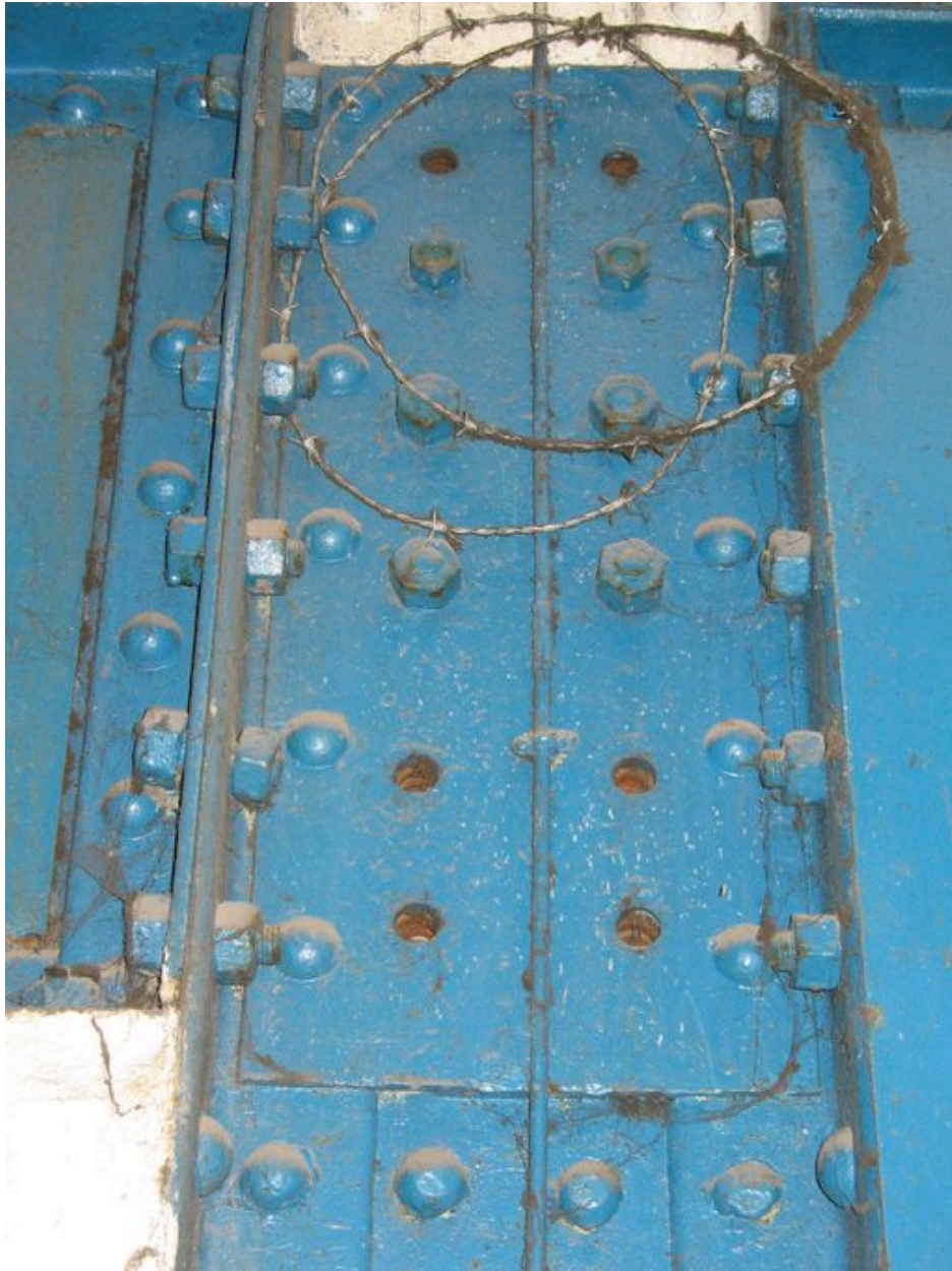
Poutrelle pleine rivetée de la structure.
