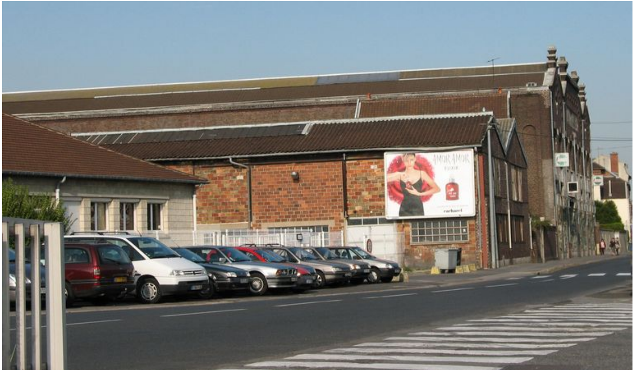
Vue générale de l'usine de coffres-forts depuis l'impasse de la Verrerie.
