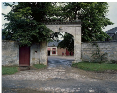
Portail sur rue. Phot. Jean-Michel Périn IVR22_19856000713XA
