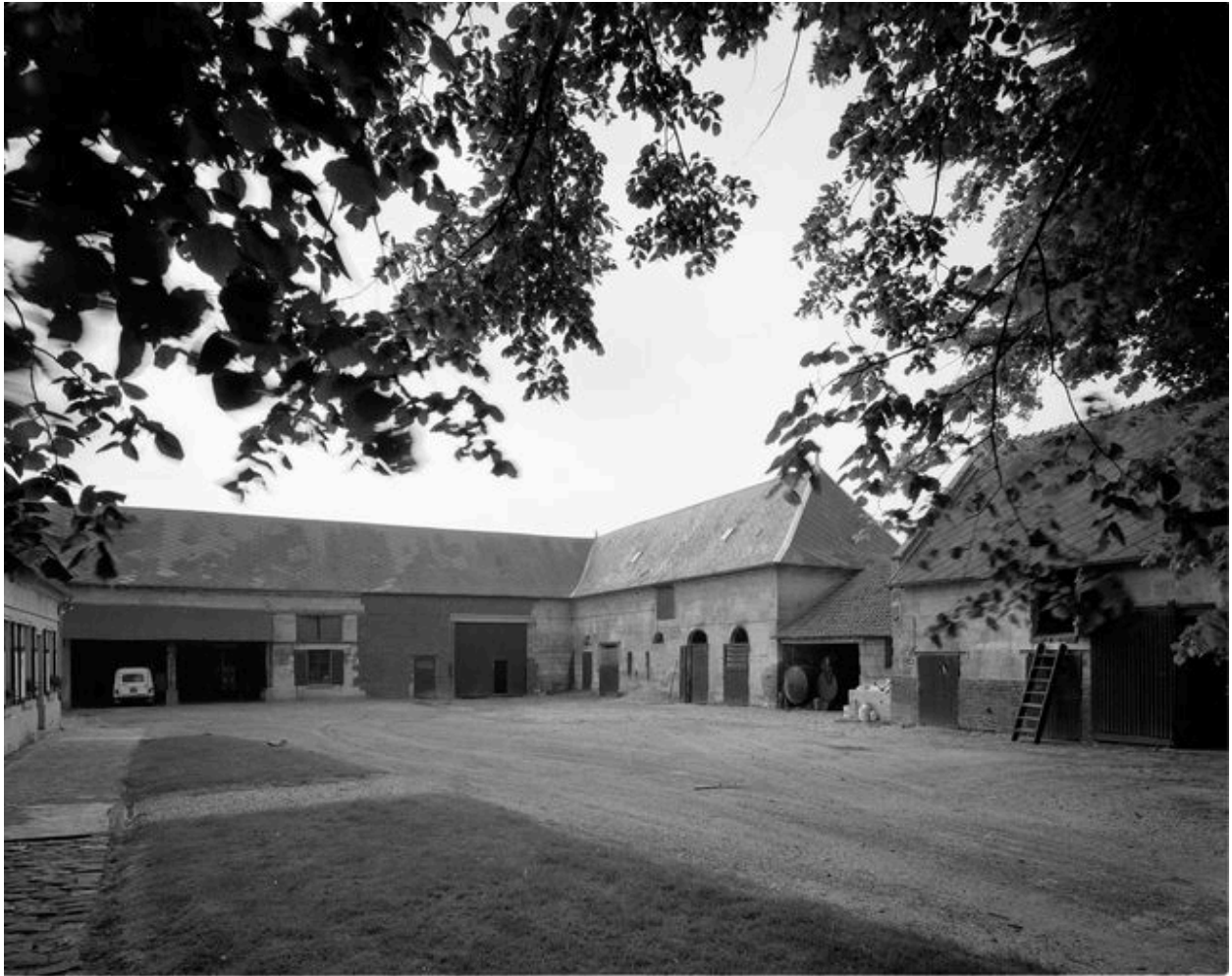
Bâtiments sur cour.
