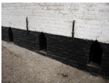
Détail des ouvertures de la cave pratiquées dans le solin du bâtiment sur rue. Phot. Inès Guérin IVR22_20058005037NUCA
