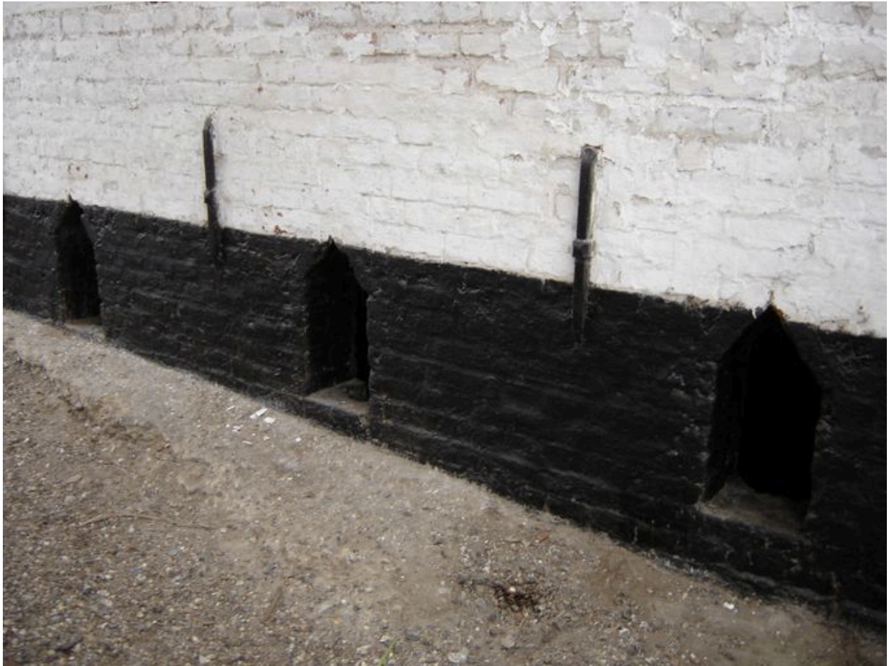
Détail des ouvertures de la cave pratiquées dans le solin du bâtiment sur rue.
