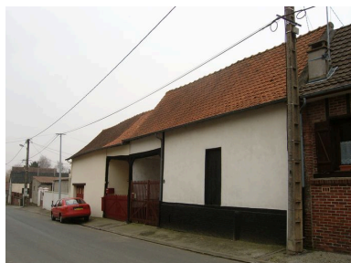
Vue générale. Phot. Inès Guérin IVR22_20058005035NUCA
