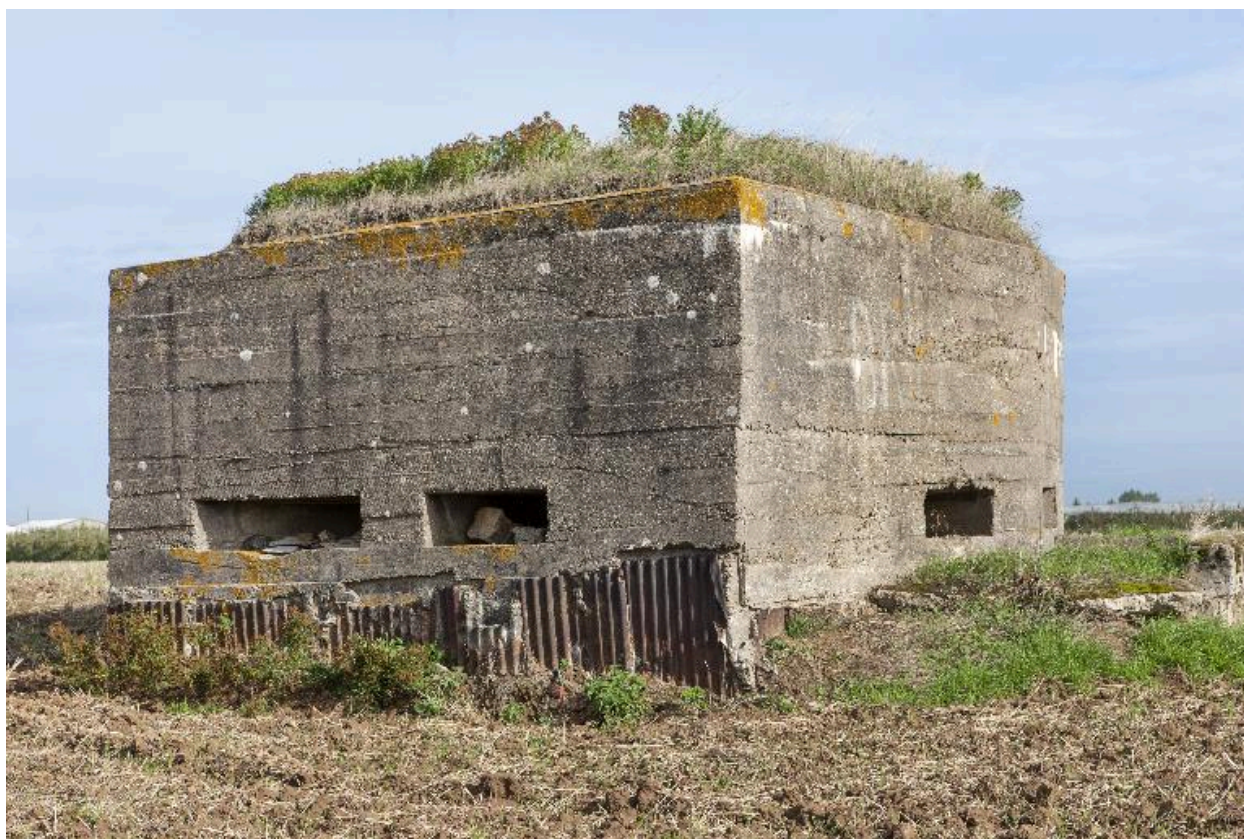
Vue de trois-quarts vers le nord-ouest
