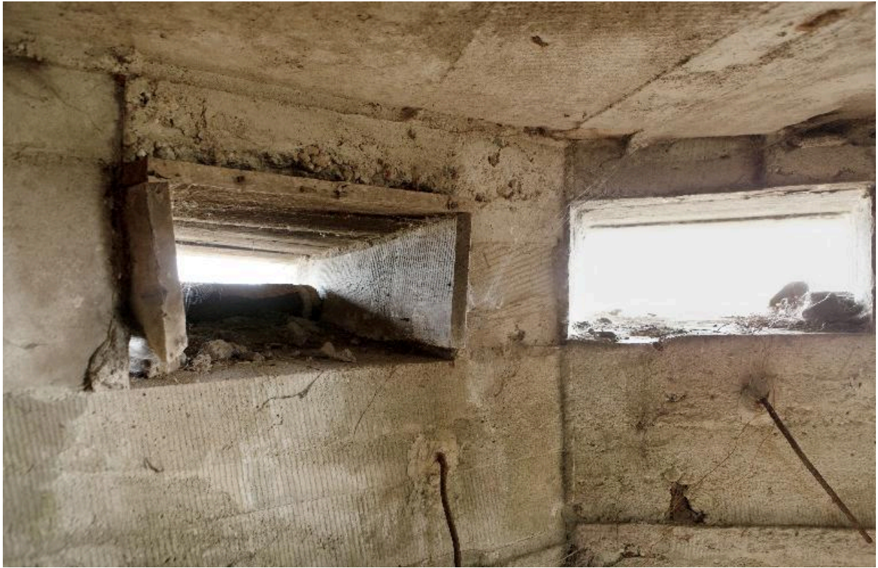
Détail de coffrage dans une des embrasures
