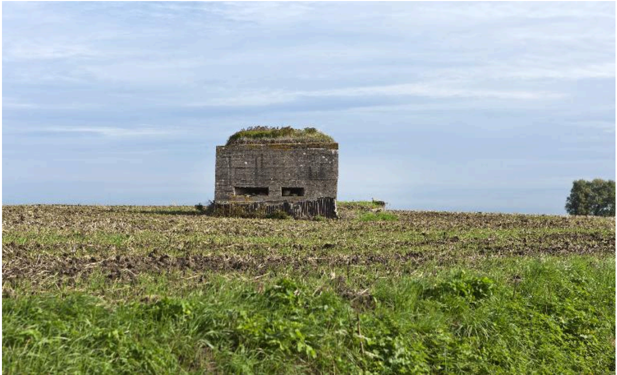
Elévation sud depuis la route
