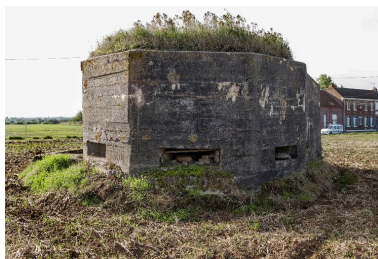
Vue de trois-quarts vers le sud-est Phot. Jean-Marc Ramette IVR31_20145905215NUCA
