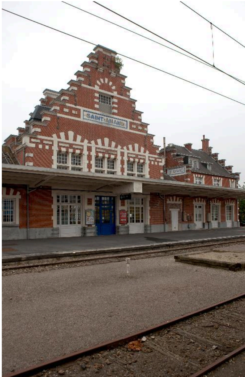
Vue générale de l'élévation postérieure.
