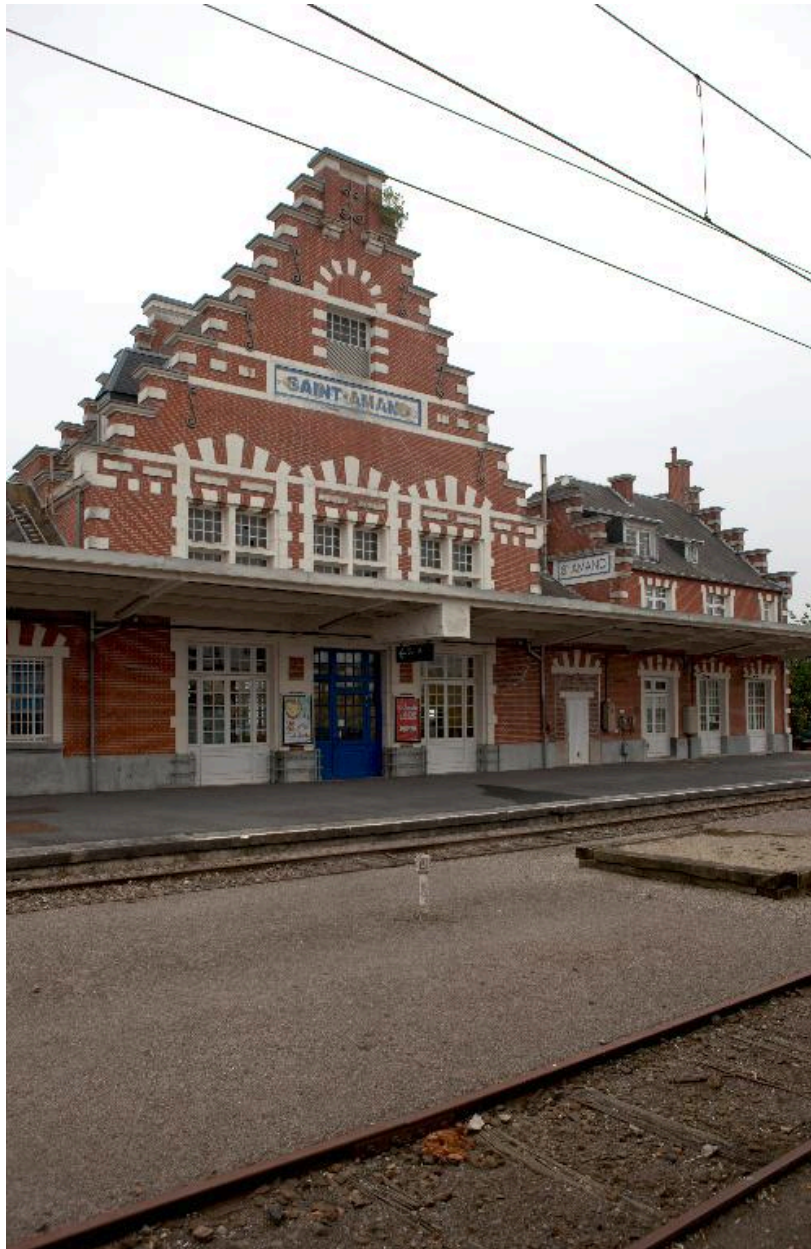
Vue générale de l'élévation postérieure.
