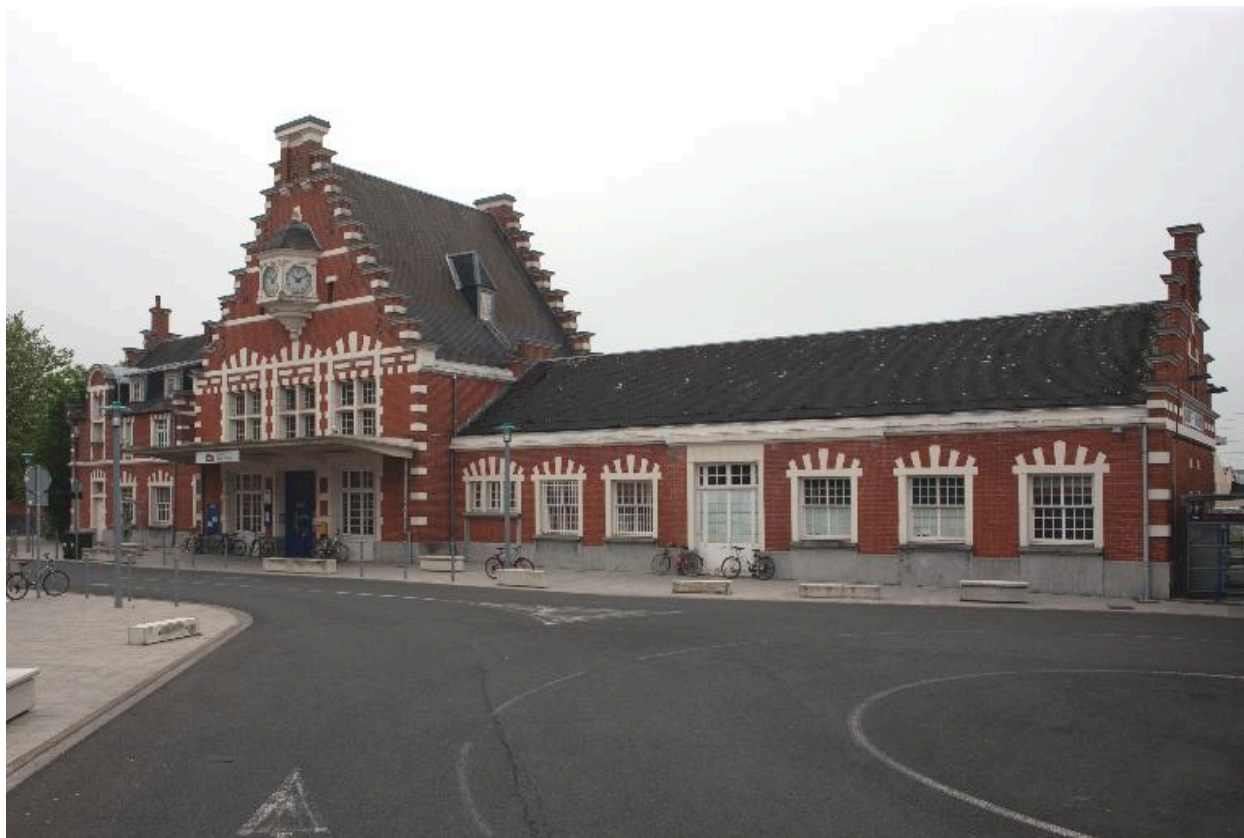
Vue générale de l'élévation antérieure de la gare.
