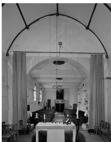
Vue intérieure, depuis le chœur. Phot. Thierry Lefébure IVR22_19950202799V
