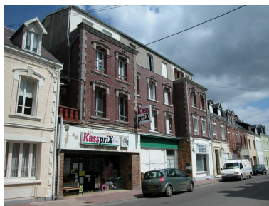
Vue d'ensemble de l'ancien hôtel. Phot. Elisabeth Justome IVR22_20058003066NUCA
