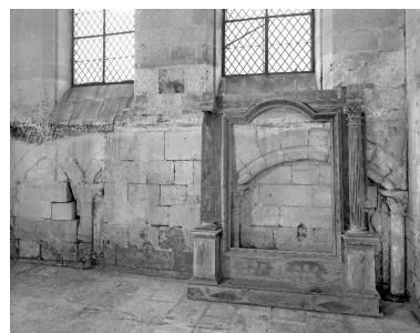
Détail du mur sud de la chapelle sud du chœur : arcades murées et enfeu. Phot. Thierry Lefébure IVR22_20010202988V
