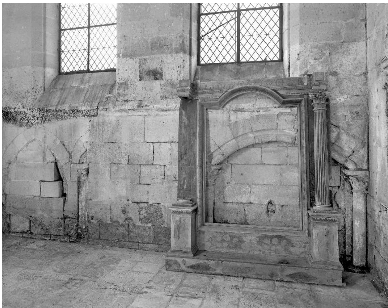
Détail du mur sud de la chapelle sud du chœur : arcades murées et enfeu.
