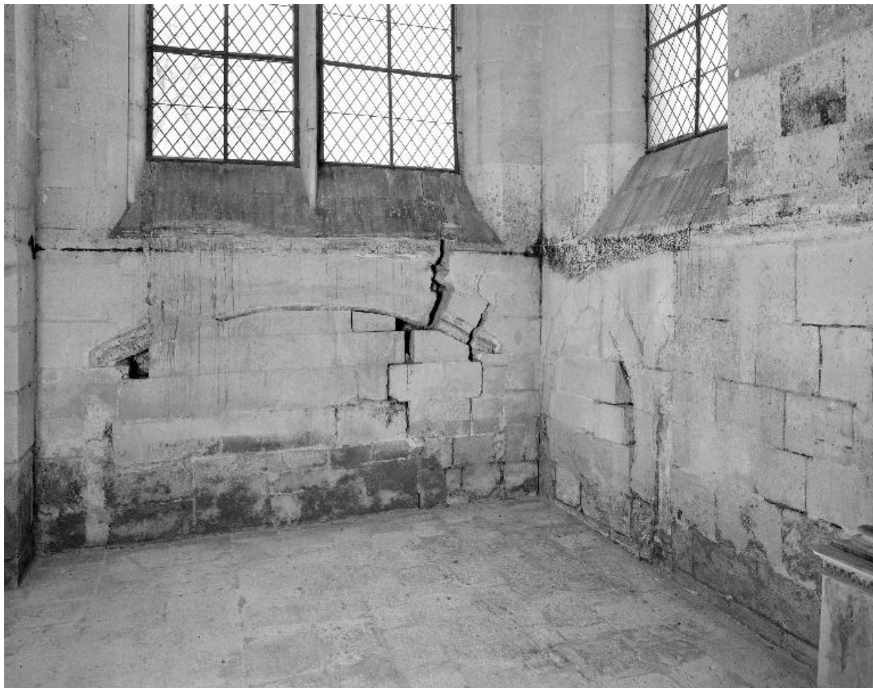
Détail des murs est et sud de la chapelle sud du chœur : enfeu et arcades murés.
