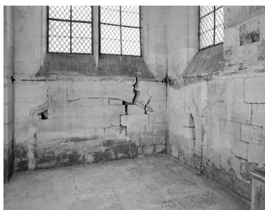
Détail des murs est et sud de la chapelle sud du chœur : enfeu et arcades murés. Phot. Thierry Lefébure IVR22_20010202987V
