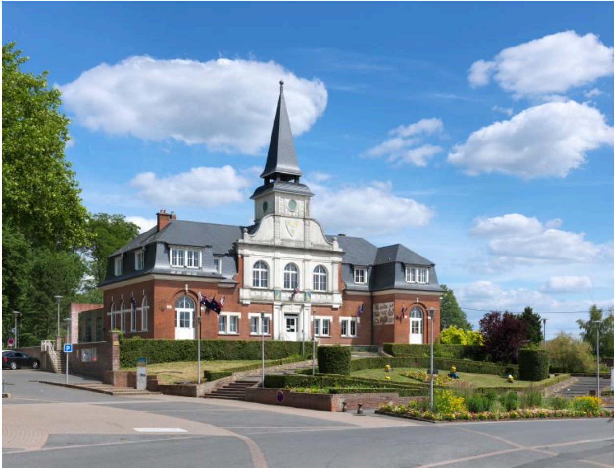
Vue générale, depuis le nord-ouest.
