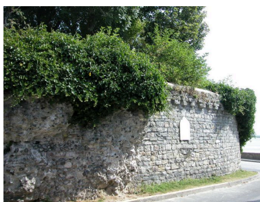
Le mur de clôture de la propriété Millevoye, rue du Château, où est apposée une plaque en souvenir de Jeanne-d'Arc. Phot. Elisabeth Justome IVR22_20058003751NUCA
