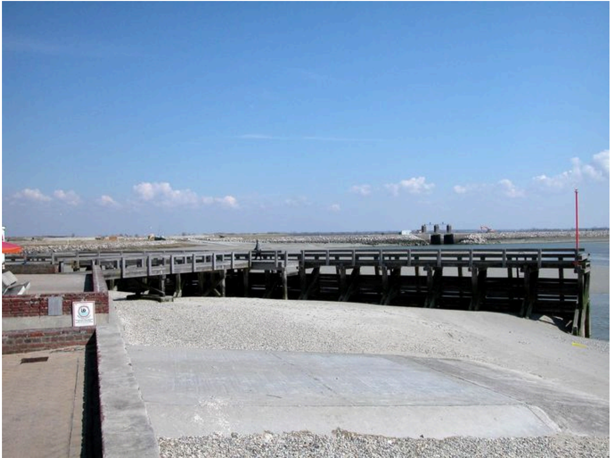
Les actuelles estacades du port et l'écluse du bassin de chasse au second plan.
