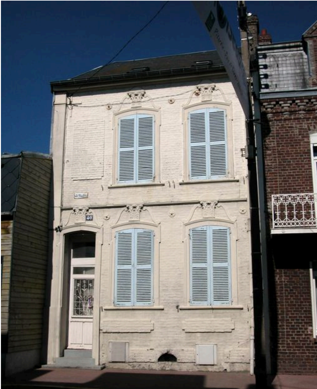
Maison dite Les Tilleuls, 40 rue de la Porte-du-Pont (1985 AR 108).
