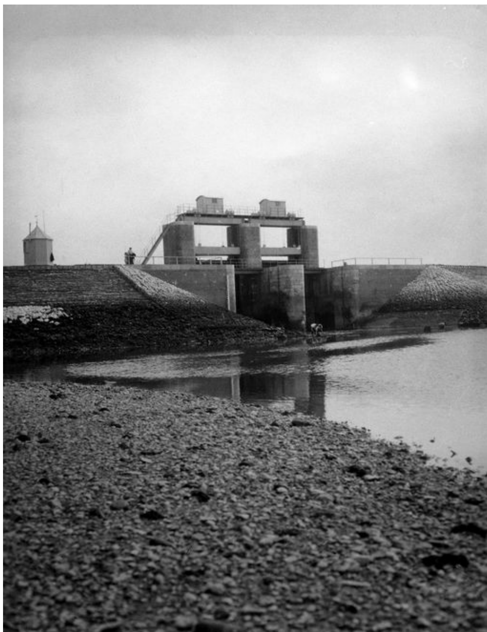
Les écluses du bassin de chasse, photographie noir et blanc, [1903] (coll. part.).
