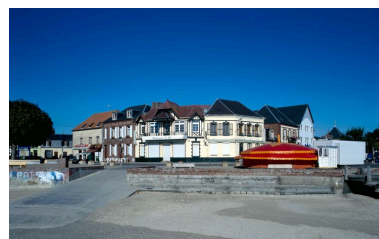
Les maisons à l'angle du Quai Amiral-Courbet et de la place Jeanne-d'Arc. Phot. Marie-Laure Monnehay-Vulliet IVR22_20038001022XA
