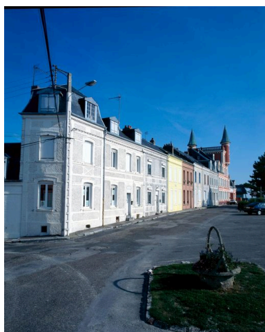
Le lotissement de la rue Pierre Guerlain. Phot. Marie-Laure Monnehay-Vulliet IVR22_20038001032XA
