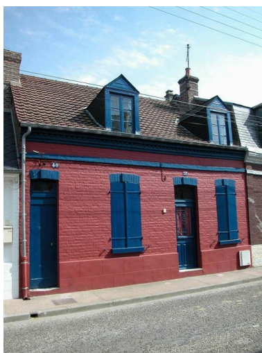
Maison de pêcheur à deux logements, 38 et 40 rue de la Prison-Jeanne-d'Arc. Phot. Elisabeth Justome IVR22_20058003748NUCA
