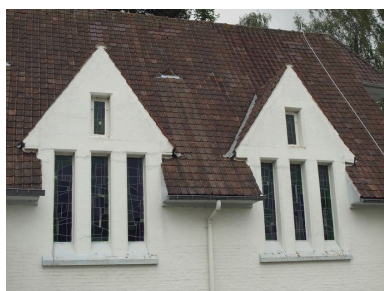
Chapelle : détail des fenêtres latérales Phot. Bruno Decrock IVR31_20106208252NUCA
