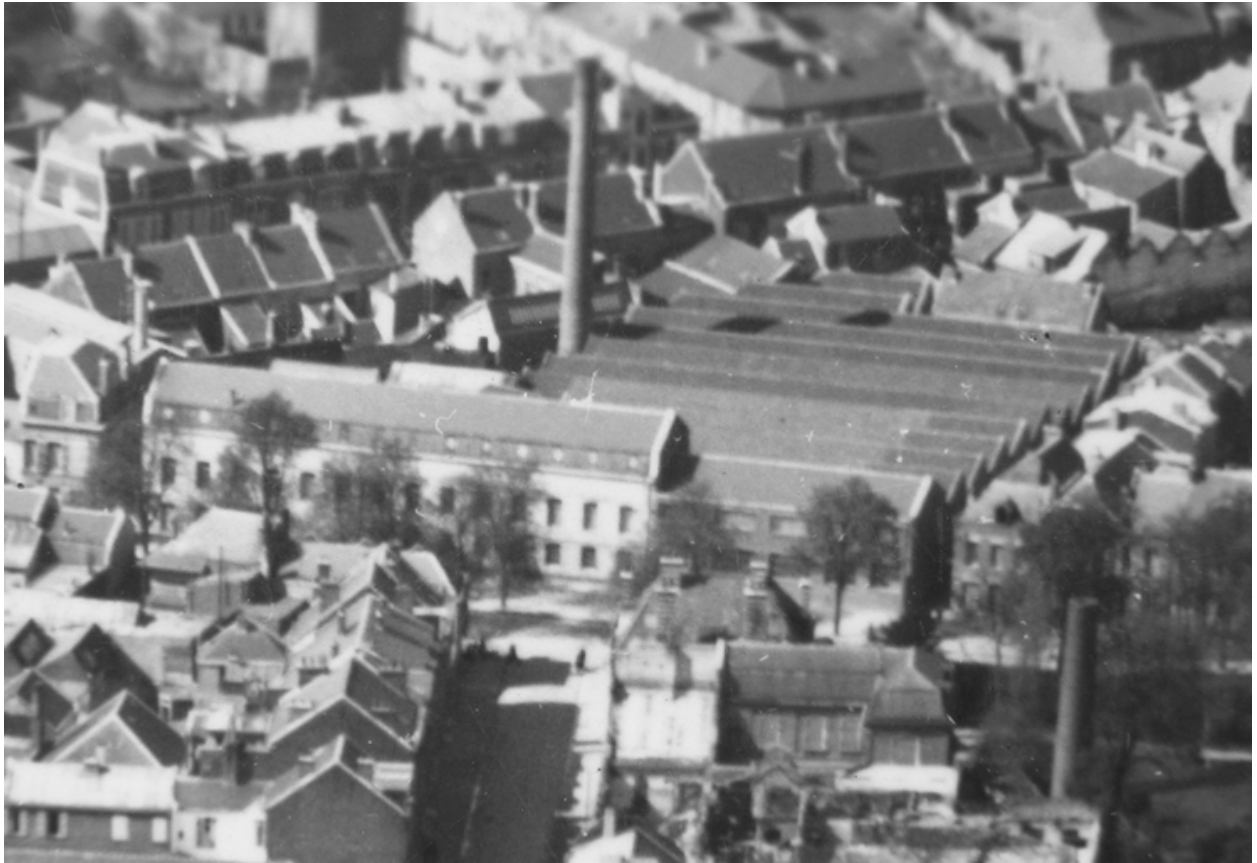
Vue du site vers 1933-1936.
