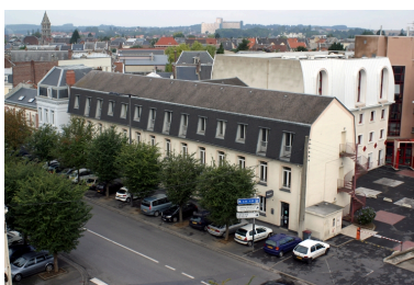
Le site de l'ancien tissage vu du sud-est : vestiges de la filature (au premier plan) et du logement patronal (dans le prolongement). Phot. Frédéric Pillet IVR22_20040200638NUCA
