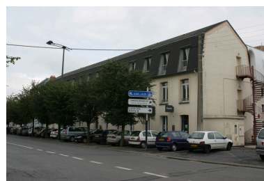
Façade antérieure de l'ancienne filature. Phot. Frédéric Pillet IVR22_20040200639NUCA
