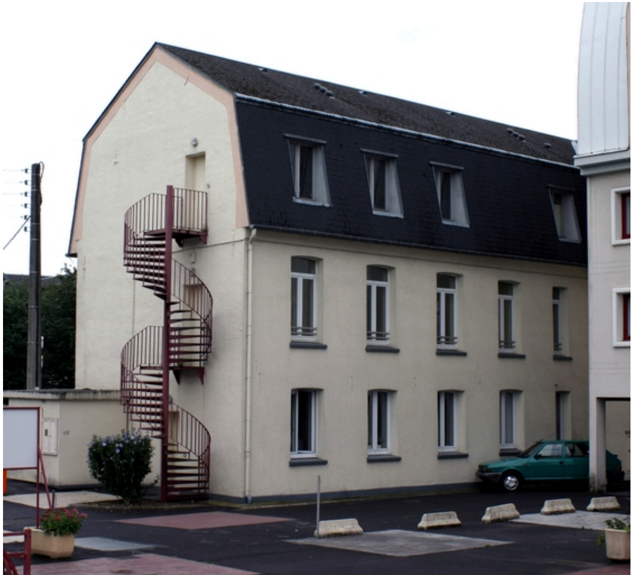
Façade postérieure et pignon est de l'ancienne filature.
