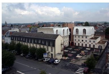
Le site de l'ancien tissage vu du sud-est. Phot. Frédéric Pillet IVR22_20040200637NUCA
