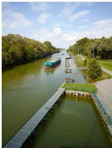
Vue en aval de l'écluse. Estacade de guidage, passerelle métallique, bassin de tranquillisation.
