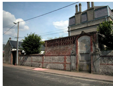
Vue d'ensemble depuis la rue. Phot. Elisabeth Justome IVR22_20058002585NUCA
