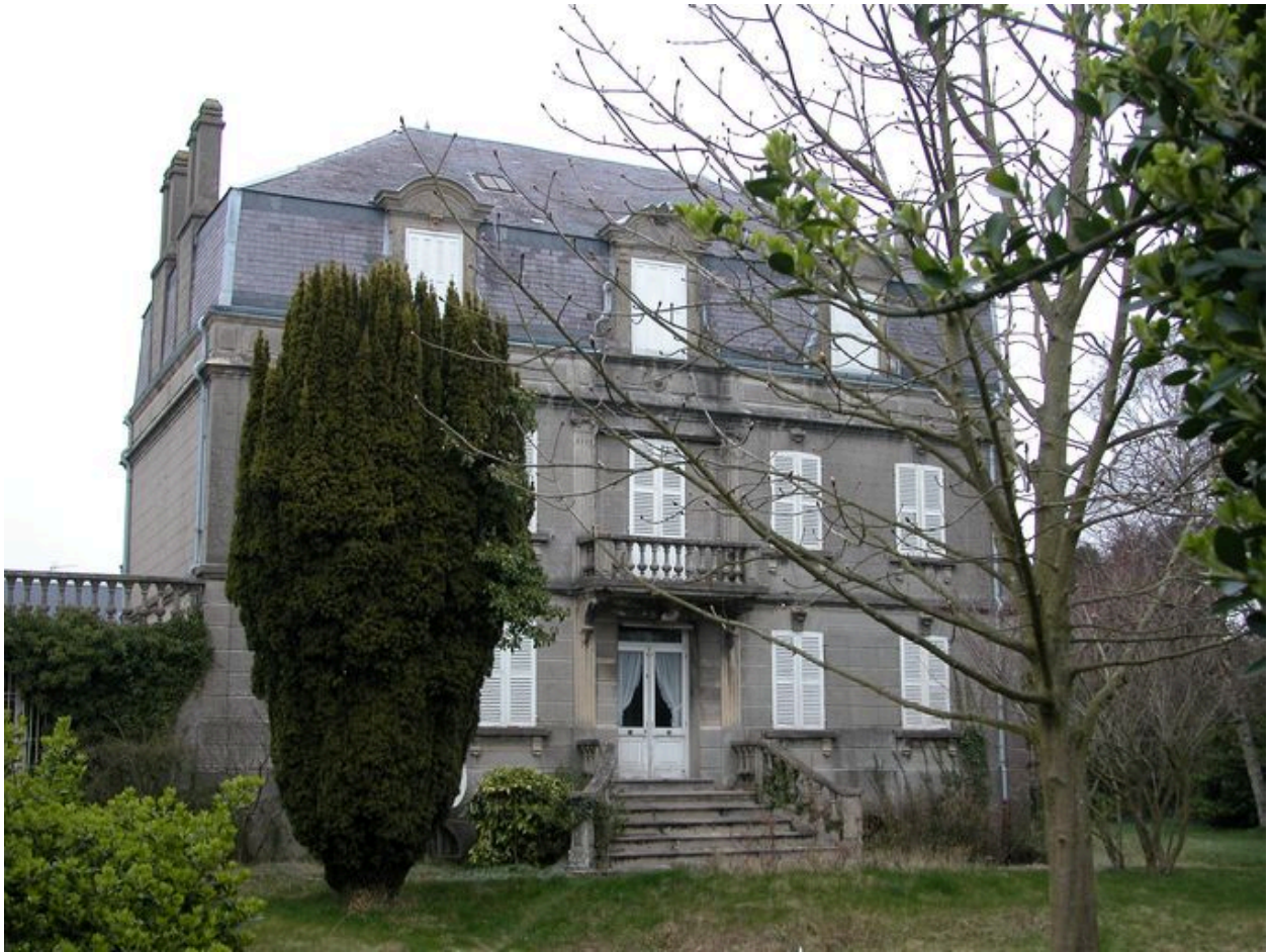
Elévation antérieure, vue rapprochée.
