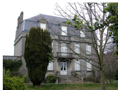
Elévation antérieure, vue rapprochée.
