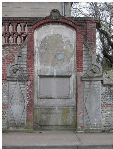
Détail du mur de clôture où se situait le bas-relief de Florentin Lefils. Phot. Elisabeth Justome IVR22_20058002586NUCA
