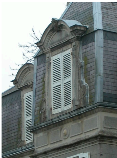
Détail d'une fenêtre de lucarne. Phot. Elisabeth Justome IVR22_20058002587NUCA
